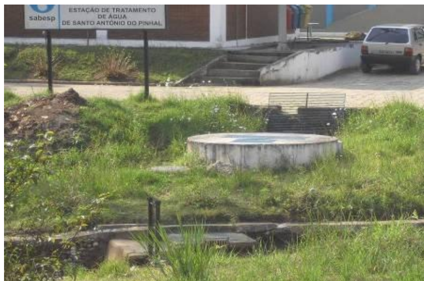
Foto 01 - Captação de Água Bruta – Ribeirão da Prata.
