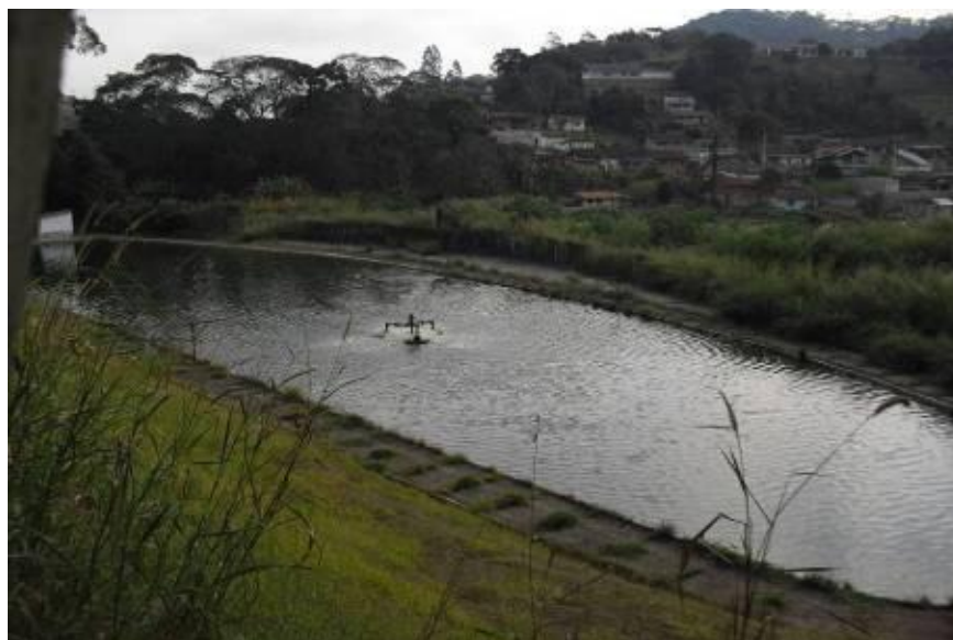
Foto 06 - Lagoa Facultativa Aerada.
