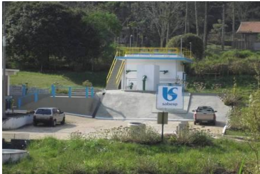
Foto 02 - Módulo de Tratamento da ETA Sede.
