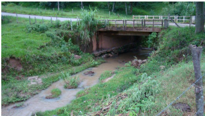
Foto 4.2-3: Vista da ponte sobre a Rua da Estaçãozinha sobre o Córrego do Monjolinho.
