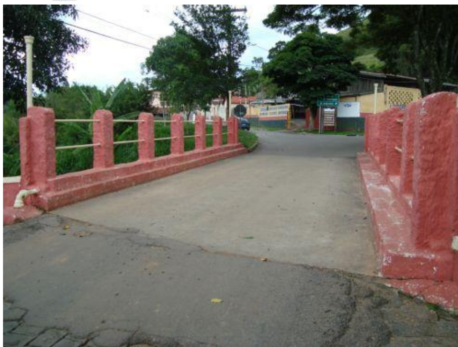
Foto 4.2-23: Ponte da Rua Alferes Pedrosa
