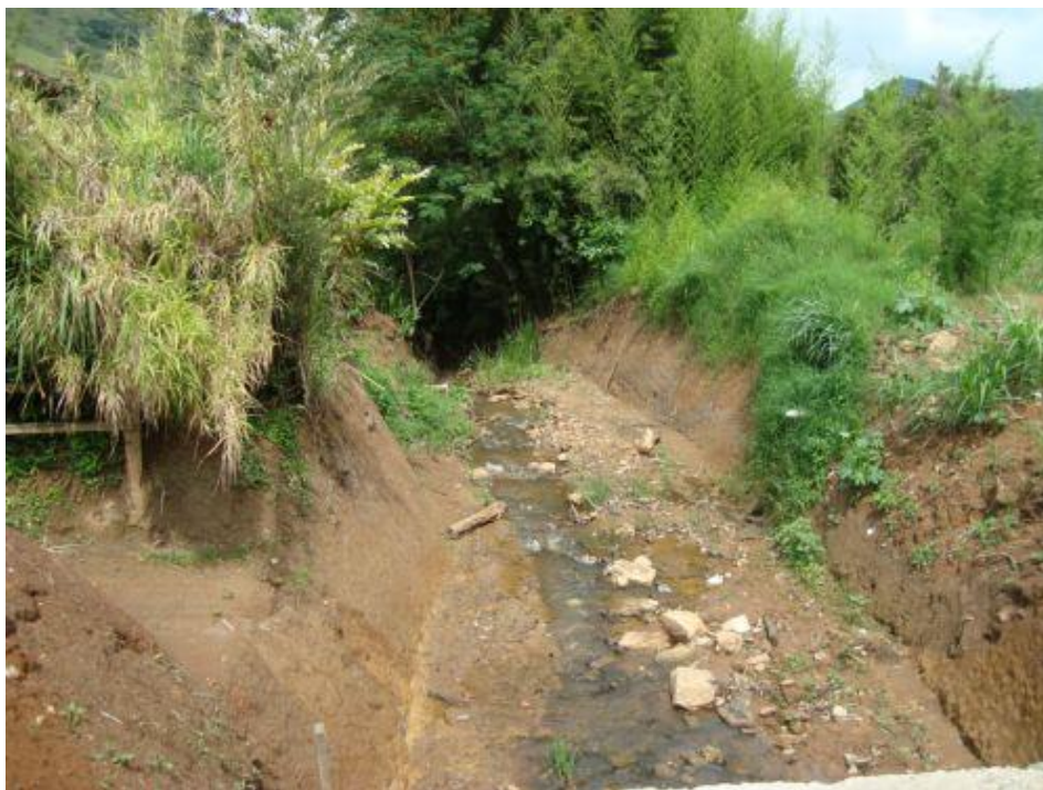
Foto 4.2-11: Córrego Campo do Monteiro – Vista para jusante da Rua da Estaçãozinha.
