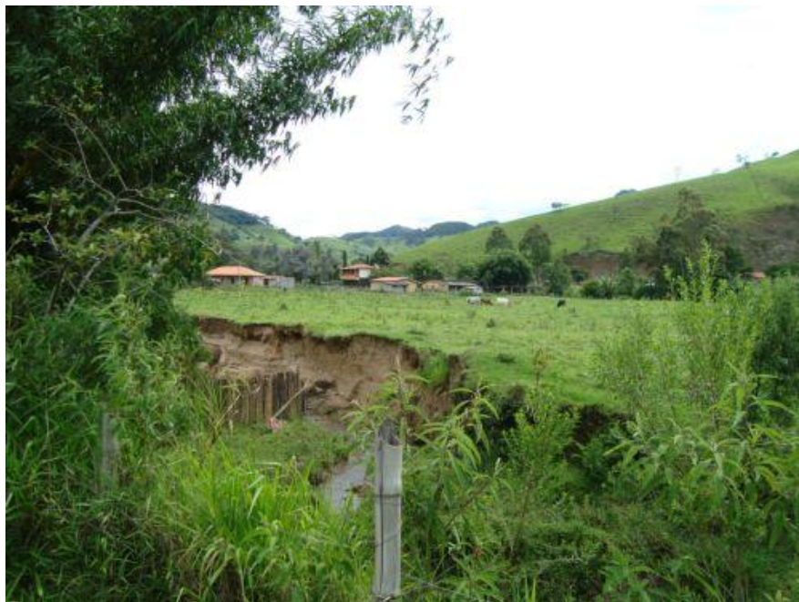
Foto 4.2-6: Vista para montante a partir do ponto onde o Córrego do Monjolinho recebe a afluição do Córrego Campo do Monteiro.
