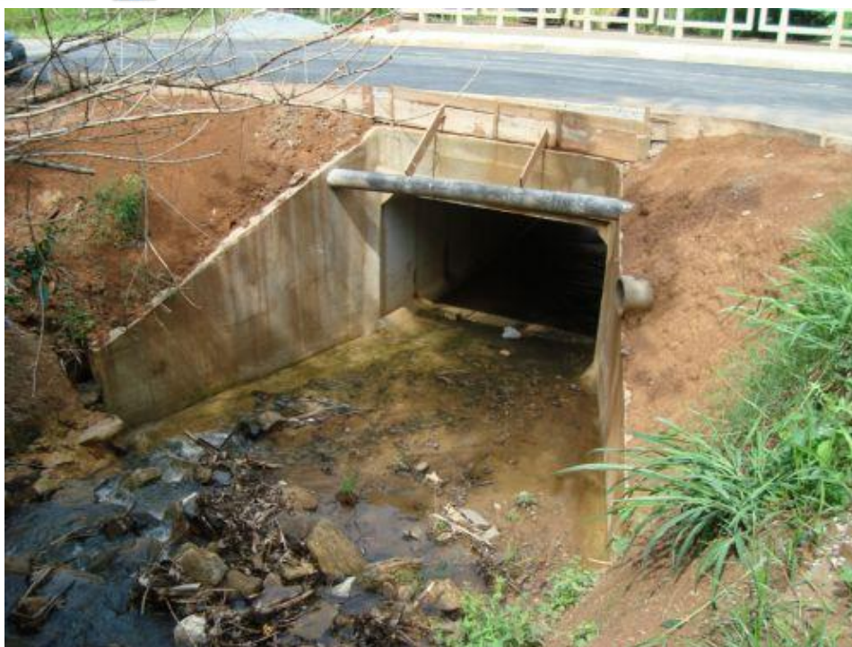
Foto 4.2-10: Córrego Campo do Monteiro - Passagem sob a Rua da Estaçãozinha.
