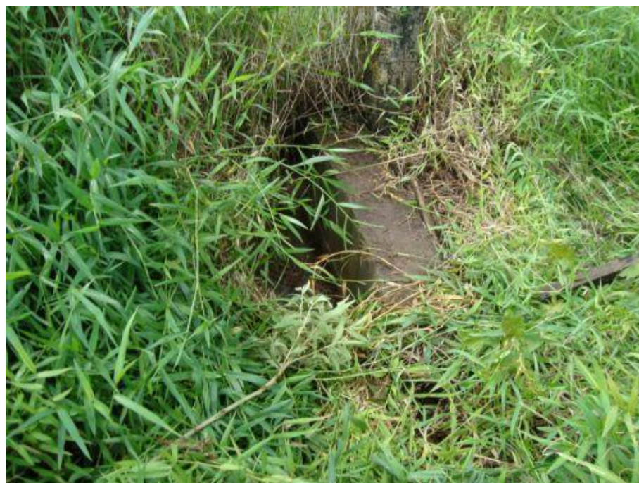
Foto 4.2-13: Passagem de diâmetro Ø0,60m sob a Rodovia Júlio da Silva
