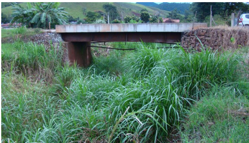
Foto 4.2-4: Córrego do Monjolinho – ponte da Rua Projetada “10” com vista para jusante
