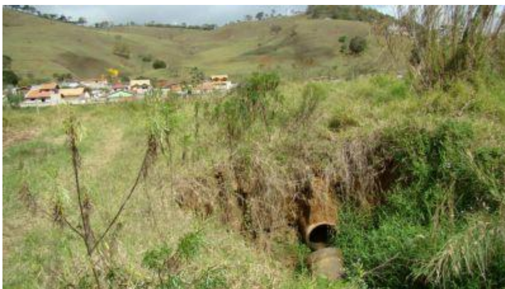
Foto 4.2-27: Tubo de concreto sob rua sem nome de diâmetro Ø0,80 m com vista para montante.
