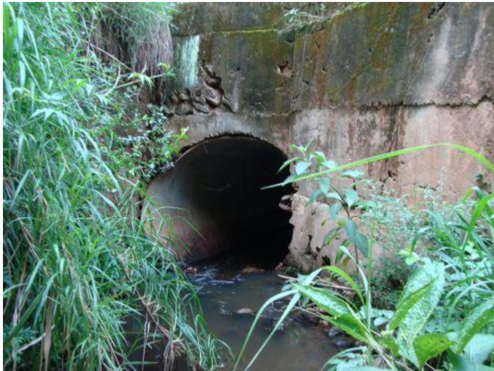
Foto 4.2-1: vista de montante da passagem sob a Estrada do Barão dos Sítios – Galeria de aço corrugado de diâmetro Ø2,80 m.
