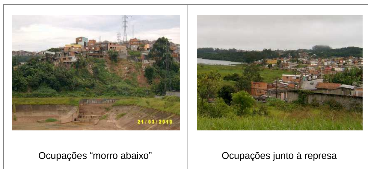
Figura 87 – Duas situações onde é difícil esgotar
