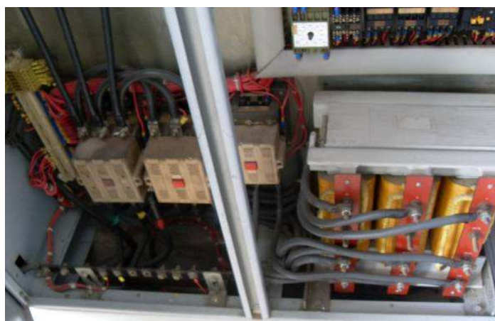
Figura 183 - Acionamento com Chave Compensadora
