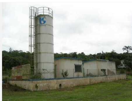
Bairro Santa Cruz – Poço com tratamento para remoção de ferro e manganês
