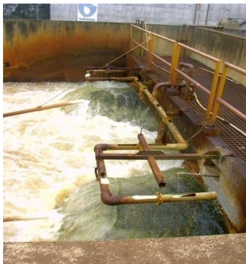
Figura 59 – Detalhe da vista geral da unidade de mistura rápida em operação na ETA Rio Grande.
