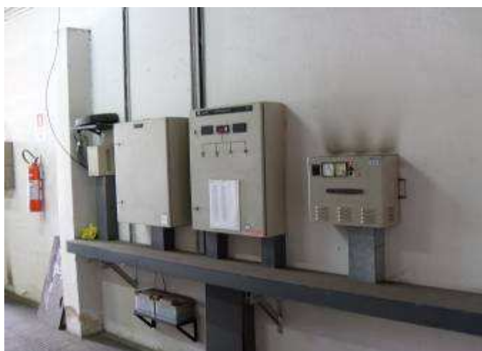
Figura 173 - Acima: Painel de Controle, Entrada em 440 V e Acionamentos dos Conjuntos de 200 CV. Abaixo: Quadros Auxiliares e de Controle
