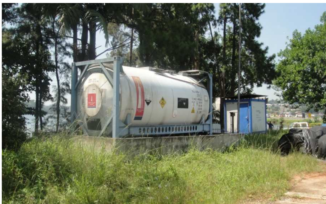
Figura 40 - Vista geral do sistema de estocagem de peróxido de hidrogênio instalado junto à captação de água bruta - Reservatório do Rio Grande
