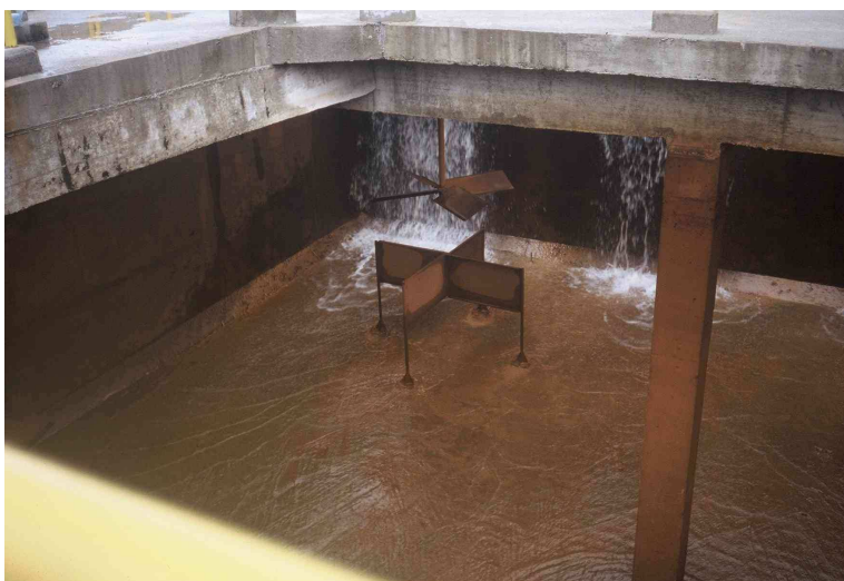
Figura 67 – Detalhe dos floculadores que compõem a “Ala Nova”
