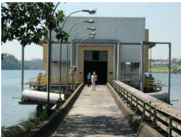
Figura 129 - Estação Elevatória/Casa de Bombas
