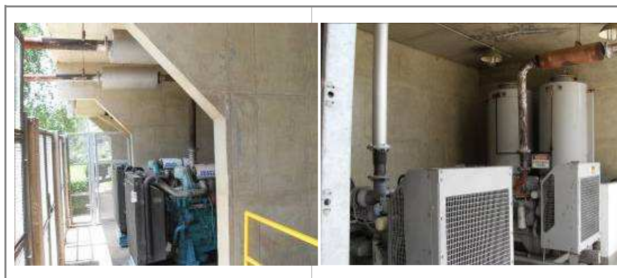
Figura 144 - Geradores de 400 kVA (esquerda) e 230 kVA (direita)
