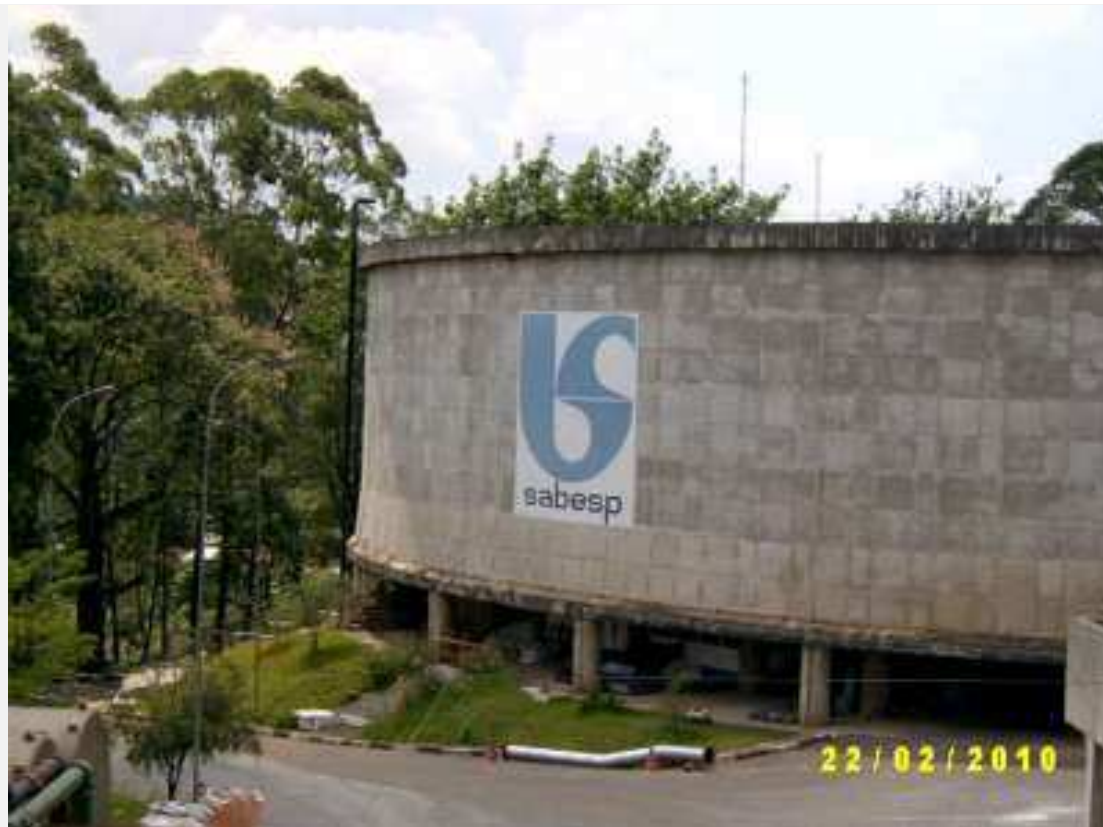
Vista do Reservatório Principal
