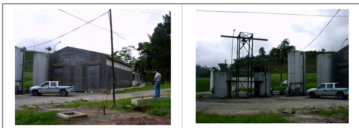
Figura 57 - Vista geral do sistema de preparo e dosagem de suspensão de CAP e solução de permanganato de potássio instalado junto à captação da ETA Rio Grande
