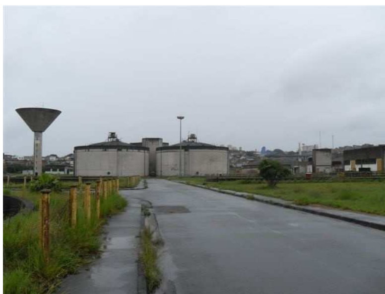
Figura 97 - Vista dos digestores anaeróbios da ETE ABC
