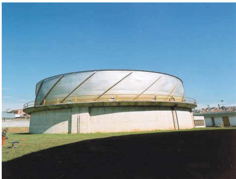
Figura 98 - Vista do gasômetro da ETE ABC
