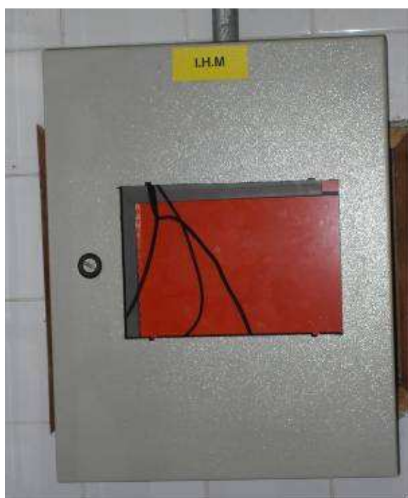
Figura 152 – Interface Homem-Máquina (Danificada)
