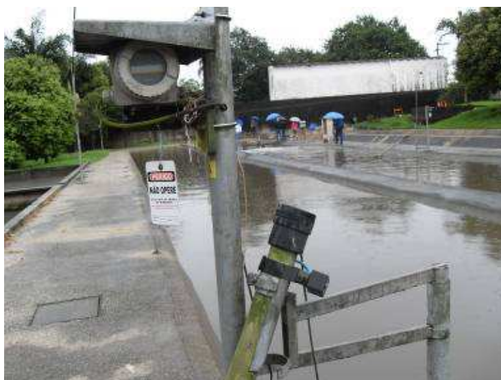
Figura 154 - Oxímetro Danificado
