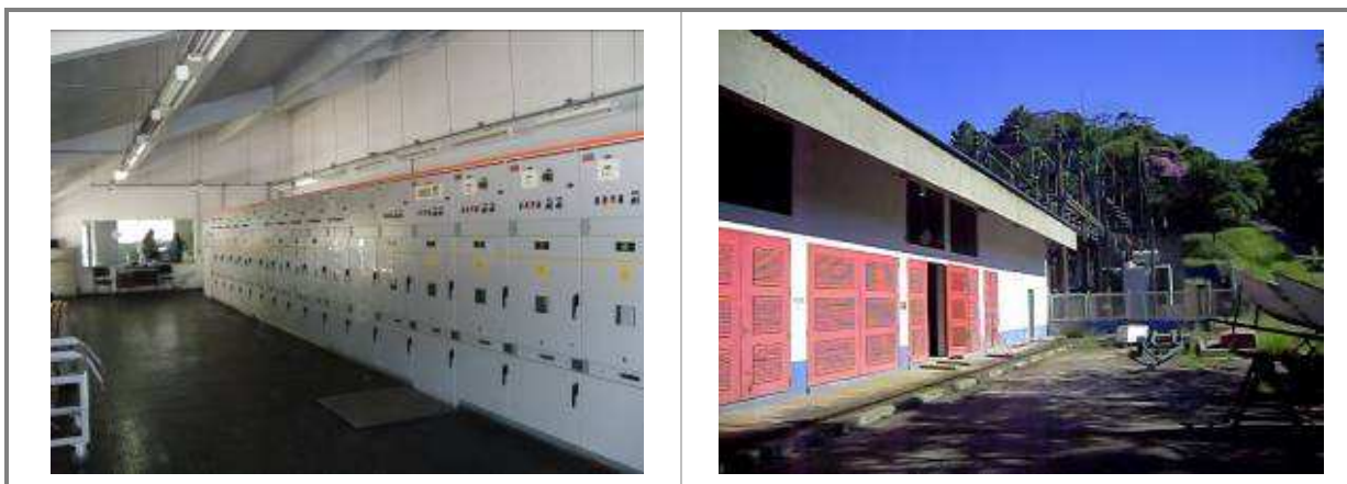
Figura 123 - Sala dos Cubículos de Distribuição 13,8 kV e Vista Externa da Sala de Trafos
