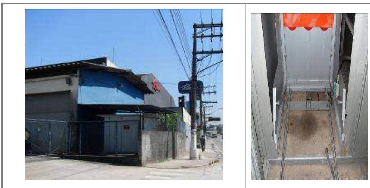
Figura 170 - Entrada e cubículo de entrada de energia (esquerda) e vista do cubículo sem disjuntor geral
