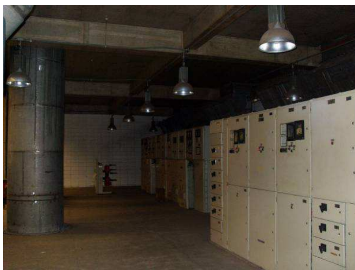
Figura 165 - Cubículos de MT ao Fundo e de Baixa Tensão/460V
