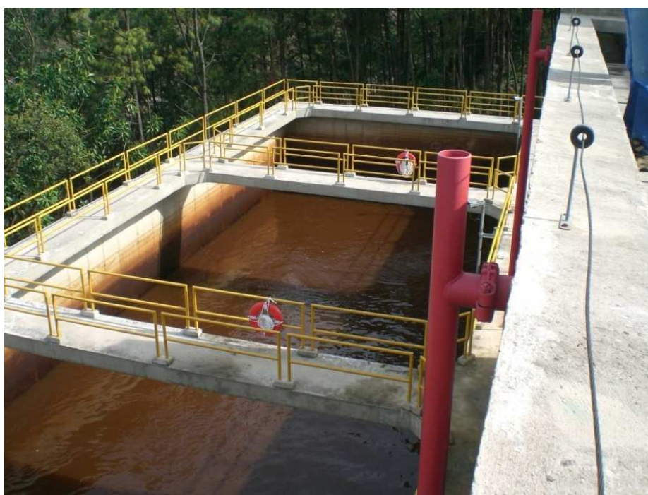
Figura 77 – Novo sistema de recuperação de água de lavagem dos filtros da ETA Rio Grande.
