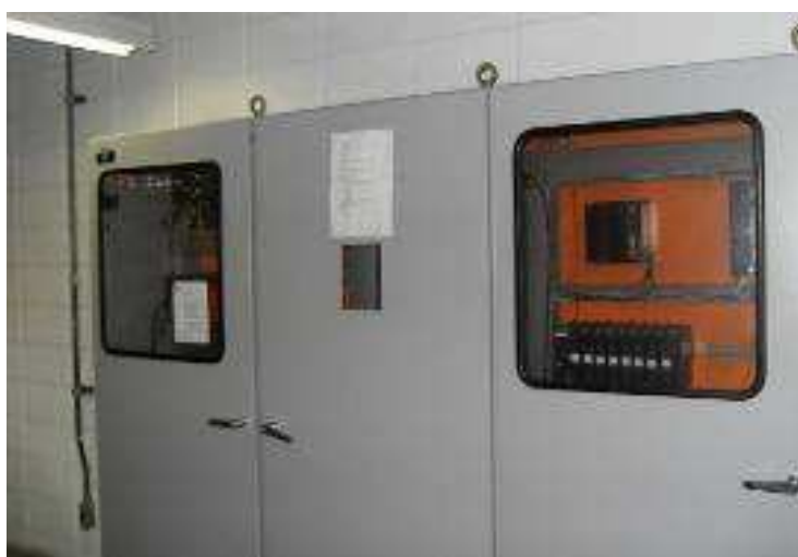
Figura 163 - Sistema de Aquisição de Dados da Unidade Remota
