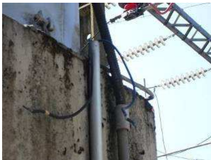
Figura 116 - Cabos desconectados
