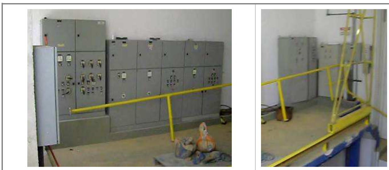
Figura 182 - Piso de Painéis, PSA, CCM Painel de Capacitores e Quadro de Luz
