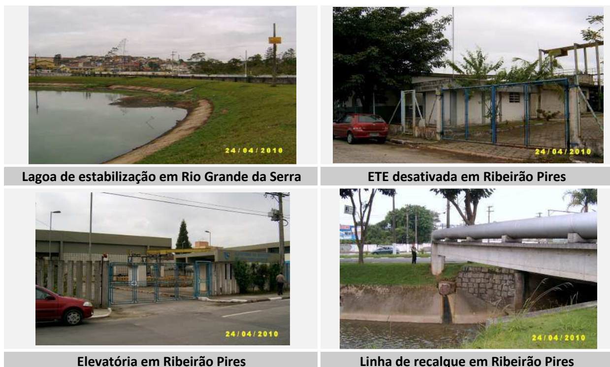
Figura 84 – Esgotos em Municípios vizinhos
