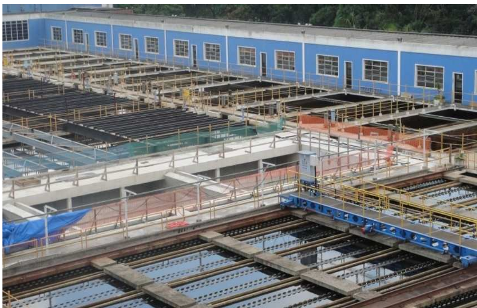
Figura 72 - Vista geral do decantador 7 pertencente a “Ala Velha” atualmente em fase de reforma: transformação em unidade de flotação com ar dissolvido
