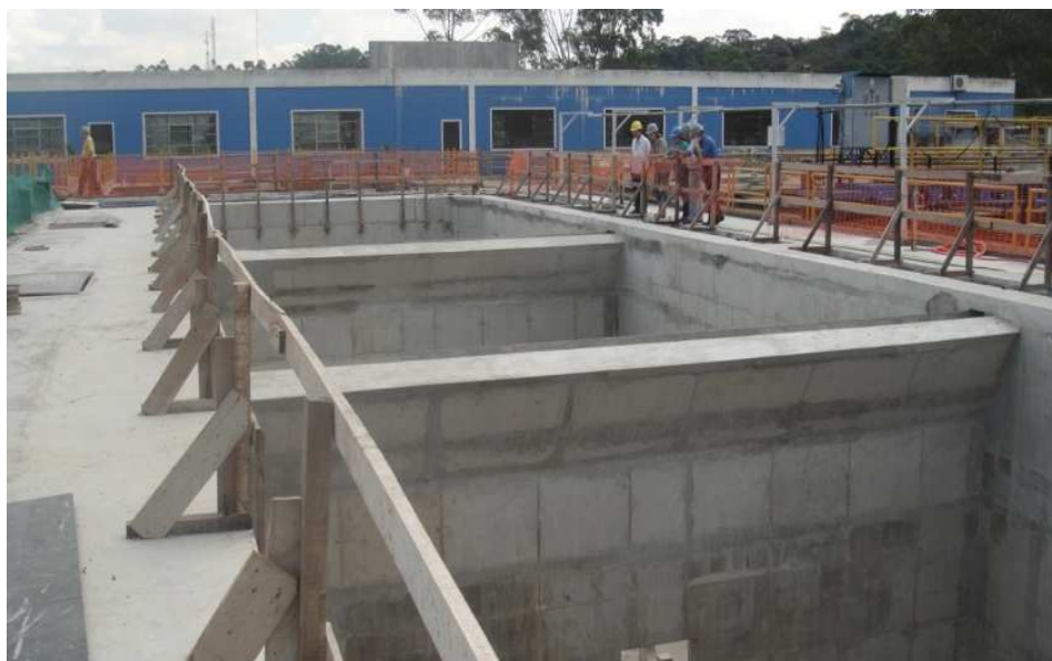
Figura 73 – Detalhe construtivo do decantador 7 pertencente a “Ala Velha” atualmente em fase de reforma: transformação em unidade de flotação com ar dissolvido
