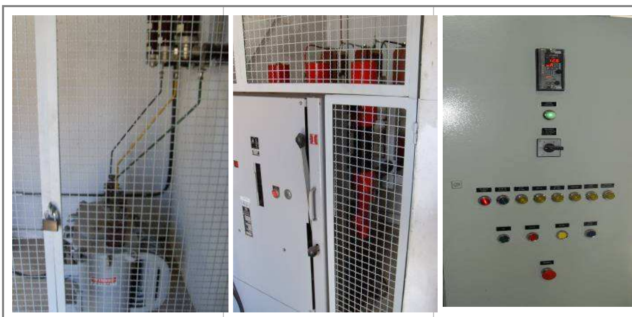
Figura 176 - Cella do Trafo Auxiliar (esquerda); Cella do Disjuntor a Pequeno Volume de Óleo (centro) e PDCR
