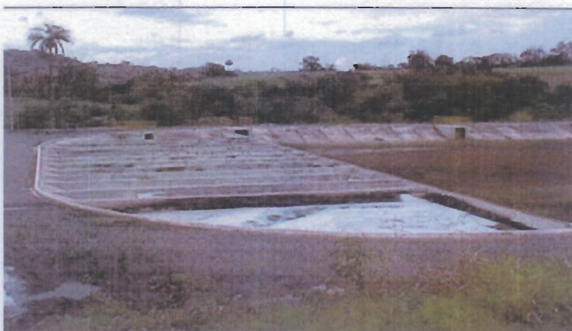
Foto 32- ETE São João da Boa Vista - Câmara de contato da desinfecção
