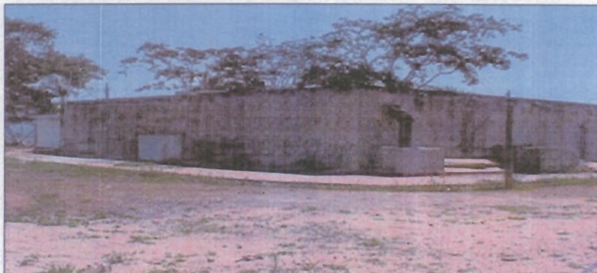
Foto 11 - Reservatório Magalhães RA01 - 1.000 m 3 - Zona de abastecimento do Magalhães
