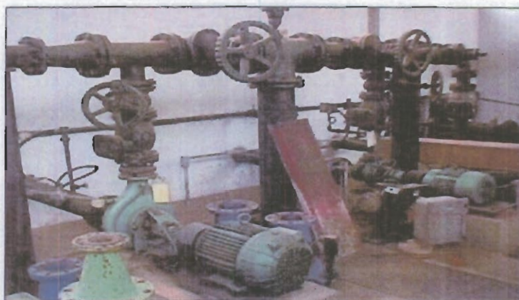
Foto 16 - Estação elevatória EEAT02 - Zona Alta
