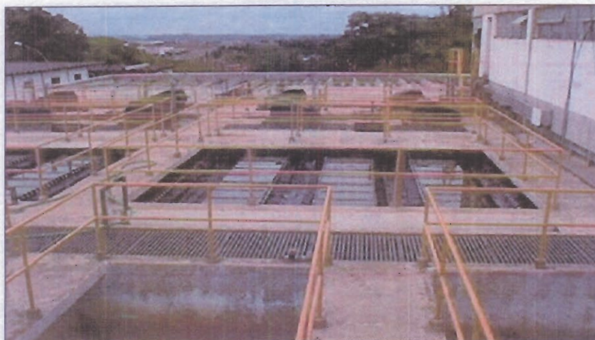
Foto 6 - ETA - Vista dos floculadores e decantadores
