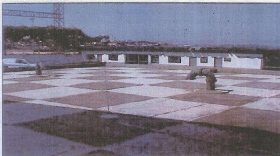
Foto 12 - Reservatório semi-enterrado RS04 - 900 m 3 - Zona baixa
