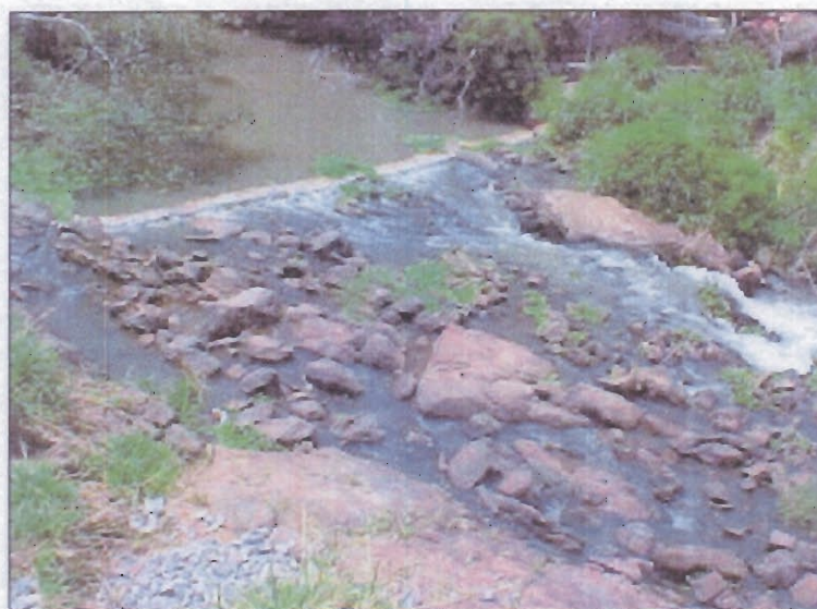
Foto 1 - Vista do enrocamento
