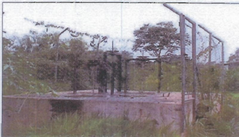
Foto 26 - Sifão invertido do Rio da Prata
