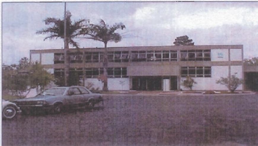
Foto 5 - ETA - Vista da casa de química
