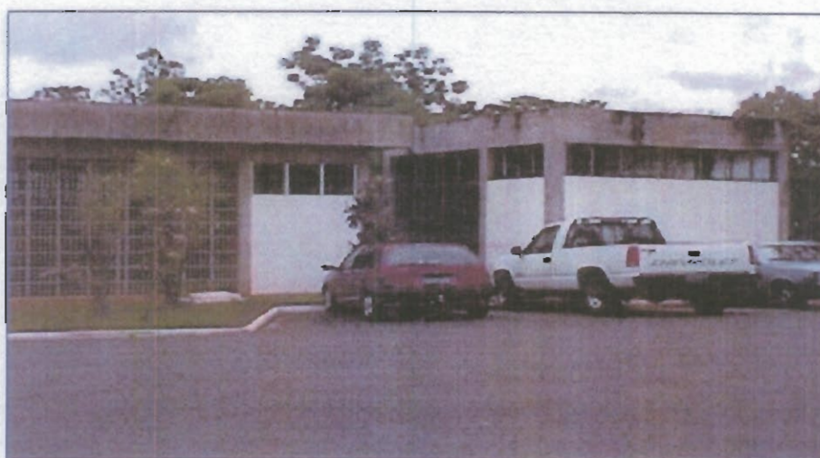
Foto 14 - Vista das elevatórias EEAT01 e EEAT 02
