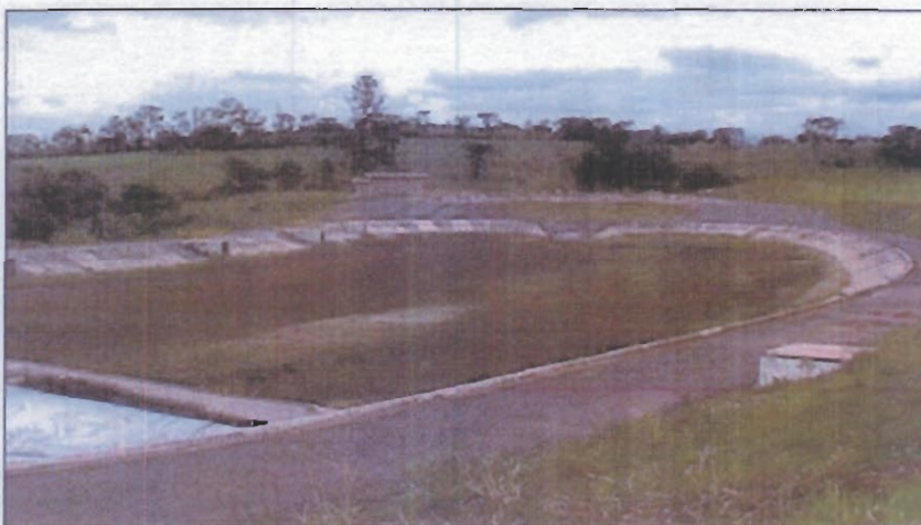
Foto 32- ETE São João da Boa Vista - Câmara de contato da desinfecção
