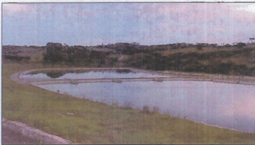
Foto 31 - ETE São João da Boa Vista - Lagoas de secagem de lodo
