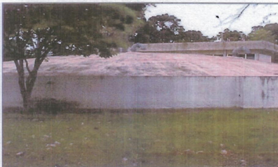
Foto 8 - Reservatório semi-enterrado RS02 - 1.200 m 3 - Zona média
