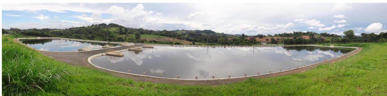
Foto 4.15 - Lagoas de Sedimentação
