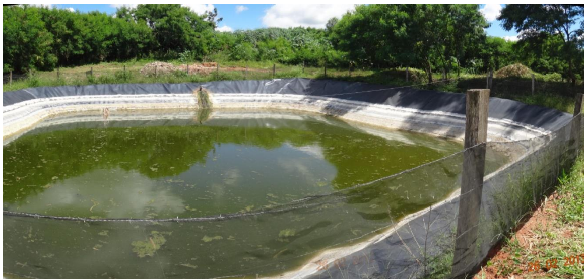
Foto 4.32 - Lagoa de armazenamento de Chorume
