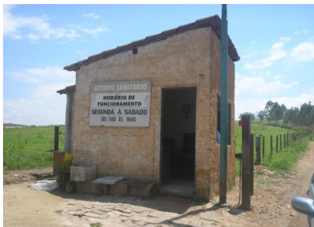
Foto 4.28 - Portaria do Aterro Sanitário
