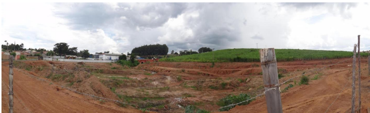
Foto 4.35 - Obras - Piscinão Córrego Aeroporto
