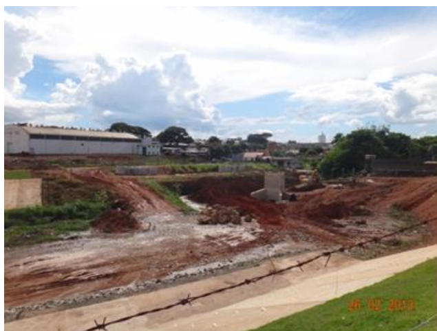
Foto 4.33 - Obras - Piscinão Córrego Bananal
