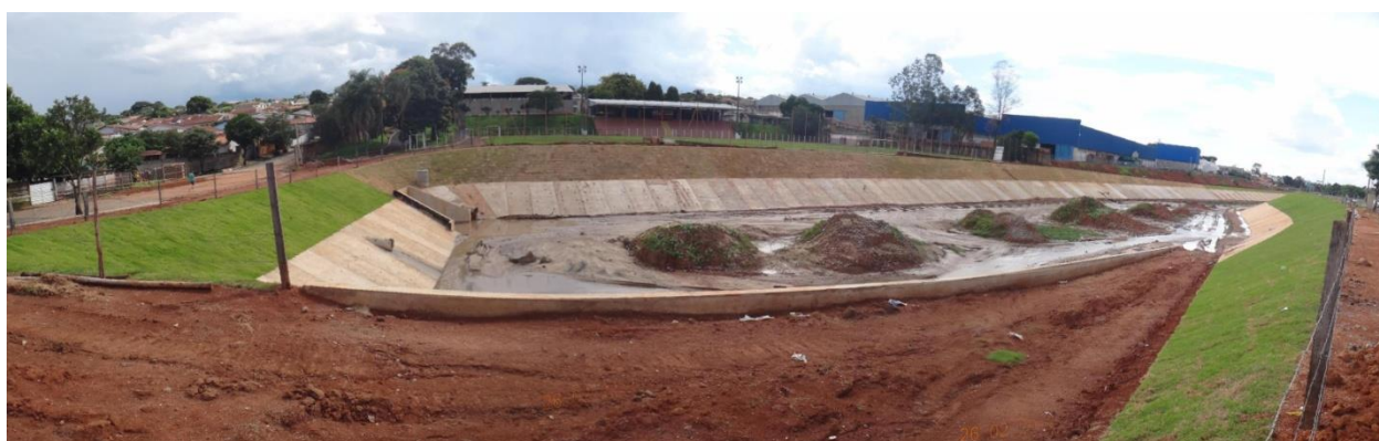
Foto 4.34 - Obras - Piscinão Córrego Bananal
