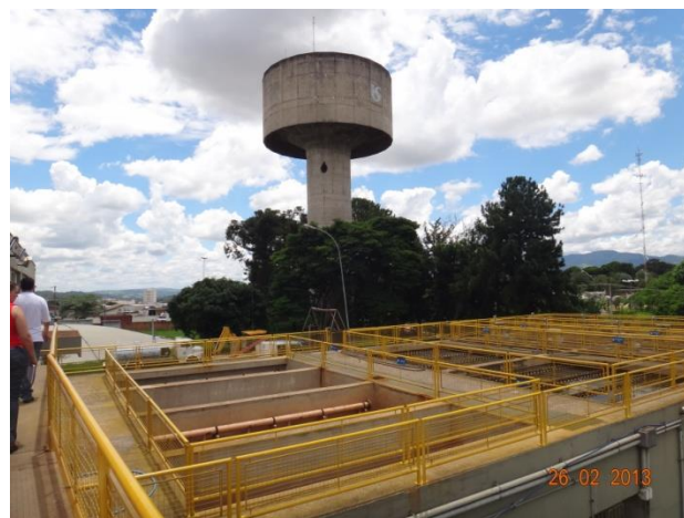
Foto 4.8 - Reservatório de lavagem dos filtros - RT01
