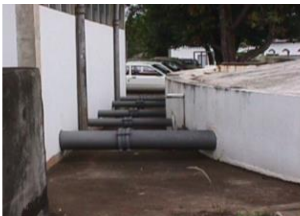
Foto 4.11 - Saída do RS2 para EEATs e distribuição
