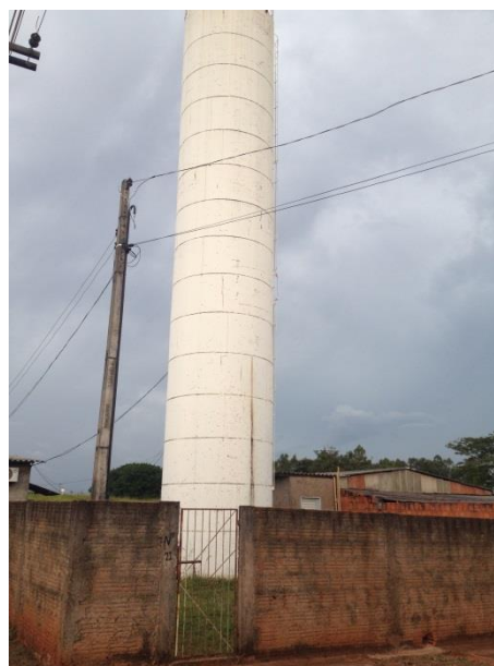
Foto 3.3.8 – Vista do reservatório 4
