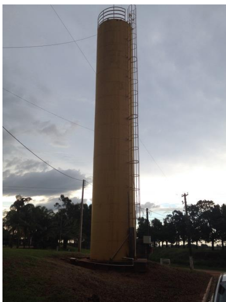
Foto 3.3.7 – Vista do Reservatório 2
