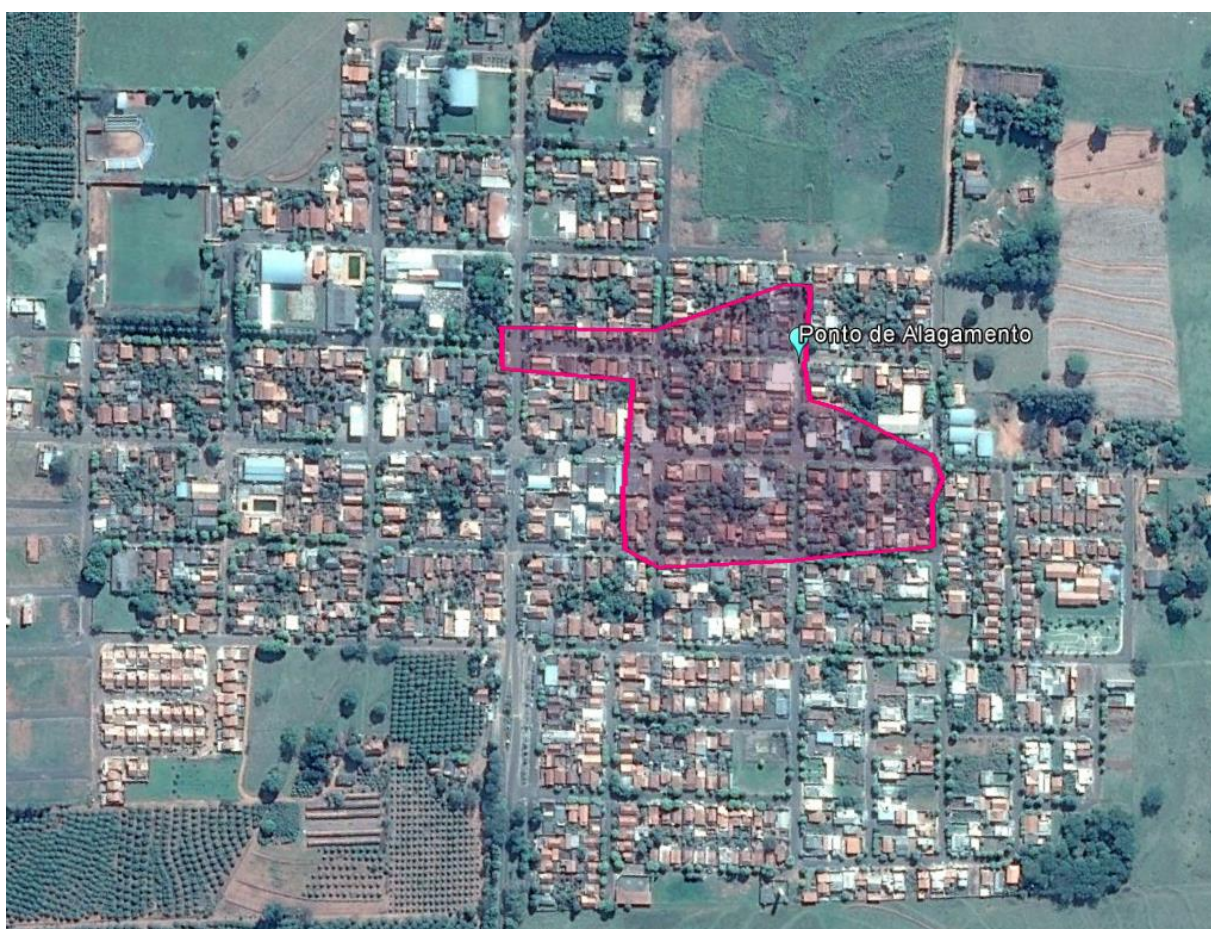
Figura 4.1 – Ponto crítico do sistema de microdrenagem
