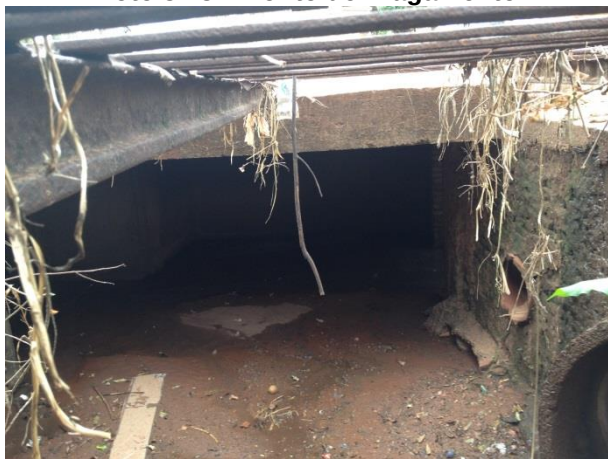
Foto 3.20 – Ponto de alagamento e caixa de passagem
