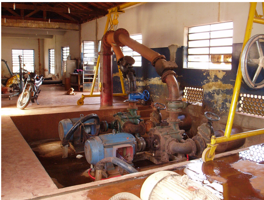
ELEVATÓRIA DE CAPTAÇÃO DE ÁGUA BRUTA
