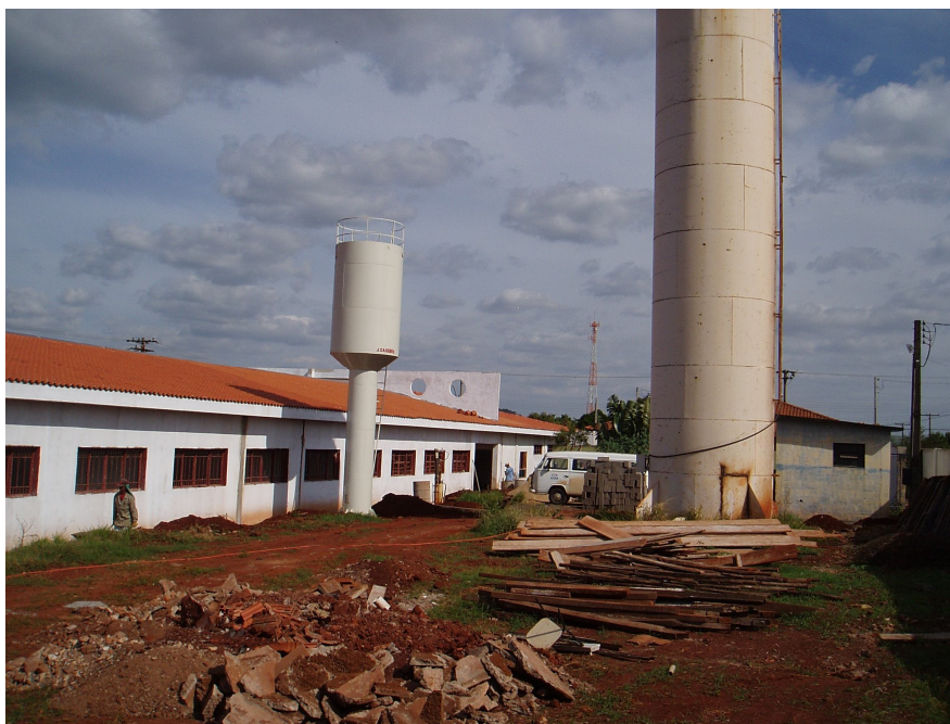
CENTRO DE RESERVAÇÃO SANBRA
