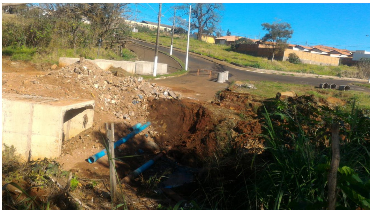
Foto 3.3 – Obras na ponte da Rua Felipe Chediak e Rua Alfredo Nogueira, Córrego Olaria
