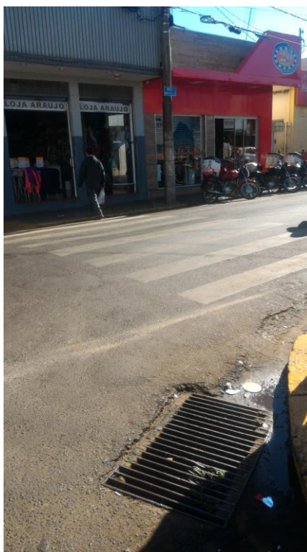
Foto 3.2 – Boca-de-lobo tipo grelha, Rua São Paulo
