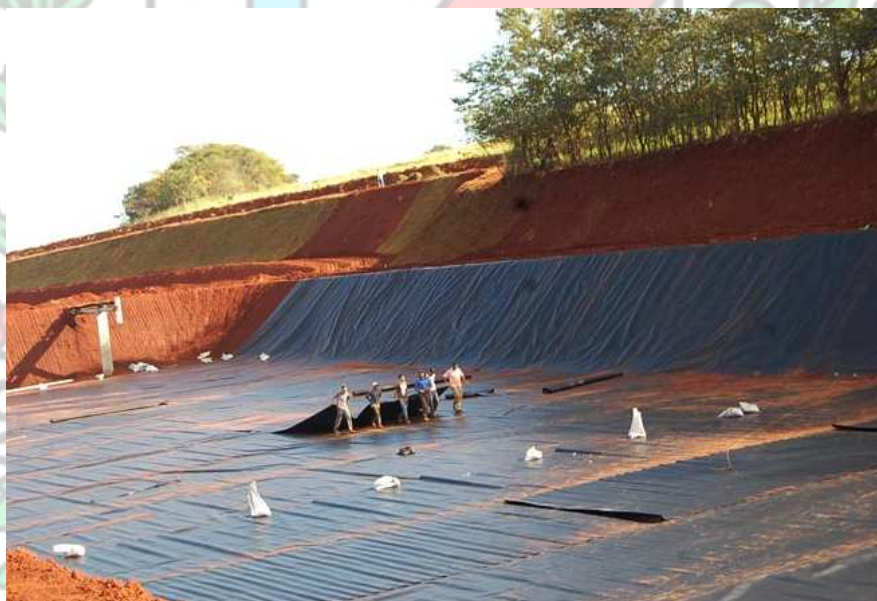
Foto 02: Impermeabilização de Vala com Geomembrana
