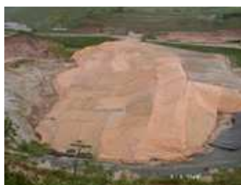
Armazenamento temporário de Aterro Industrial coberto com Incinerador resíduos industriais manta de sacrifício
