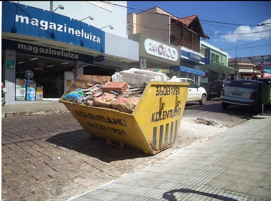
**Imagem 23: Caçamba da Empresa Kolentulho, disposta defronte uma obra para coleta de resíduos da Construção Civil**
