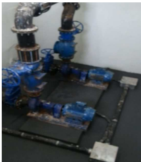
Figura 121 Novos reservatório e elevatória com conjuntos de 50CV-220Vca para o Diniz
