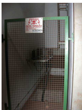
Figura 119 Sequência de fotos da subestação. Cella do disjuntor sem TP's
