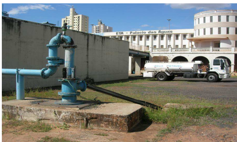
Figura 91 Vista do poço PTG-001
