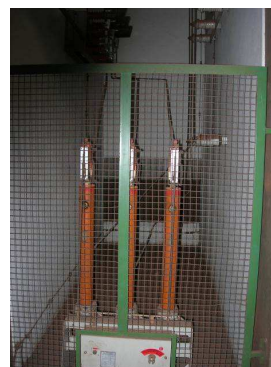
Figura 119 Sequência de fotos da subestação. Cella do disjuntor sem TP's
