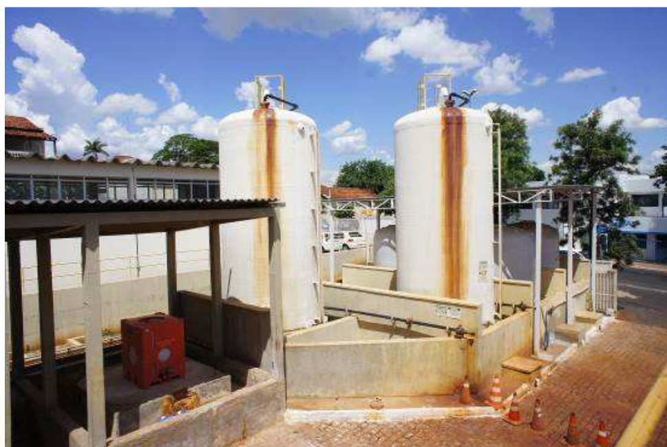
Figura 32 Sistema de estocagem de cloreto férrico nas dependências da ETA
