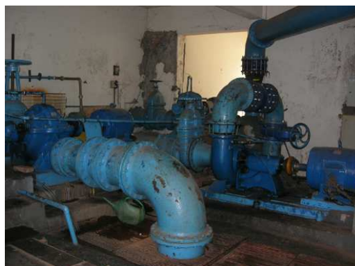
Figura 90 Conjuntos moto bombas da captação da ETA
