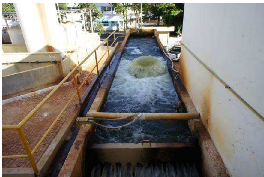
Figura 30 Vista geral do canal de água bruta
