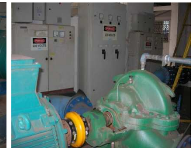
Cj 125 CV, quadro geral e acionamentos
