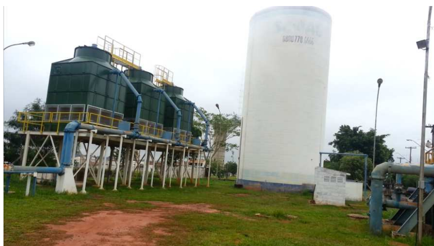
Figura 115 Vista geral do CRD Santo Antônio
