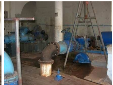
Reversível em manutenção, piso de madeira
