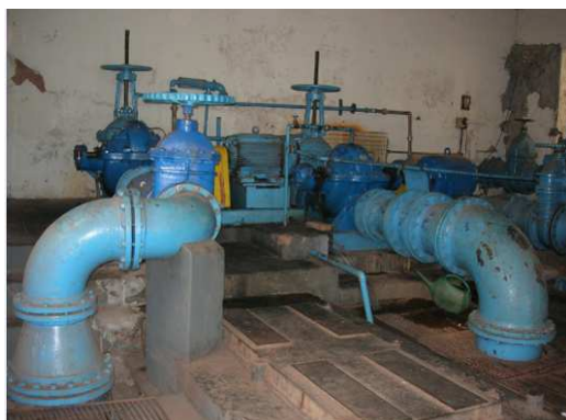
Figura 90 Conjuntos moto bombas da captação da ETA
