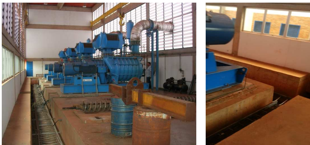
Figura 141 Vista dos sopradores e das canaletas de cabos sem tampa e proteção
