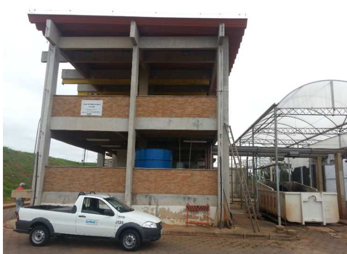
Figura 143 Vista do edifício de desidratação do lodo
