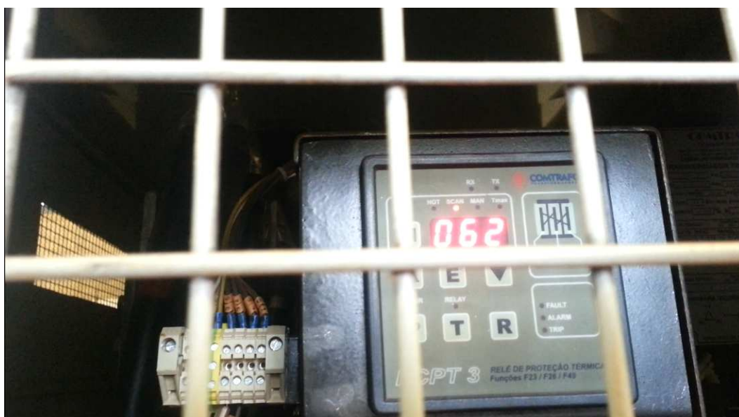
Figura 138 Proteção térmica do trafo seco da SE da EEEB
