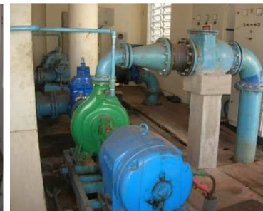
Figura 99 Conjuntos moto-bombas e acionamentos do sistema de recalque de água tratada da ETA
