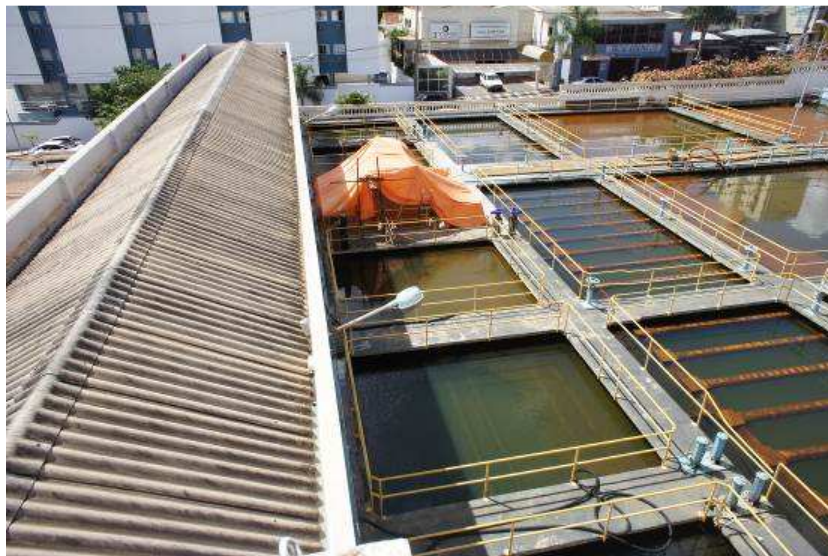
Figura 41 Vista geral dos filtros em operação
