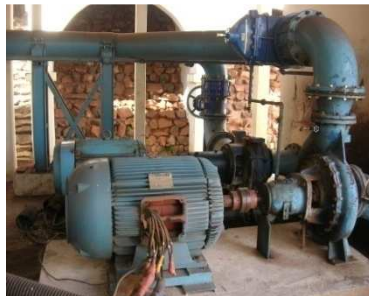
Alto Alegre - Motores de 250 CV- 440Vca e caixa de ligação/fiação
