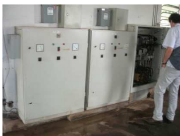
Figura 108 Centro de Reservação Alto Alegre
