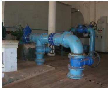
Redentora - Cj de 125 CV, acionamento e capacitor, piso madeira
