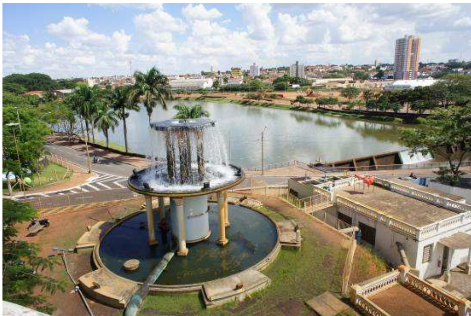
Figura 29 Vista geral do aerador instalado junto às dependências da ETA Palácio das Águas
