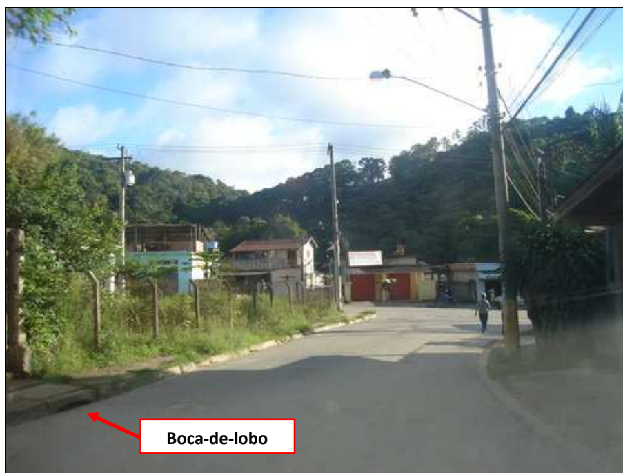
Foto 1 – Boca-de-lobo em Rua de São Lourenço da Serra
