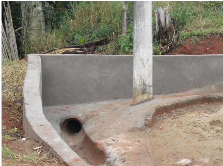
Foto 14 – Estrutura de drenagem superficial com vistas à proteção de encosta contra erosões e deslizamentos.
