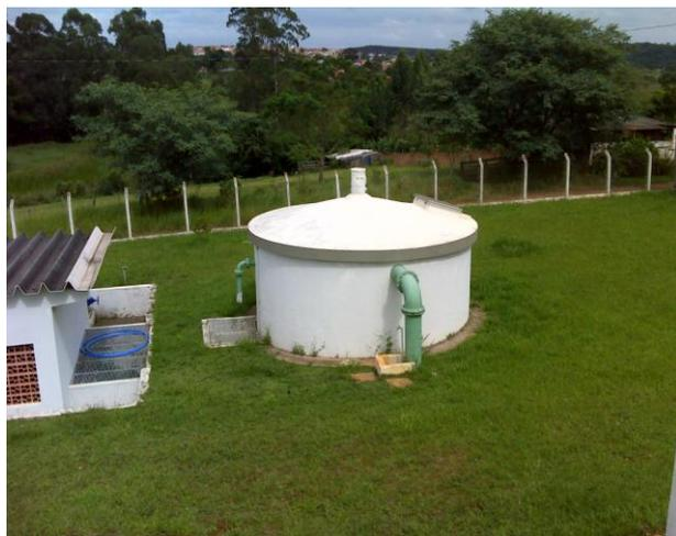
FOTO 4.6: ESTAÇÃO ELEVATÓRIA DE ÁGUA TRATADA - EEAT 1
