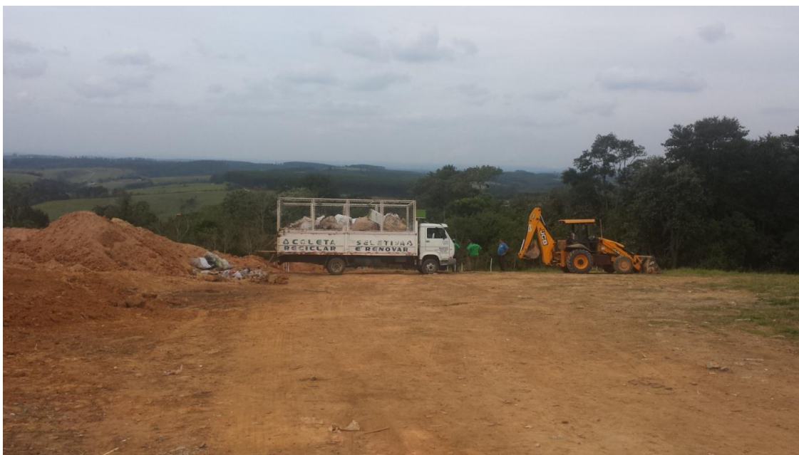
FIGURA 17 – ATERRO SANITÁRIO EM VALAS RINCÃO
