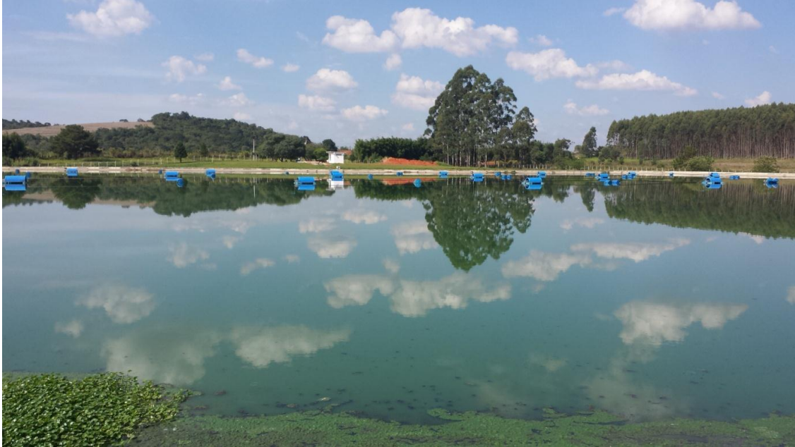
FIGURA 14 – ESTAÇÃO DE TRATAMENTO DE ESGOTO
