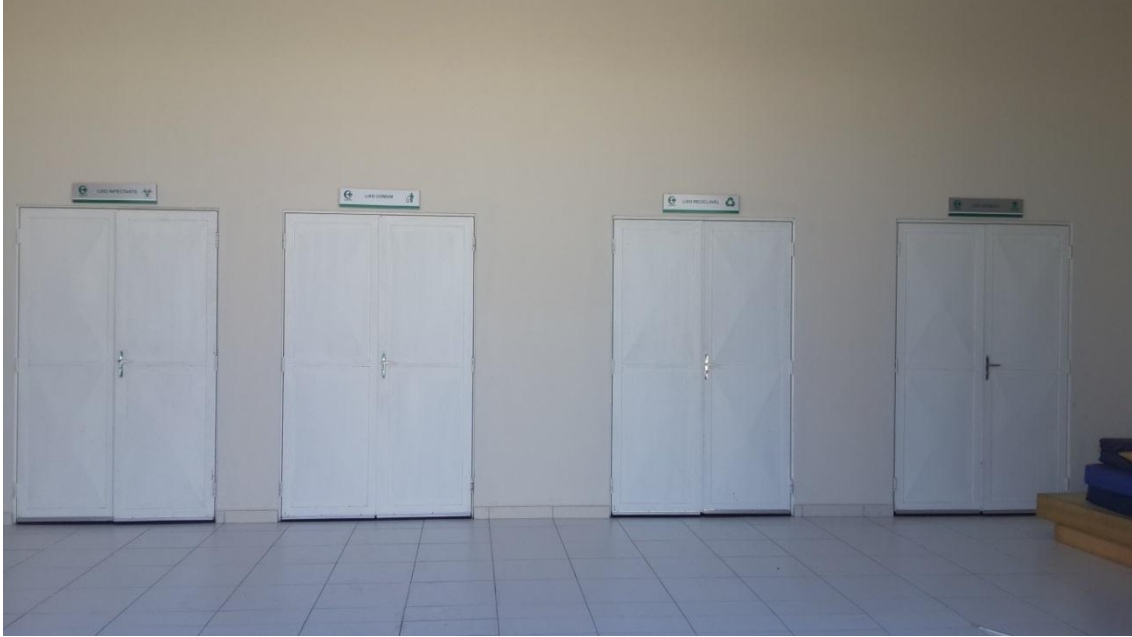
FIGURA 11 – IDENTIFICAÇÃO DOS DEPÓSITOS DE RSS DO HOSPITAL E PRONTO ATENDIMENTO DA BENEFICÊNCIA NIPO-BRASILEIRA
