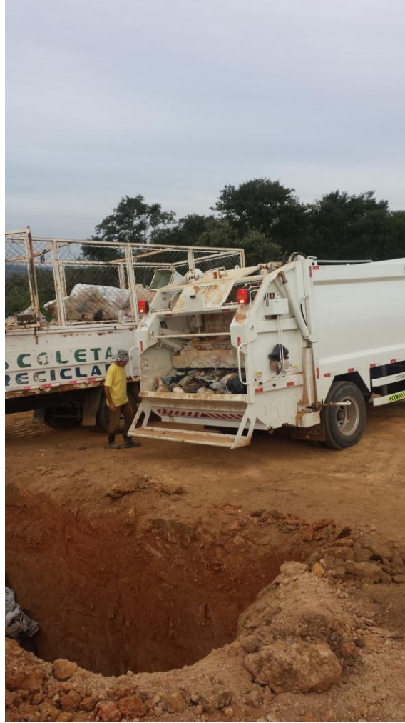
FIGURA 18 – ATERRO SANITÁRIO EM SISTEMA DE VALAS
