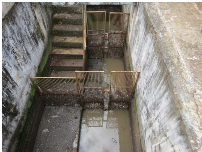
Foto 3.10 – Gradeamento - EEE Britador
