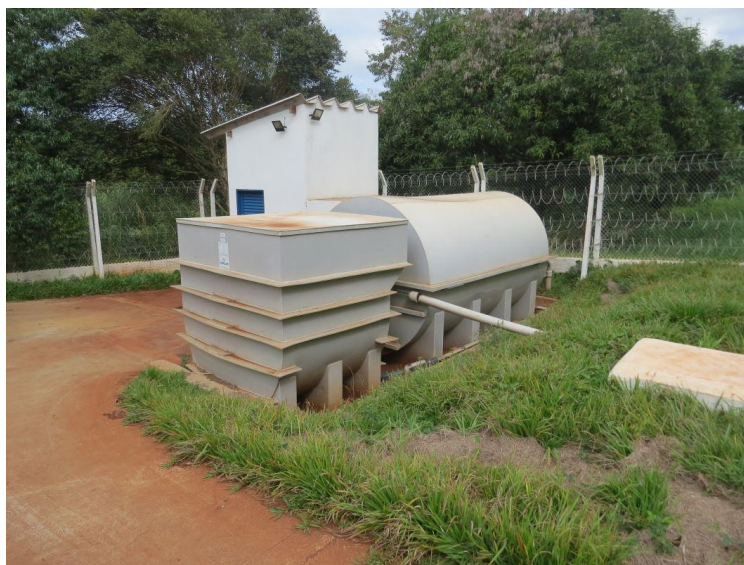
Foto 3.16 – Biodisco (Filtro Biológico Vertical)
