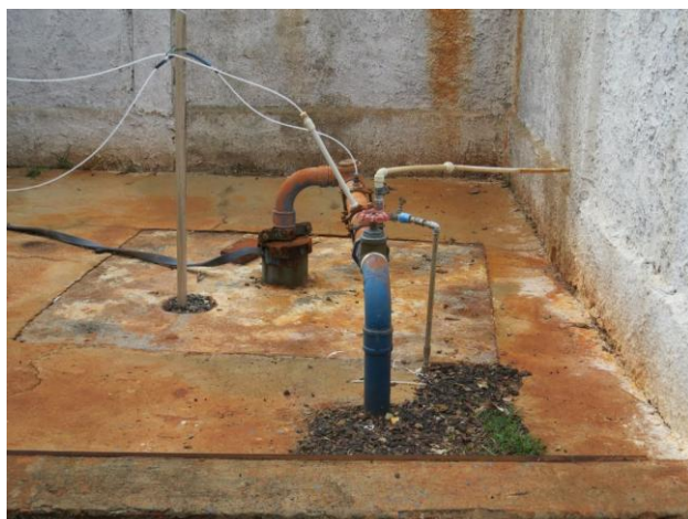
Foto 3.1 – Poço do Britador
