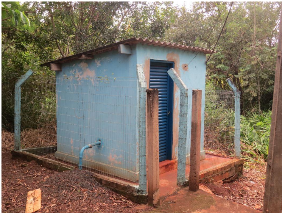
Foto 3.7 – Casa de Bomba da Mina
