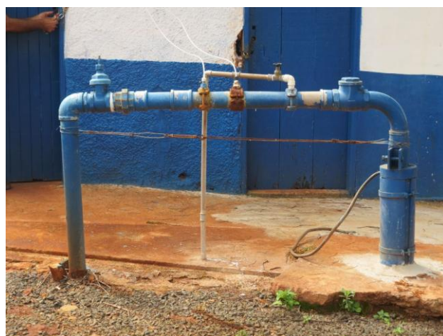
Foto 3.4 – Poço Ginásio de Esportes
