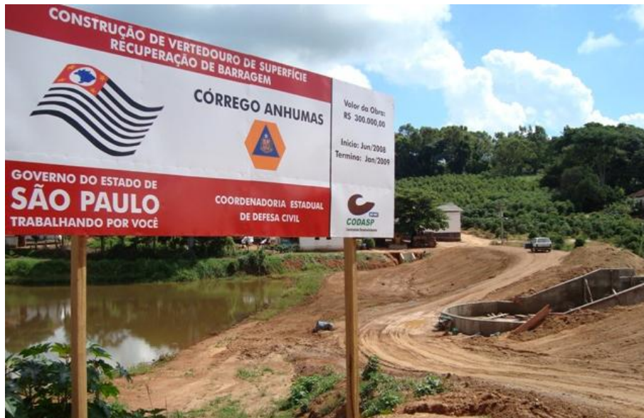
Figura 29: Obras de construção da barragem para captação de água - Córrego Anhumas.
