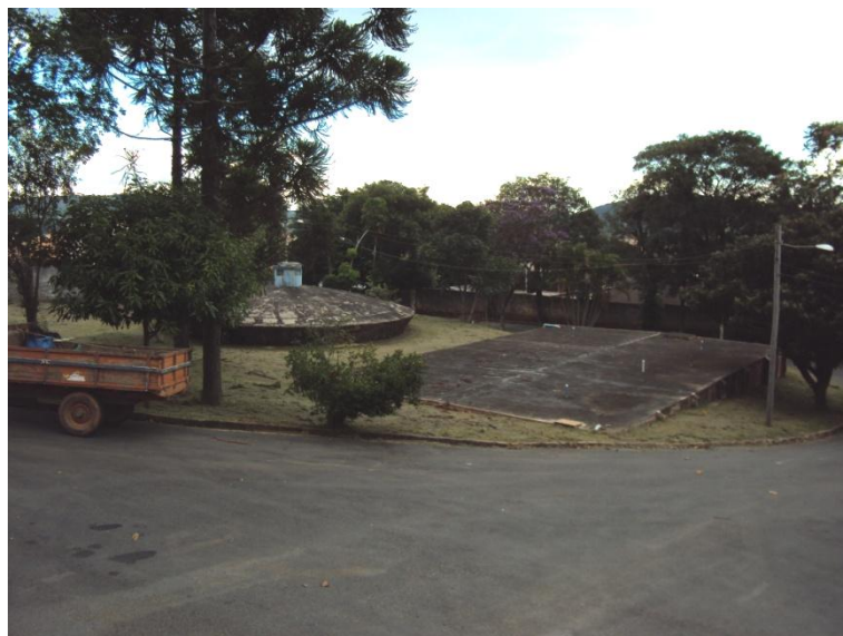
Figura 34: Reservatórios de água tratada (18/02/2013).
