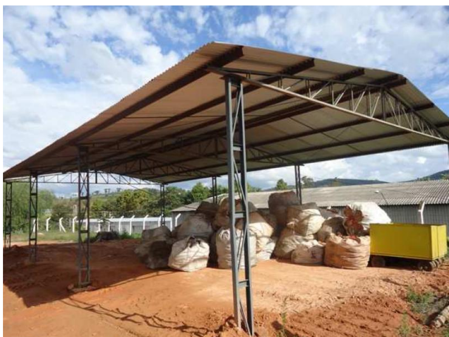
Figura 58: Resíduos recicláveis separados para venda - estrutura para armazenamento.
