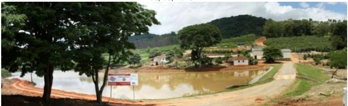
Figura 30: Obras de construção da barragem para captação de água - Córrego Anhumas.
