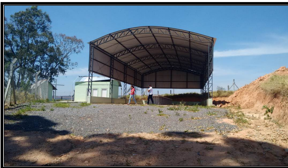
Foto 29: Vista externa do galpão de triagem. A ausência de vedação lateral, associado aos fortes ventos do local, comprometerá a segregação dos resíduos.
