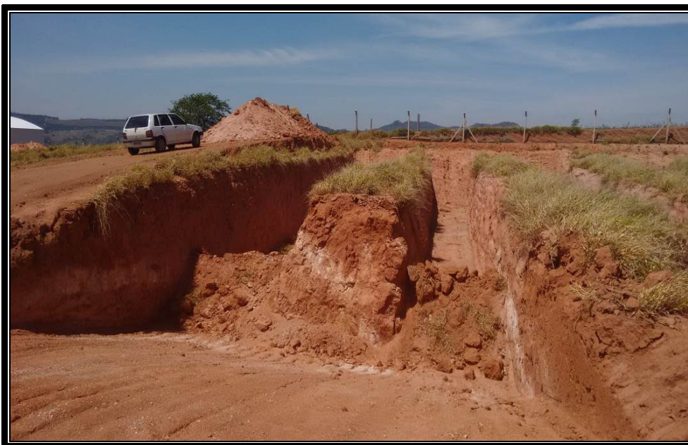
Foto 33: Valas abertas para o início da operação do aterro. Nota-se na lateral dos cortes um abatimento dos taludes, característico do solo arenoso da região.
