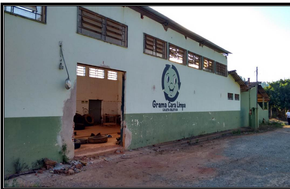
Foto 11: Vista externa do prédio. De maneira geral, a estrutura encontra-se bastante deteriorada, estando parcialmente destelhada e sem condições de ocupação.
