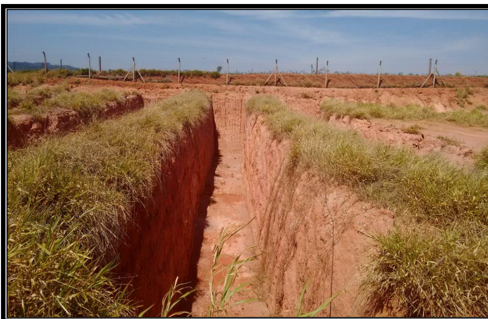
Foto 33: Valas abertas para o início da operação do aterro. Nota-se na lateral dos cortes um abatimento dos taludes, característico do solo arenoso da região.
