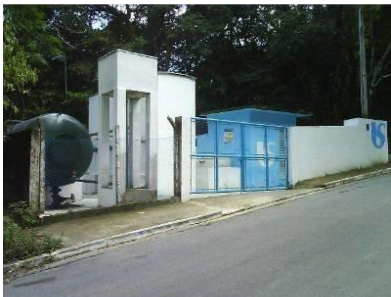
Foto 05 – Estação de Tratamento de Água Toque Toque (Fonte: SABESP)
