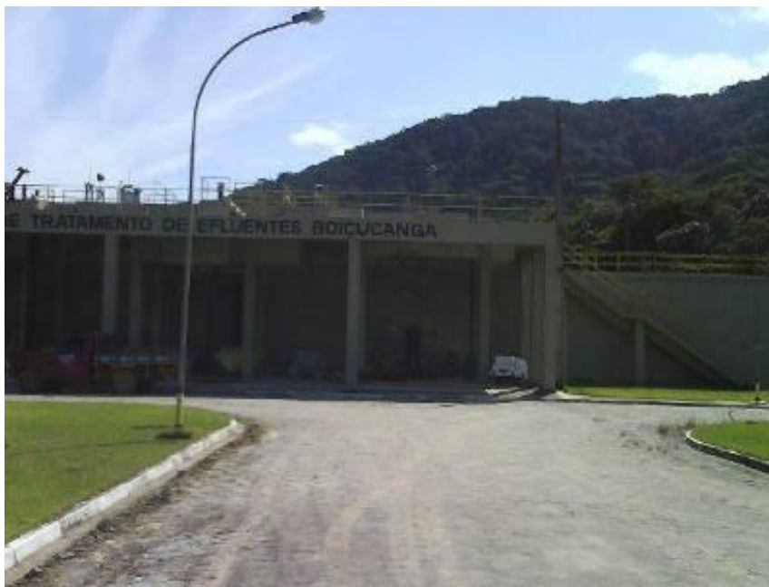
Foto 16 – Vista Geral da Estação de Tratamento de Esgotos Boiçucanga (Fonte: SABESP)
