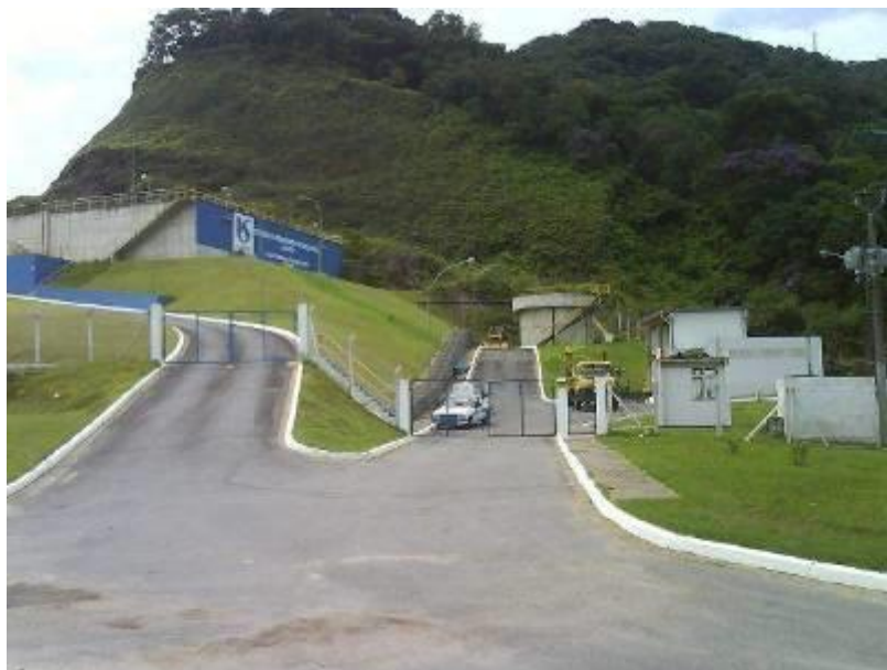
Foto 17 – Vista Geral da ETE Juquehy (Fonte: SABESP)
