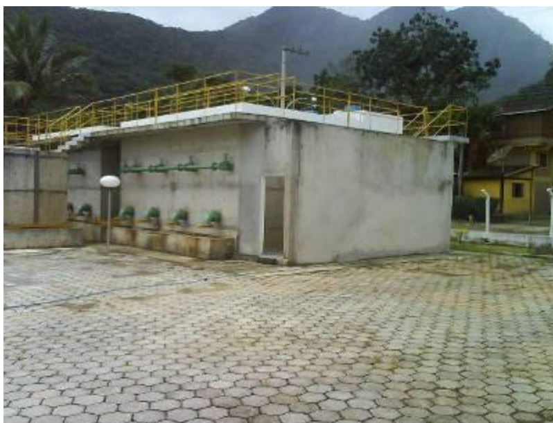
Foto 07 – Módulo de Tratamento da Estação de Tratamento de Água Maresias (Fonte: SABESP)
