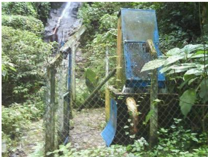
Foto 04 – Captação Toque-Toque Grande (Fonte: SABESP)
