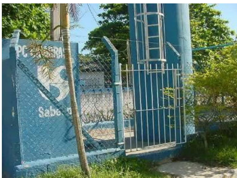
Foto 13 – Estação de Pré-Condicionamento Cigarras (Fonte: SABESP)
