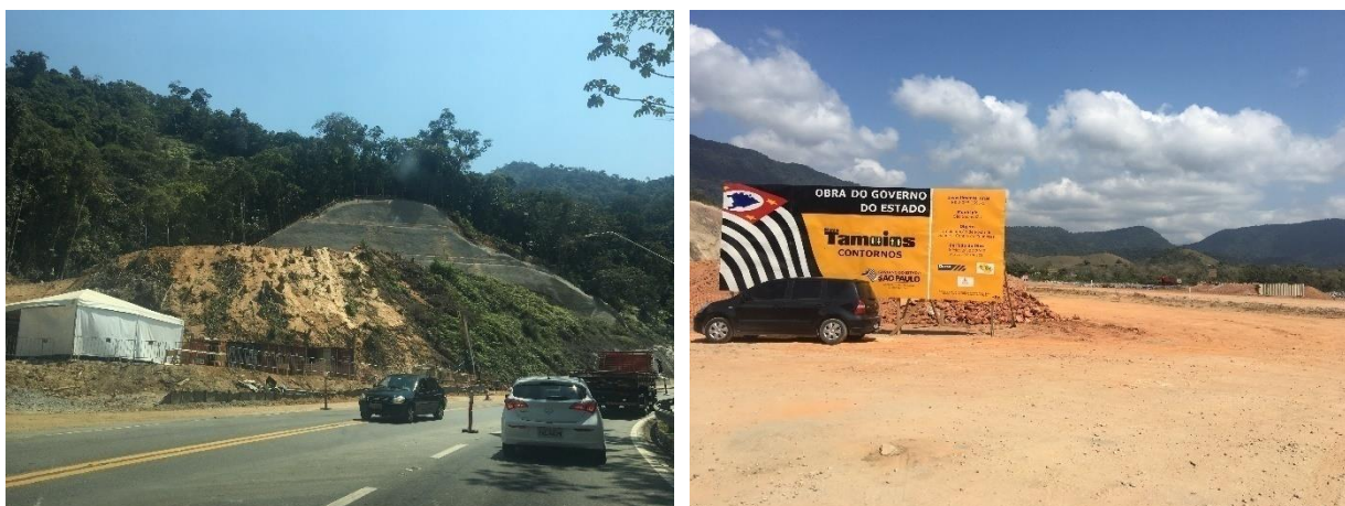
Figura 5.11 – Obras de ampliação da Nova Tamoios
