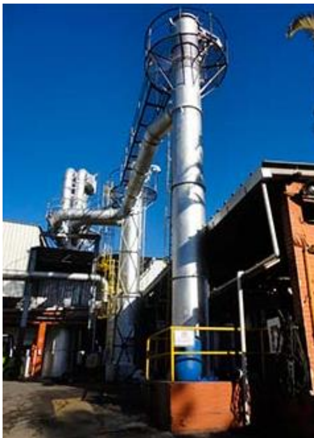
Figura 5.5 – Incineração de Resíduos de Serviço de Saúde pela Pioneira
