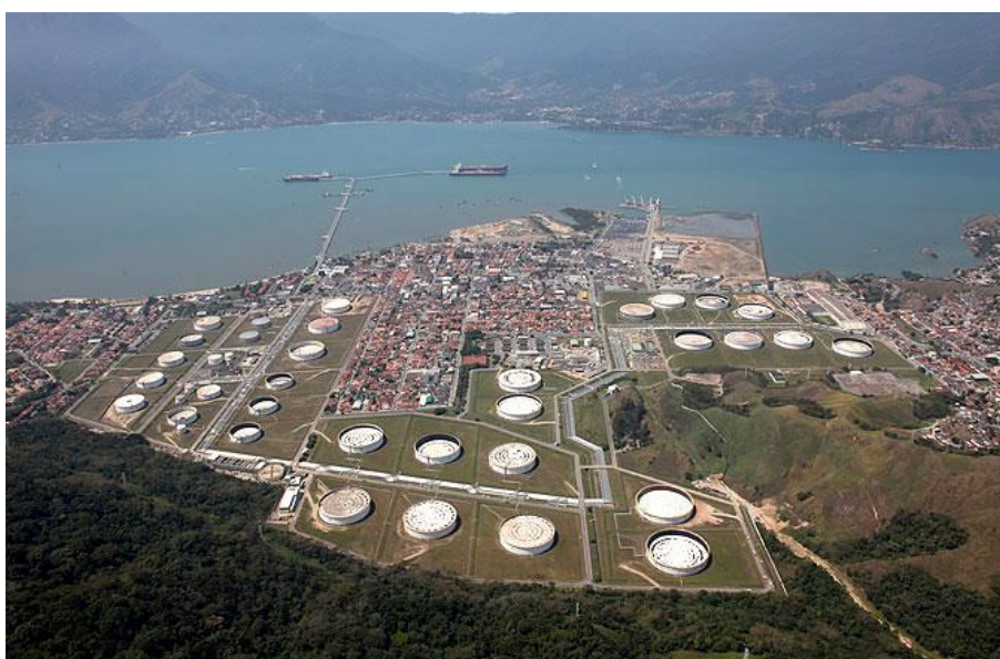
Figura 4.2 - Terminal Aquaviário Almirante Barroso (TEBAR)
