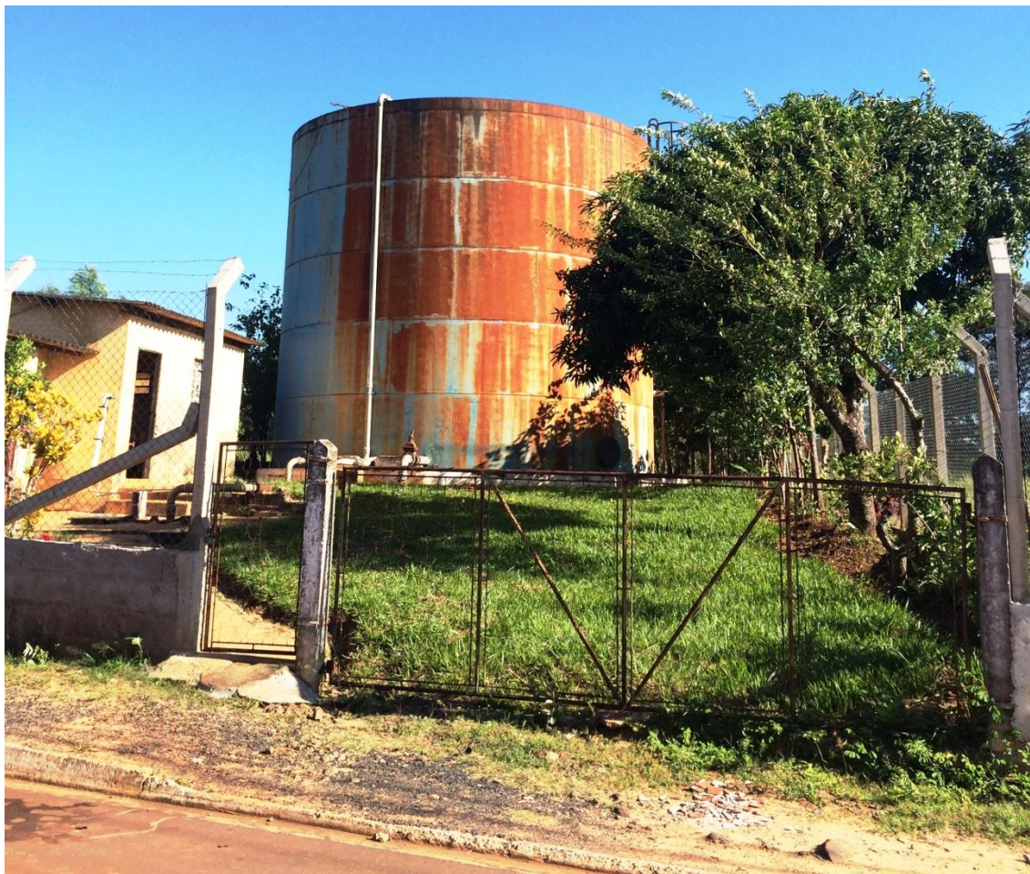
Figura 84 - Poço localizado na Rua Carolina Varanda
