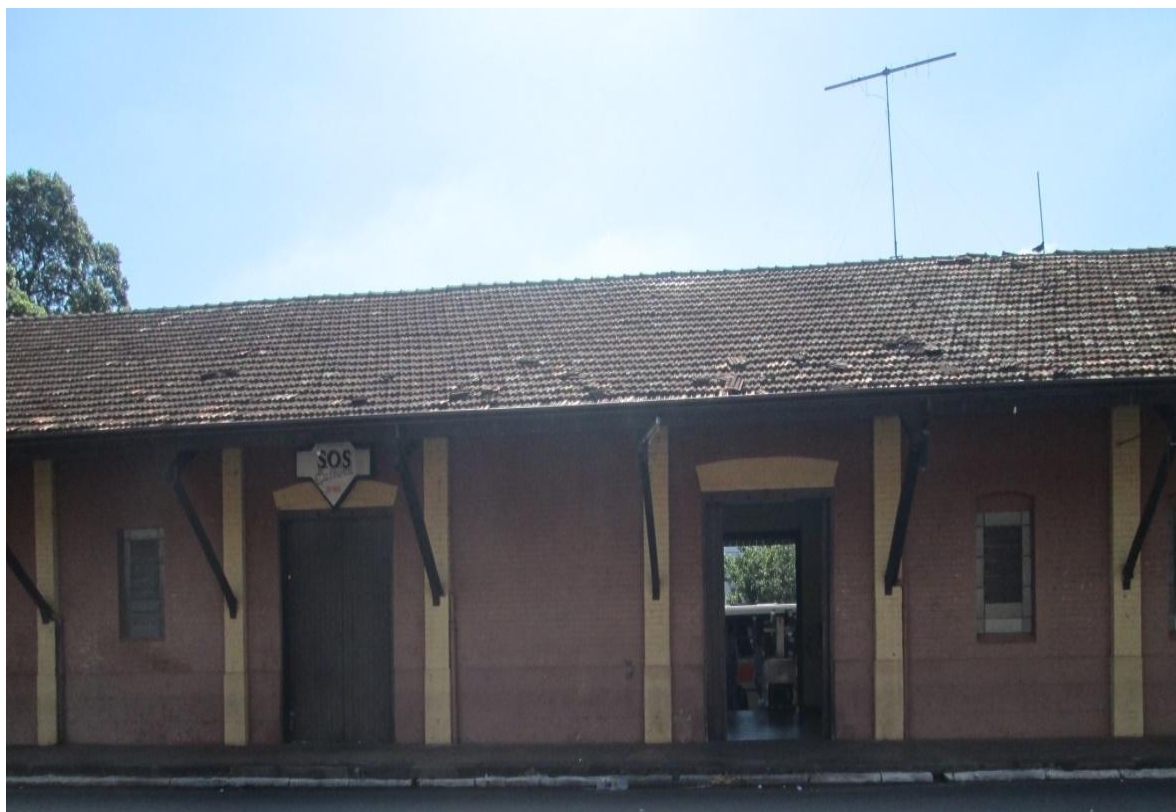
Figura 87 - Rodoviária Principal - Imagem frontal
