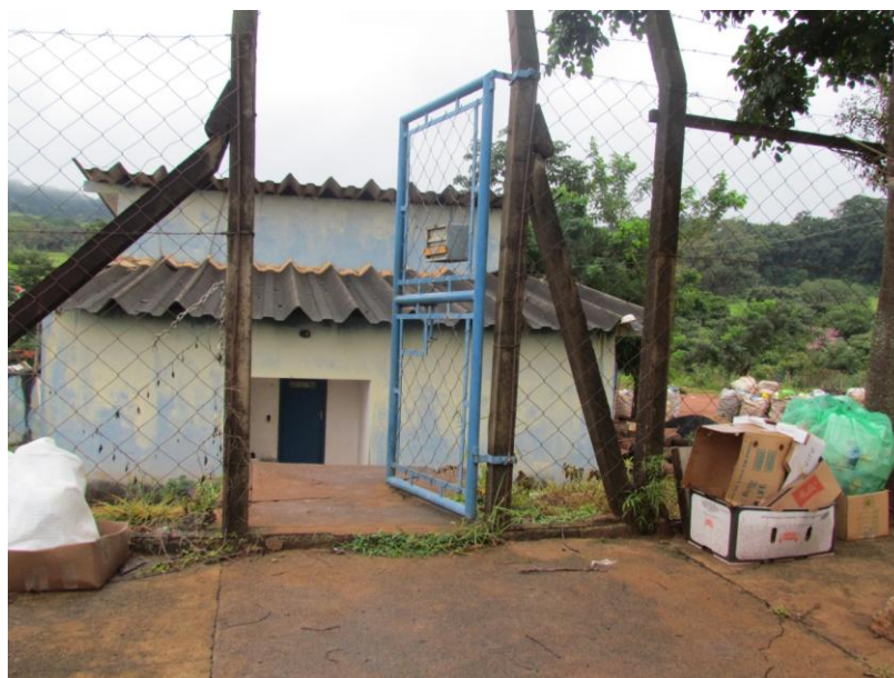
Figura 51 - Vista da entrada de acesso ao centro de triagem improvisado
