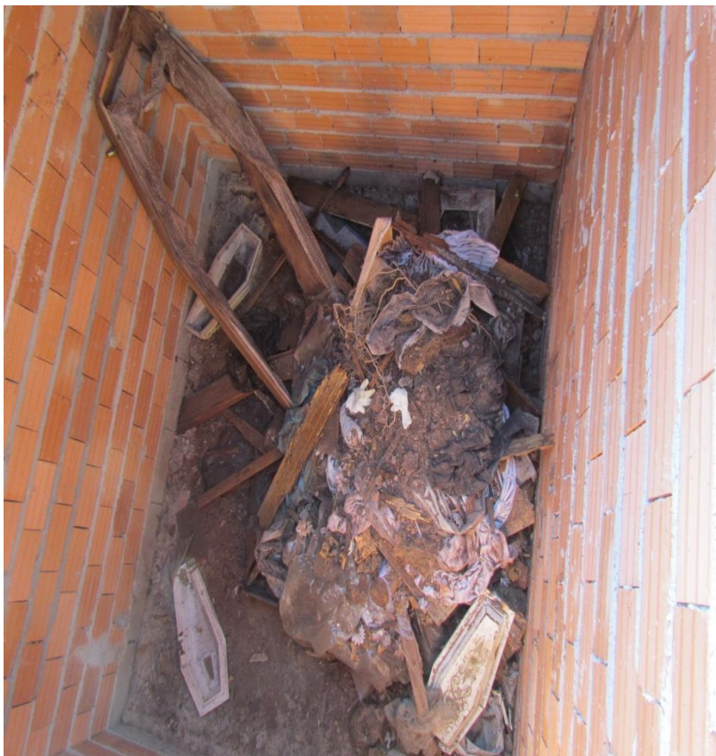
Figura 70 - Espaço em alvenaria para término da decomposição de resíduos mortuários
