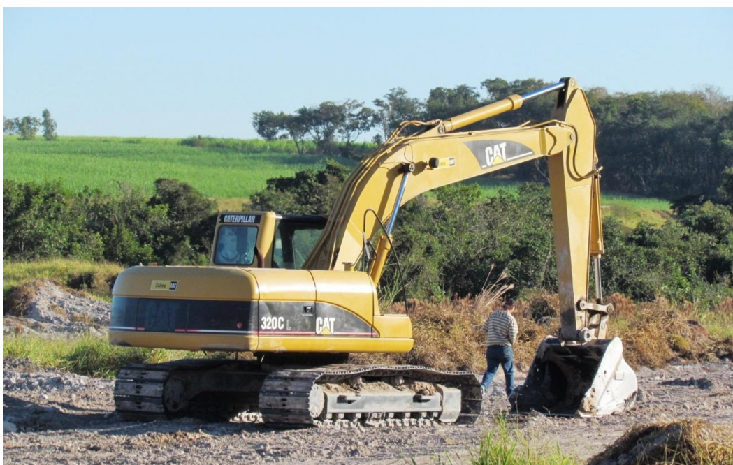
Figura 92 - Escavação para retirada de argila
