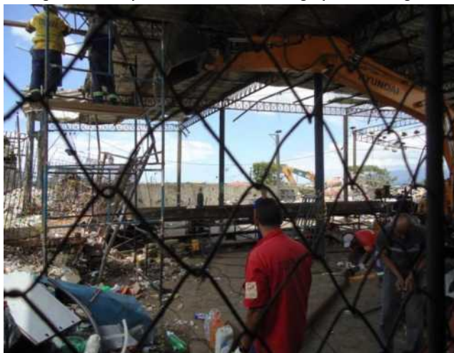
Figura 35: Reparos na estrutura do galpão de triagem
