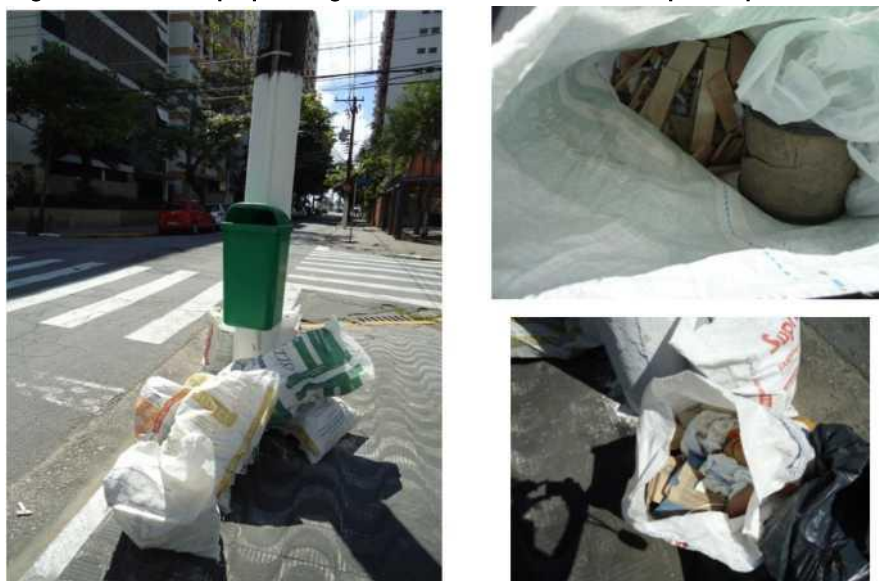
Figura 43: RCC de pequenos geradores acondicionados e dispostos para a coleta
