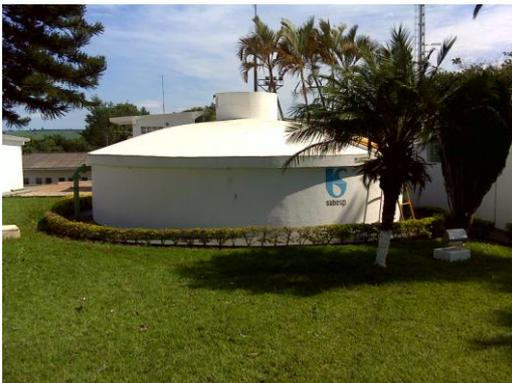
FOTO 4.3--RESERVATÓRIO SEMIENTERRADO DE 200 M<sup>3</sup>.
