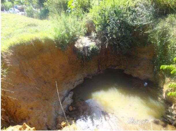
Foto 3.1 – Grande erosão causada pela dissipação da água de chuva
