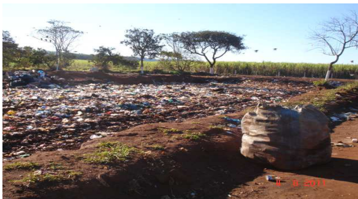
Figura 4.22. Aterro em Valas – Resíduos Espalhados Aguardando Recobrimento.
