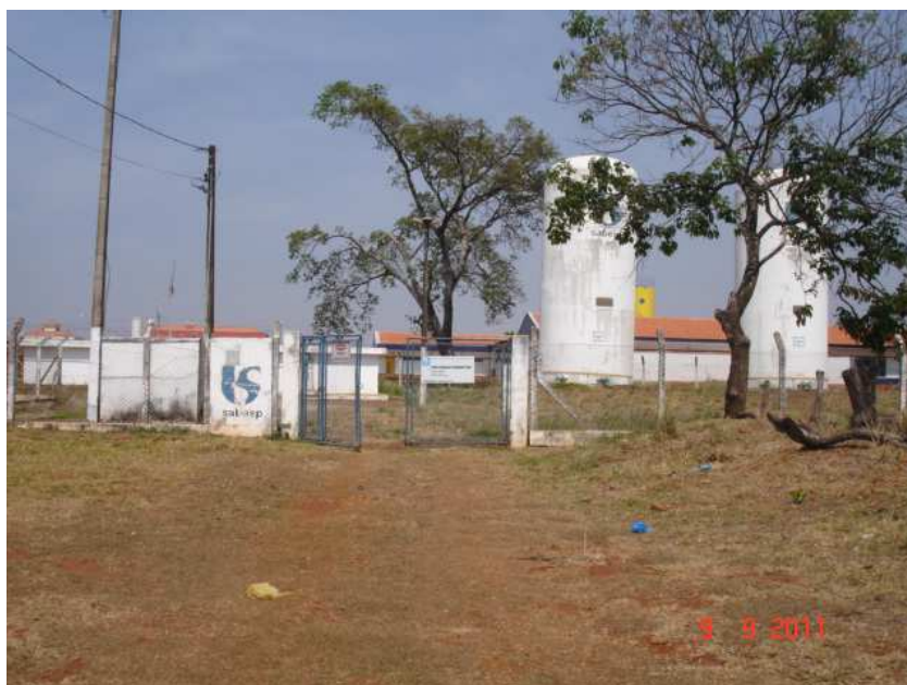
Figura 2.12. Localização da EEAT02.
