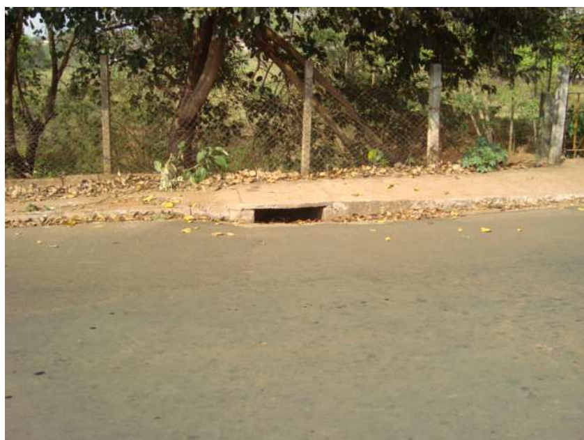
Figura 5.9. Guias, Sarjetas e Boca de Lobo Simples de Guia.
