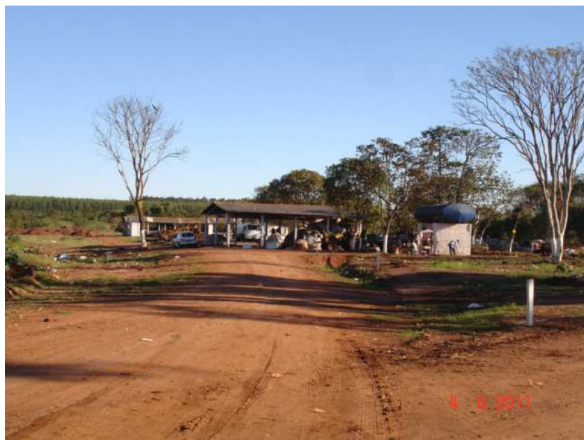
Figura 4.8. Galpões de Triagem – Vista Geral.
