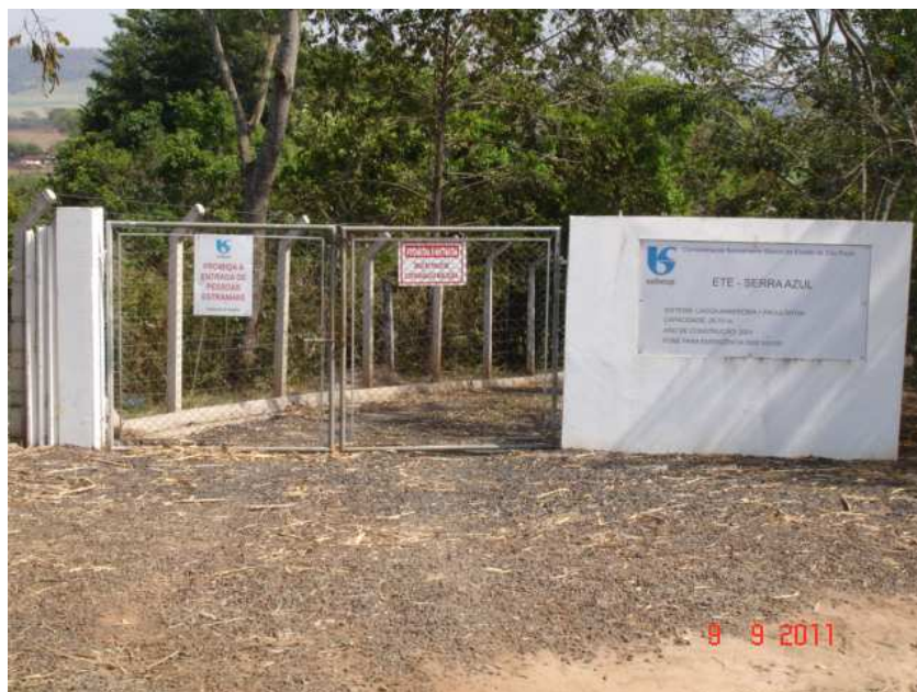
Figura 3.3. Entrada da ETE.
