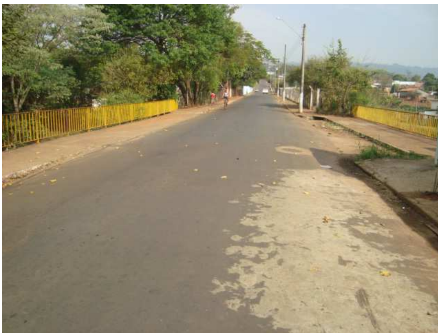
Figura 5.7. Travessia da Avenida Saudade, com captação de lançamento – Córrego Serra Azul.
