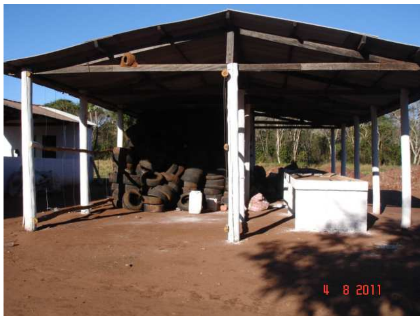
Figura 4.49. Pneus estocados em galpão na UPRS.
