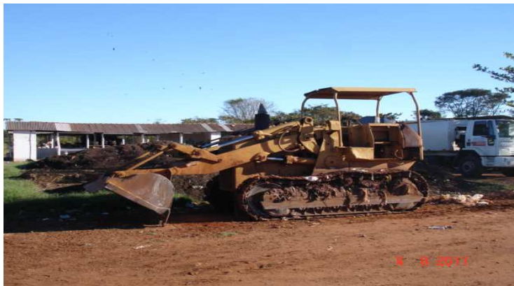
Figura 4.21. Pá Carregadeira de Esteiras – espalhamento e recobrimento dos resíduos.
