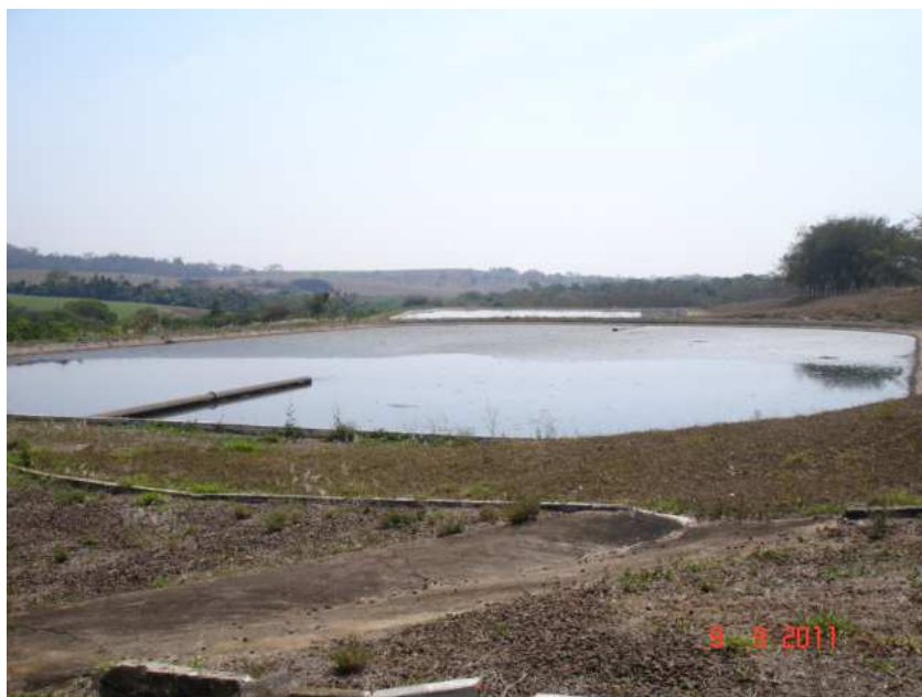
Figura 3.5. Lagoa anaeróbia.
