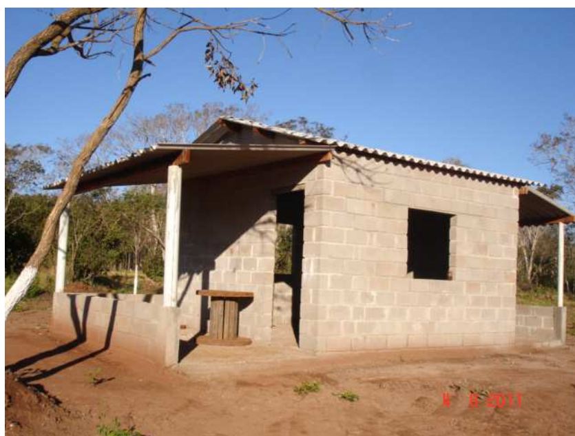
Figura 4.27. UPR - Detalhe da Guarita em construção.
