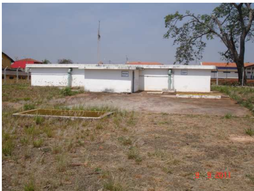
Figura 2.16. Reservatório semi-enterrado 01 (RS01).
