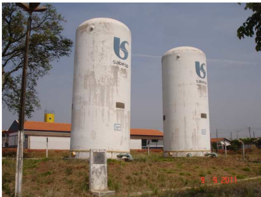
Figura 2.17. Reservatórios apoiados RA-02 e RA-03.
