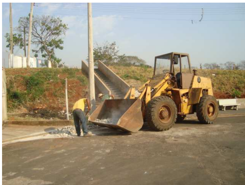
Figura 4.40. Recolhimento manual dos pequenos montes de entulho para a pá carregadeira.
