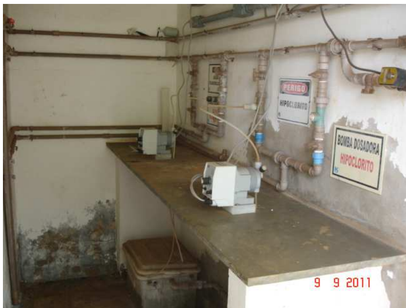
Figura 2.9. Bombas dosadoras.
