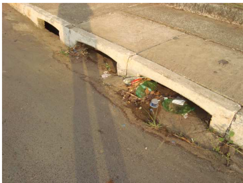
Figura 5.11. Boca de Lobo Tripla de Guia.
