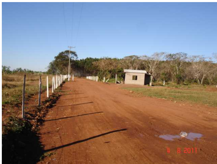
Figura 4.26. Acesso UPR – Guarita em construção.
