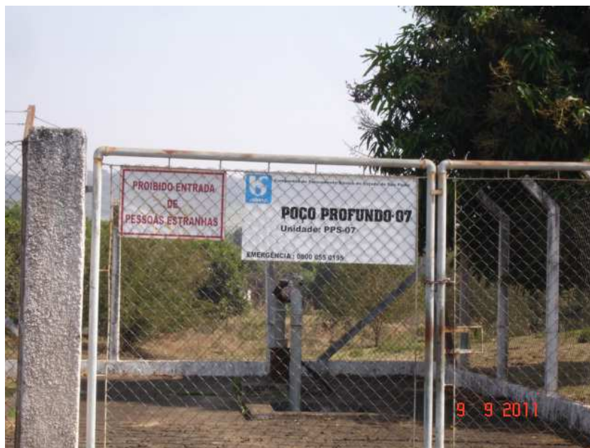
Figura 2.6. Poço profundo PPS07.
