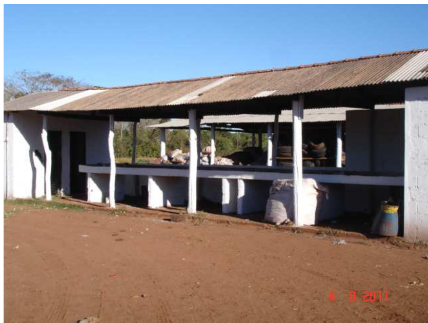
Figura 4.10. Bancadas de triagem.
