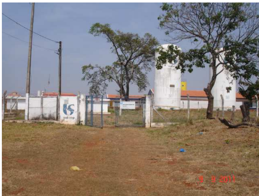
Figura 2.15. Centro de reservação e bombeamento Cohab.
