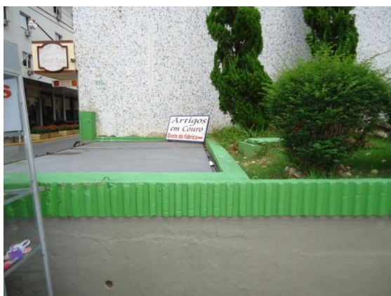
Foto 4.14 – Galeria fechada com tampa, que passa por debaixo da rua.
