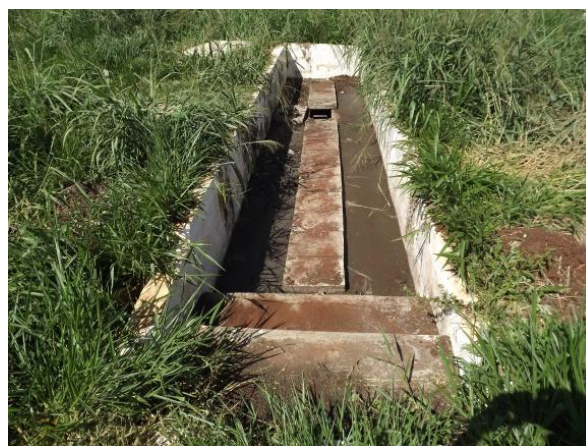
Foto 3.36 - Gradeamento da EEE Paranoá.
