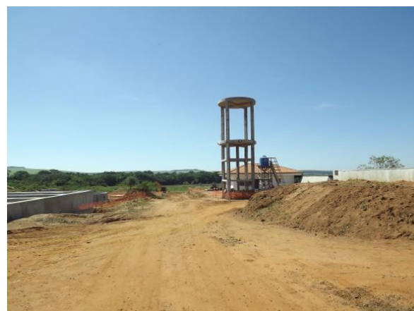
Foto 3.44 – Estrutura do Reservatório de Água.
