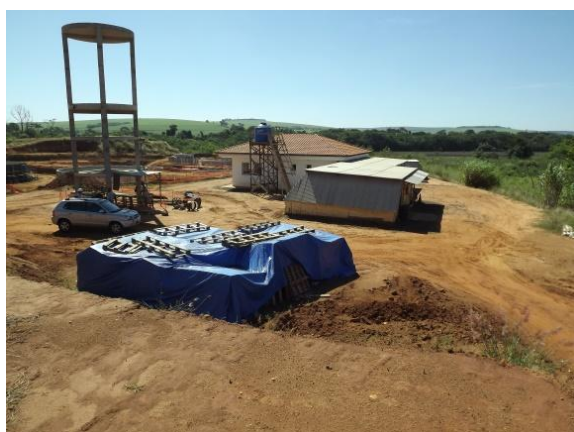
Foto 3.43 – Canteiro de Obras da ETE Serrana.
