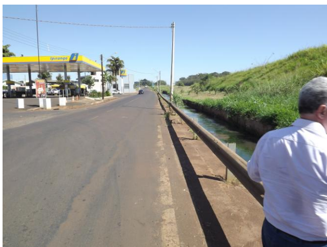
Foto 3.33 – Canal de Drenagem
