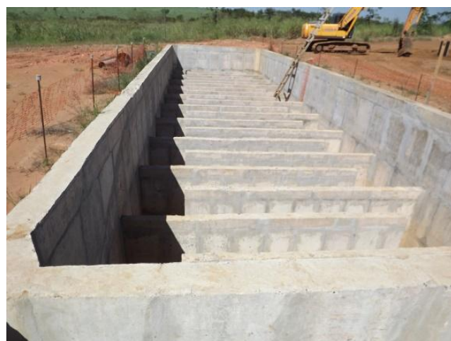
Foto 3.50— Câmara de Contato.
