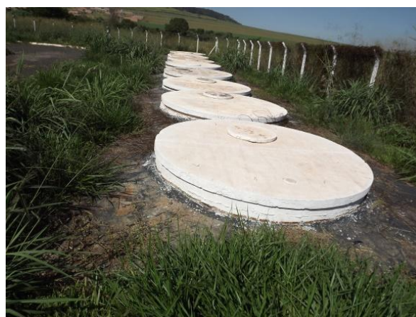
Foto 3.38 - Poços “Pulmão” da EEE Paranoá
