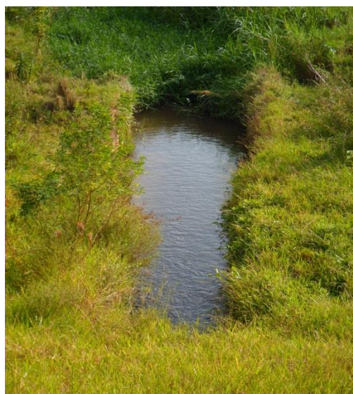
Foto 4.37 - Bacia de detenção – córrego Norte (II)
