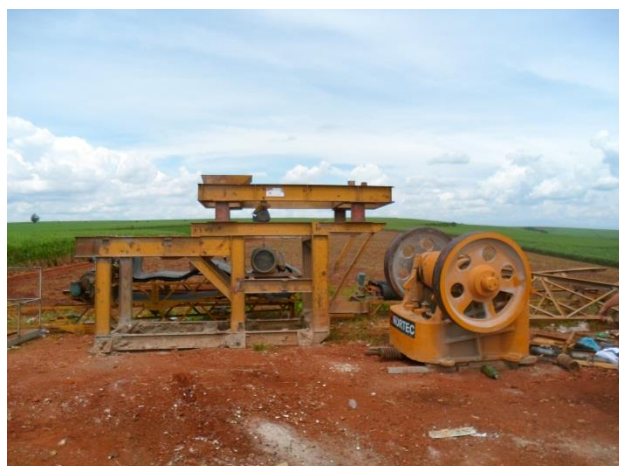
Foto 4.29 - Instalação do britador
