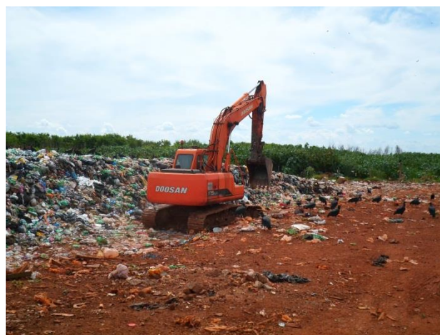
Foto 4.18 - Viso geral da esto de transbordo
