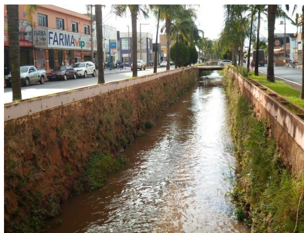
Foto 4.34 - Canalização do córrego Sul
