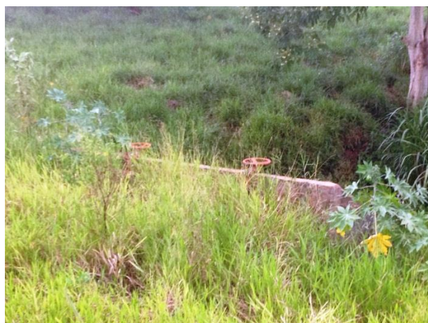
Foto 4.38 - Bacia de detenção – córrego Água Vermelha
