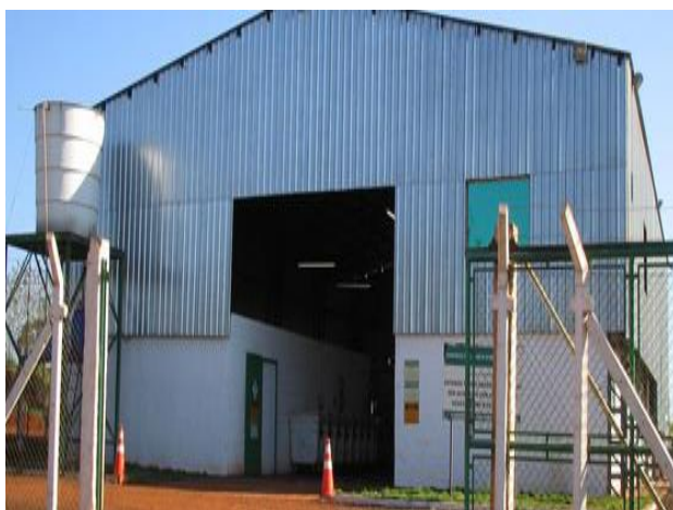
Foto 4.31 - Unidade de Tratamento NGA
