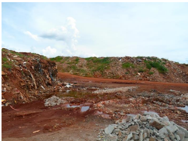
Foto 4.27 - Visão geral do Aterro de Inertes
