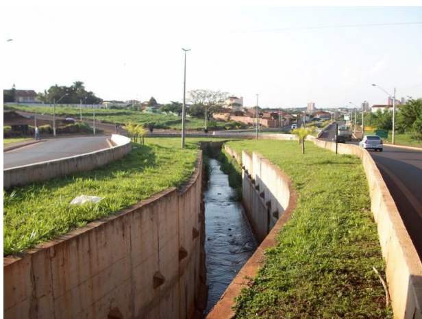
Foto 4.33 - Canalização do córrego Água Vermelha
