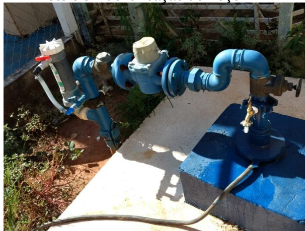
Foto 3.10 - Identificação do Poço: P13
