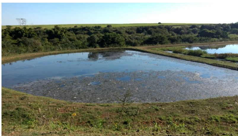
Foto 3.41 - Vista geral – Lagoa (ETE Pau d'Alho)
