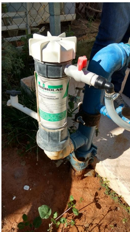
Foto 3.23 – Desinfecção no poço através de dosador automático de Flúor e Cloro
