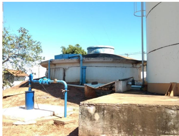
Foto 3.2 - Identificação do Poço: P02
