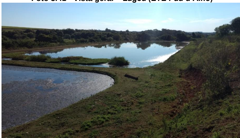
Foto 3.42 - Vista geral – Lagoa (ETE Pau d'Alho)
