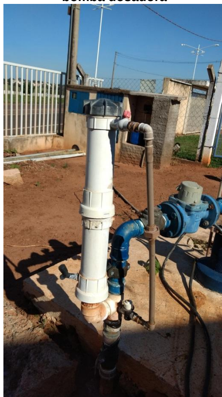
Foto 3.24 – Desinfecção no poço através de dosador automático de Flúor e Cloro
