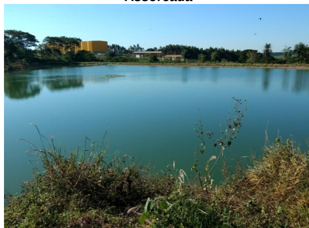
Foto 3.37 – Vista geral – Lagoa (ETE Baixão)
