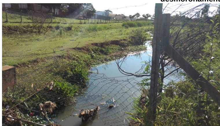
Foto 3.53 – Fim da escada hidráulica – reservatório de retenção
