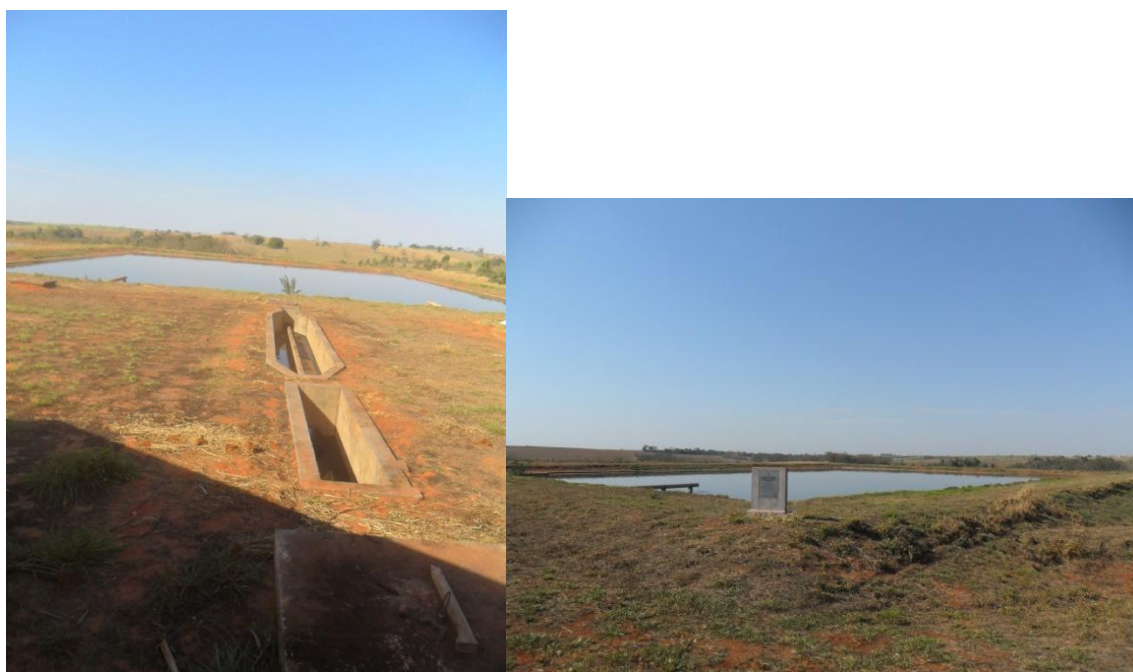
Fotos da ETE (Estação de tratamento de Efluentes) Rondon.
