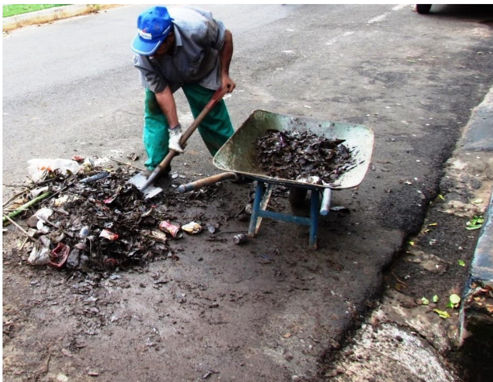
Funcionário retirando material da boca de lobo.
