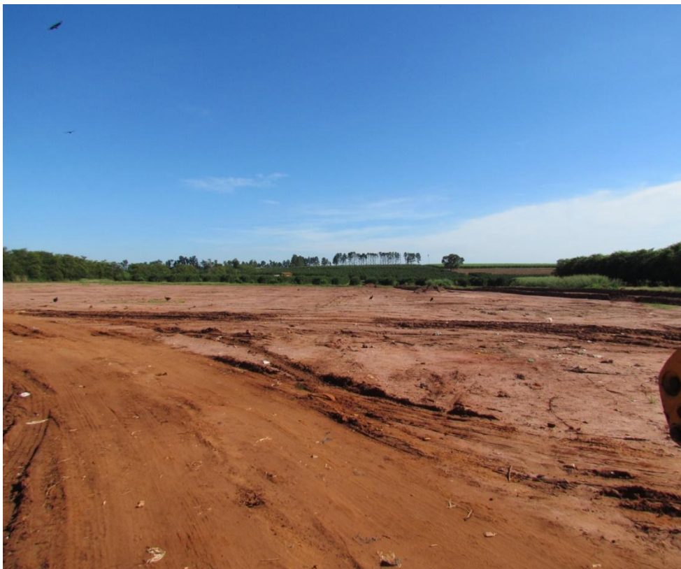
Área contígua ao aterro pronta para ser utilizada, aguardando aprovação pela CETESB para operação.
