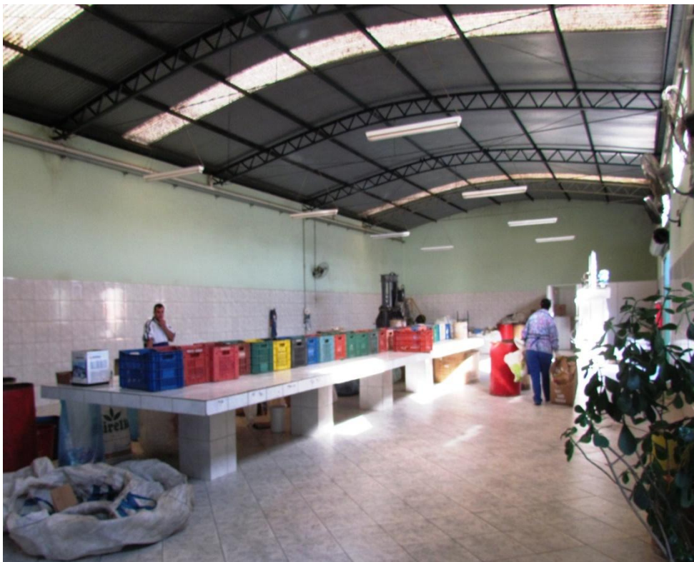
Centro de triagem de Corumbataí. s/p
