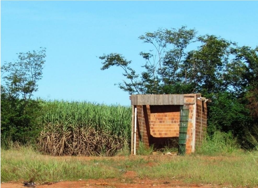
Entrada do aterro.
