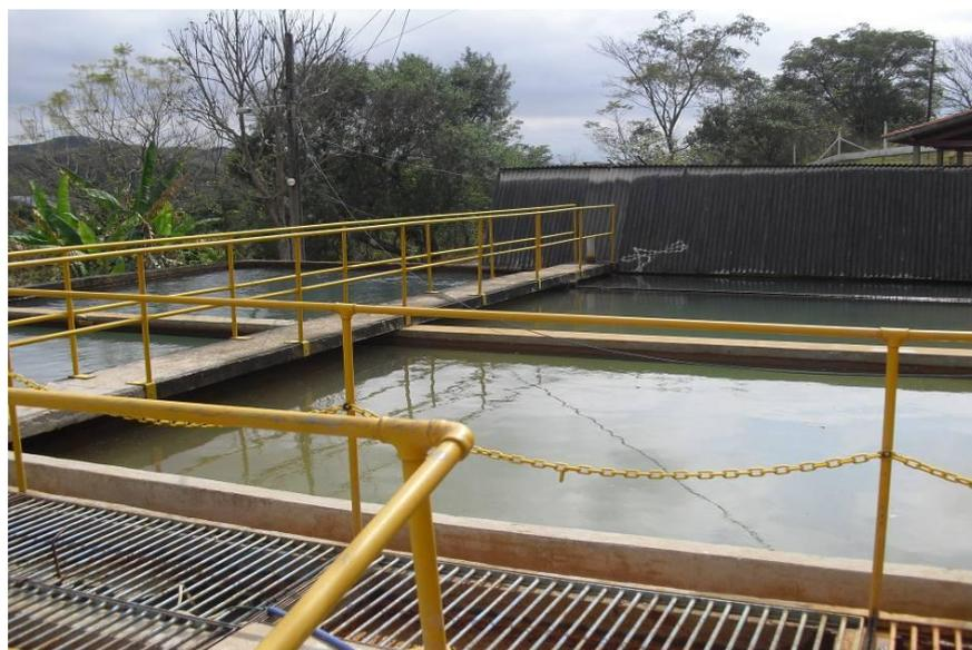
**Foto 06 – Decantador e Tanque de armazenamento de água decantada.**
