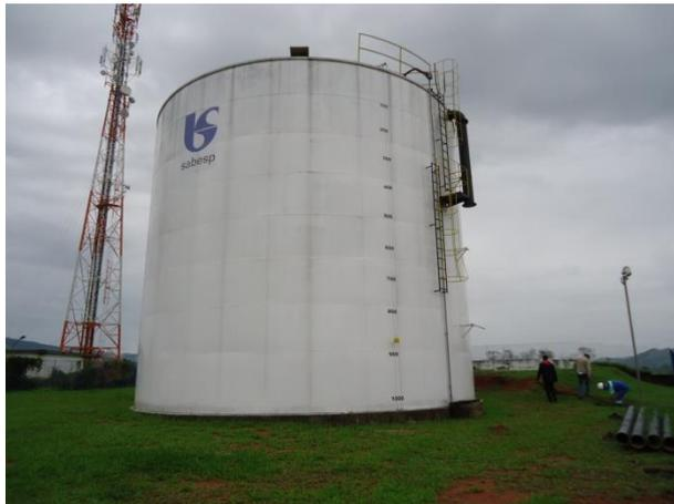
Foto 4.6 – Reservatório Metálico 1000m<sup>3</sup>
