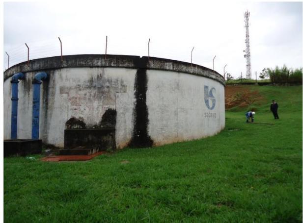
Foto 4.7 – Reservatório em Concreto 450m<sup>3</sup>
