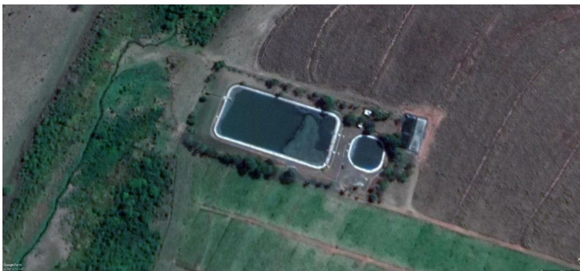
ETE do distrito sede de Sud Mennucci (SP)
