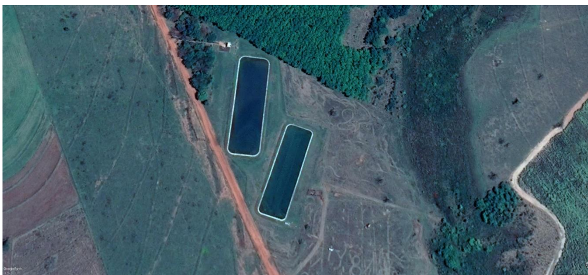
ETE do distrito de Bandeirantes D'Oeste, município de Sud Mennucci (SP)
