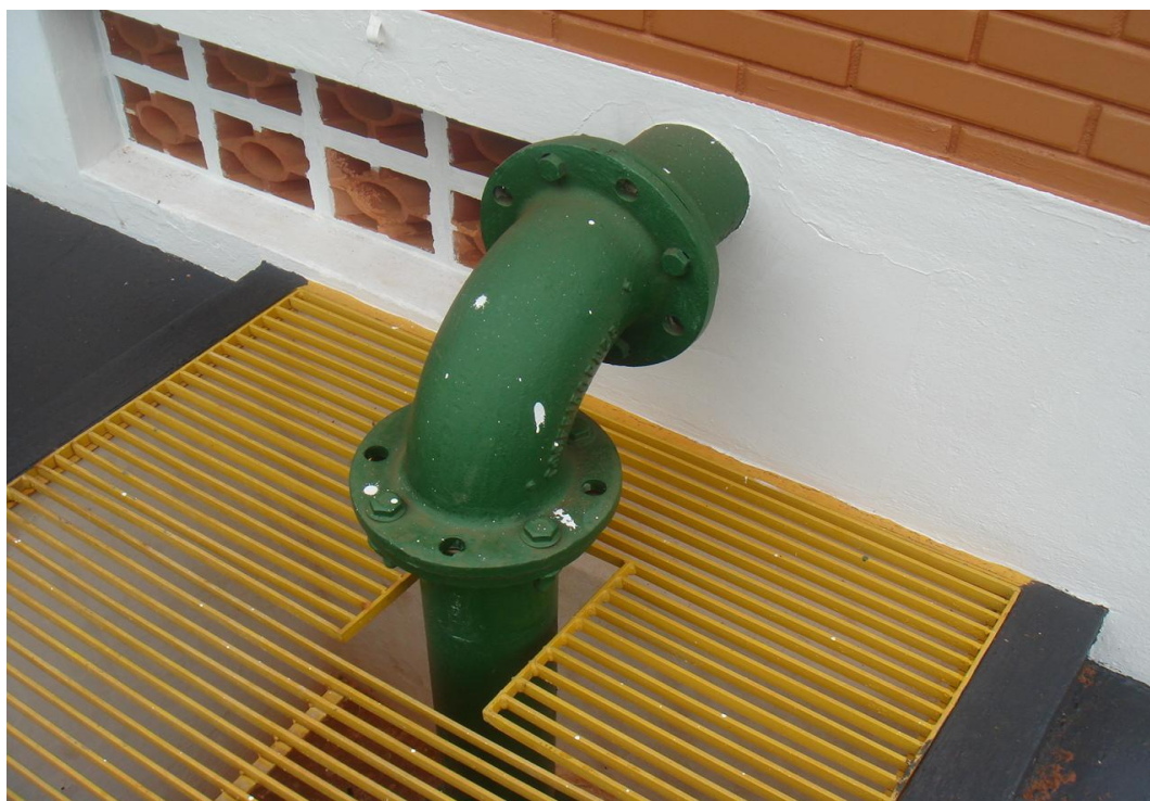
Figura 6. Adutora de água bruta (cor verde escura) chegando à cabine de desinfecção.
