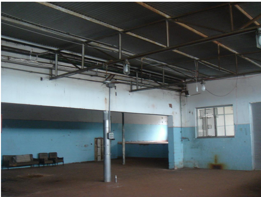
Figura 15. Instalações que fazem parte do projeto, onde se estuda implementar a coleta seletiva.
