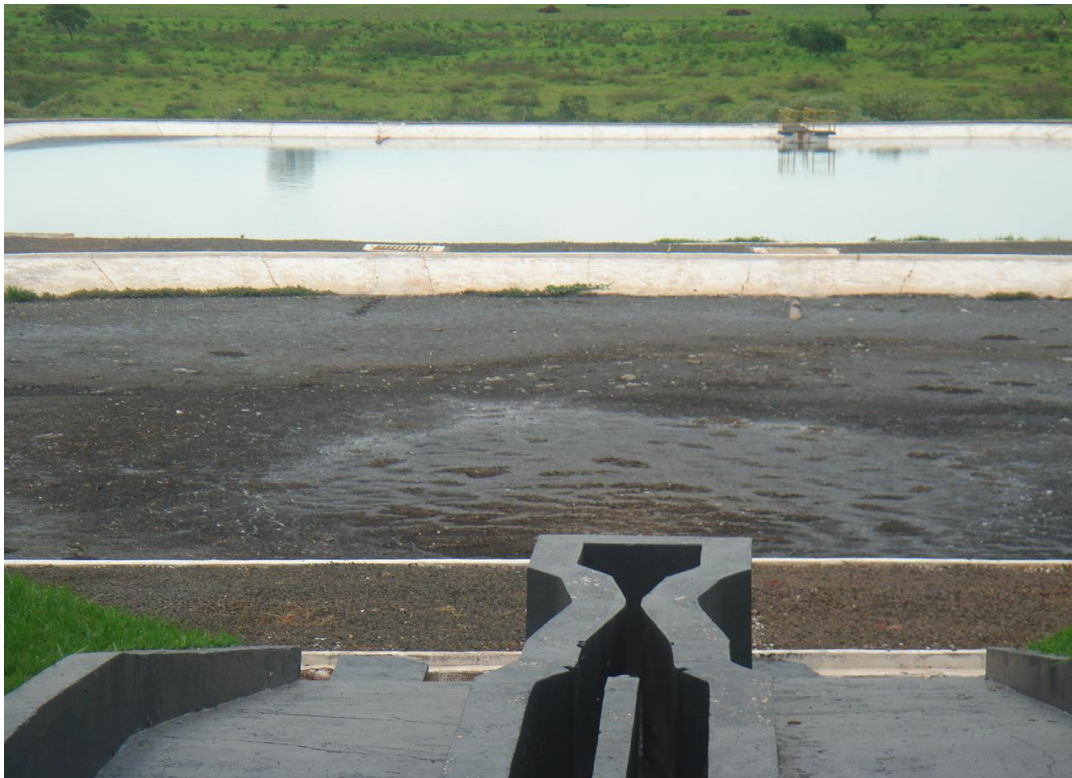
Figura11. Lagoa de tratamento de Sud Mennucci, com a calha Parshall em primeiro plano.
