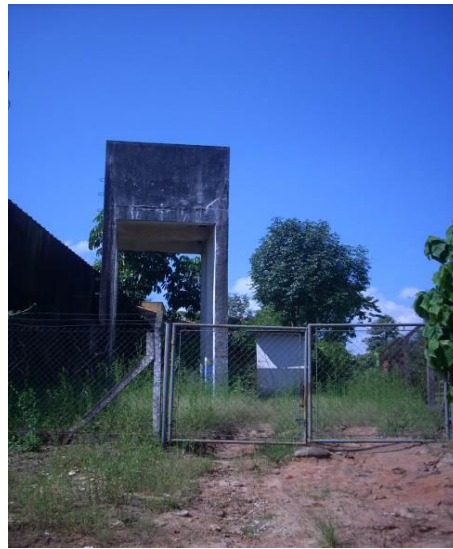
Figura 114 - Reservatório elevado em concreto.
