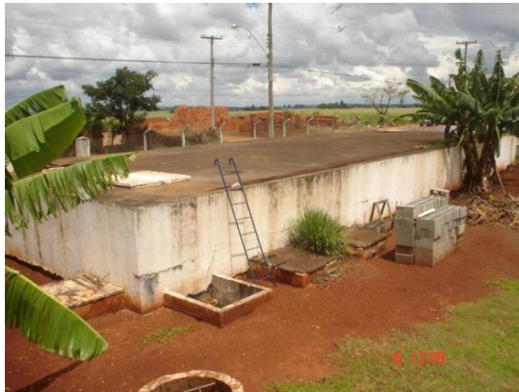
Figura 92 - Reservatório em concreto semi-enterrado (400m 3 ).
