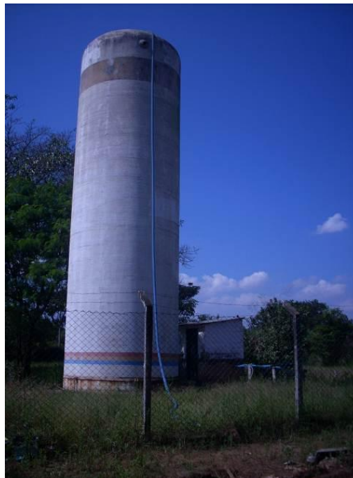
Figura 112 - Reservatório em fibra elevado.
