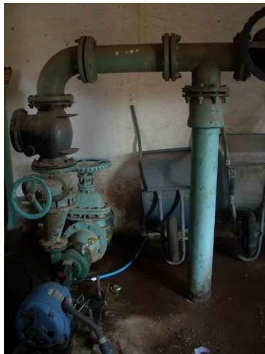
Figura 85 - Conjunto motor bomba 1.
