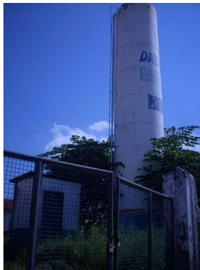
Figura 116 - Reservatório em aço elevado.
