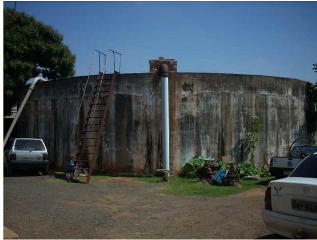
Figura 117 - Reservatório em concreto apoiado.
