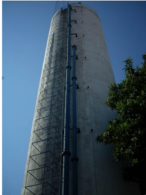
Figura 94 – Reservatório em concreto elevado.
