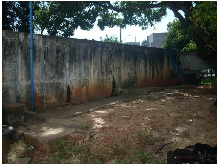
Figura 97 - Reservatório em concreto apoiado.
