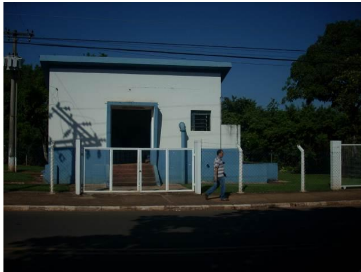
Figura 54 - Casa de bombas captação Marcelo.
