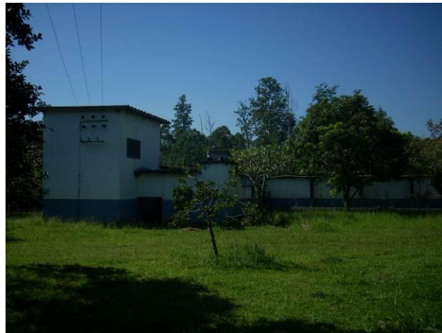
Figura 51 - Casa de bombas Captação 2 Horto.
