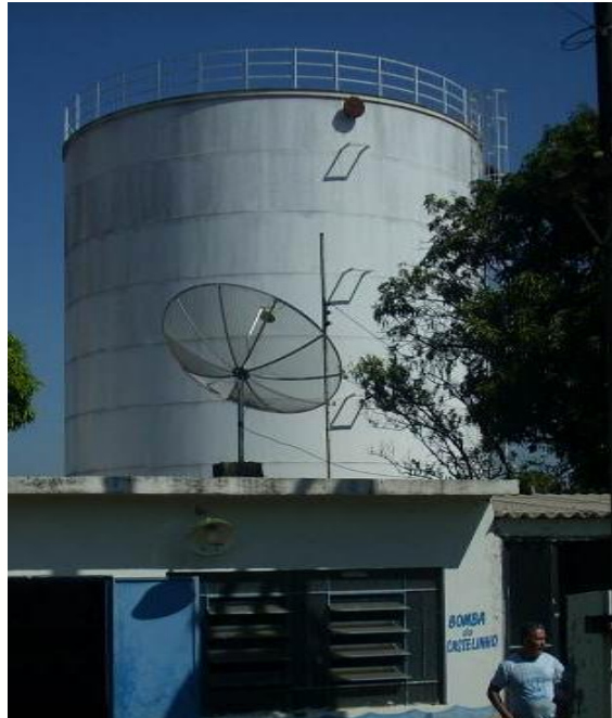
Figura 99 - Reservatório em aço elevado.
