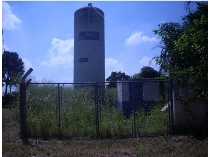
Figura 32 - Poço e Reservatório sistema isolado São Bento.
