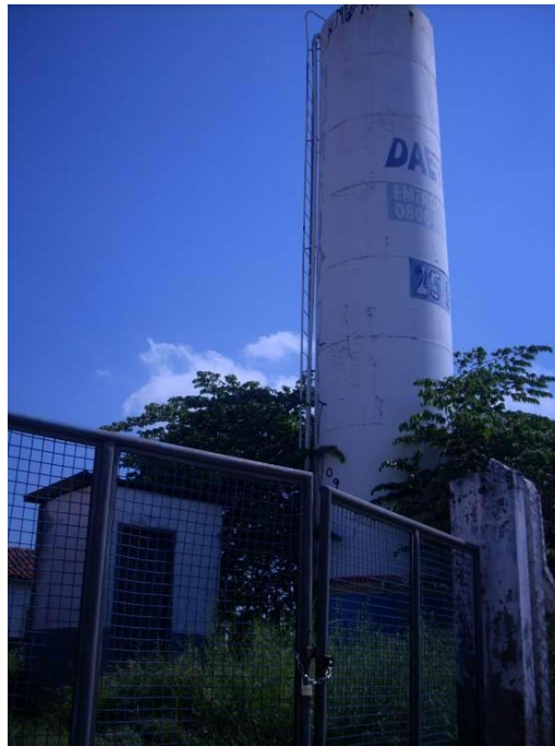
Figura 41 - Poço e Reservatórios Jardim Lucélia.
