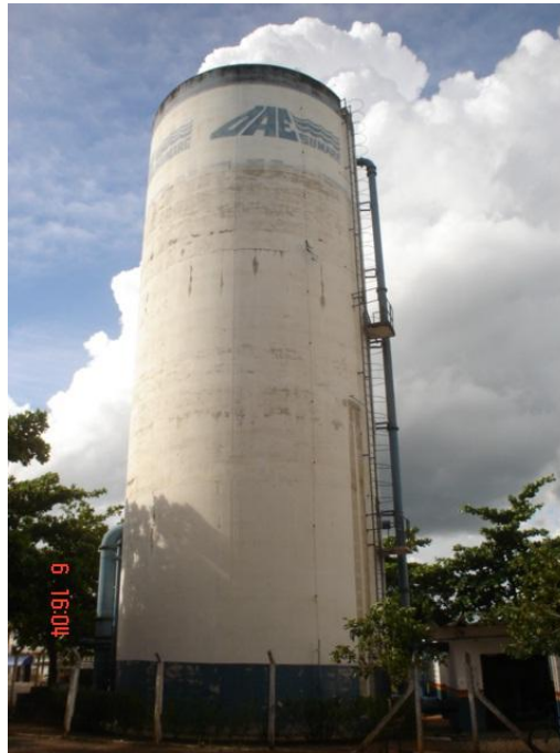
Figura 109 - Reservatório apoiado/elevado (câmaras sobrepostas).
