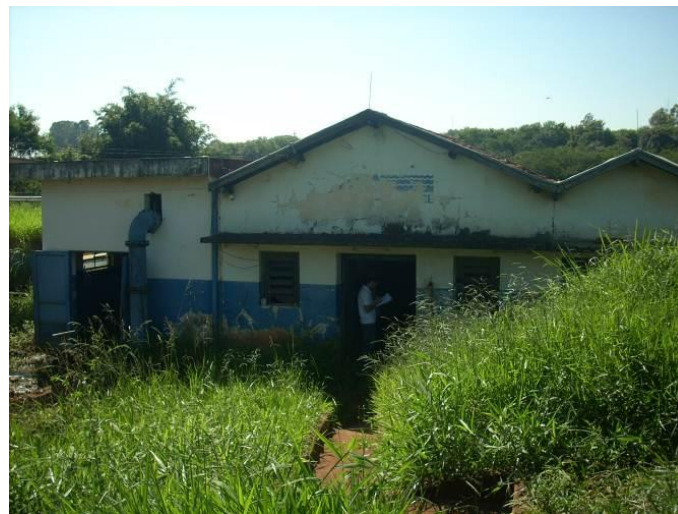
Figura 53 - Casa de bombas da captação 1.
