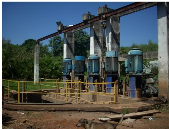
Figura 79 - Conjuntos motor bomba Captação Rio Atibaia.
