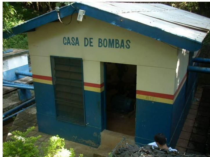
Figura 57 - Casa de bombas captação nascente do Marcelo.
