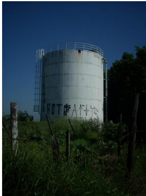
Figura 96 – Reservatório em aço elevado.
