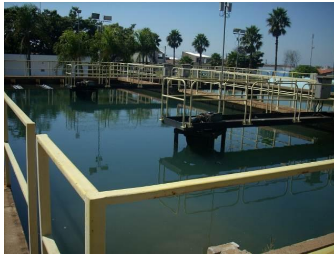
Figura 72 - Decantadores ETA 2 – Módulo 1.
