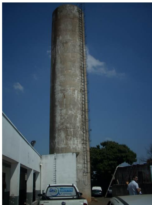
Figura 118 - Reservatório em concreto.
