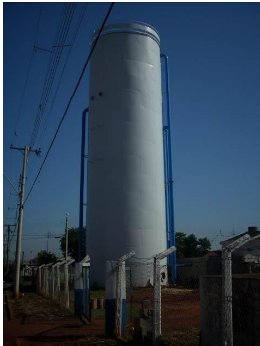
Figura 95 – Reservatório em aço elevado.
