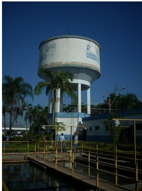
Figura 88 – Reservatório elevado 400 m 3 .
