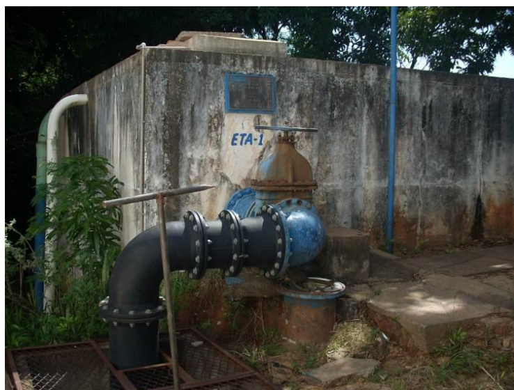
Figura 98 - Reservatório em concreto apoiado.
