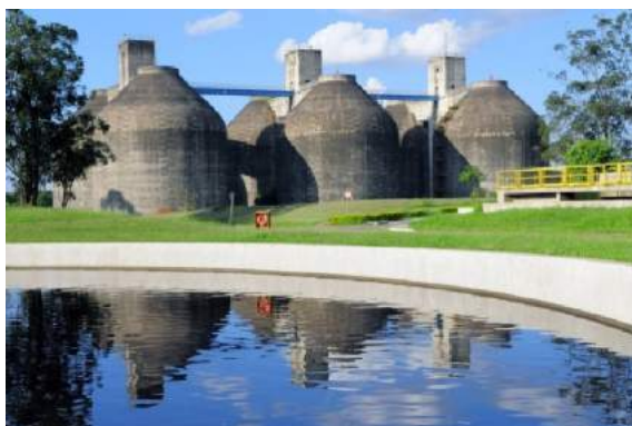
Figura 41 - Decantador Secundário e Digestores
