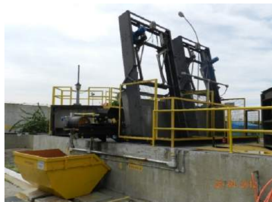
Figura 38 - Gradeamento grosso Fonte: Sabesp
