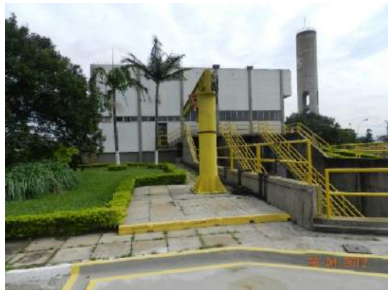
Figura 36 - Elevatória de Esgoto Final Fonte: Sabesp
