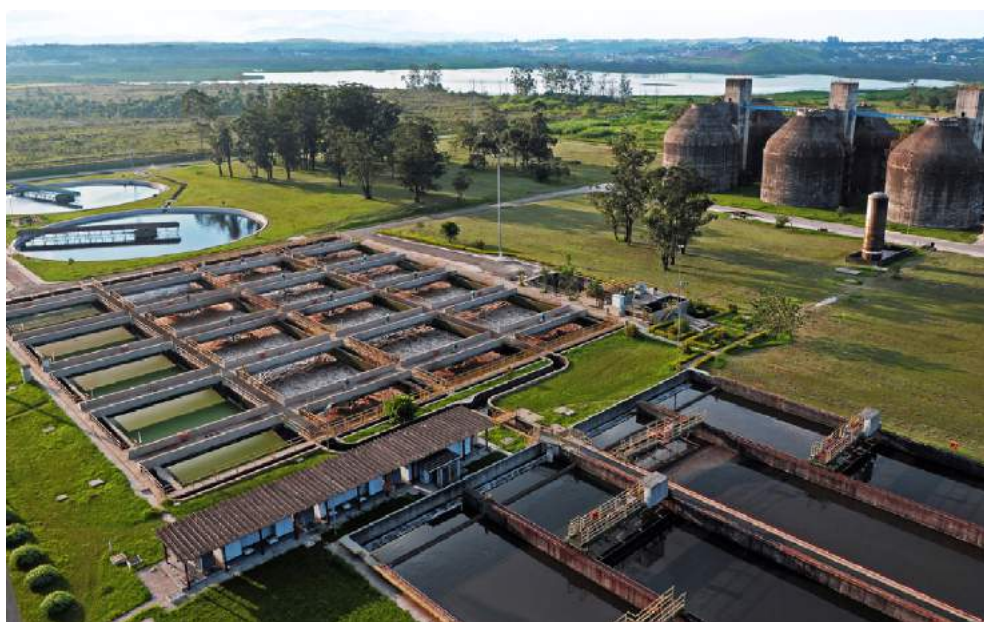
Figura 32 - Vista aérea da ETE Suzano
