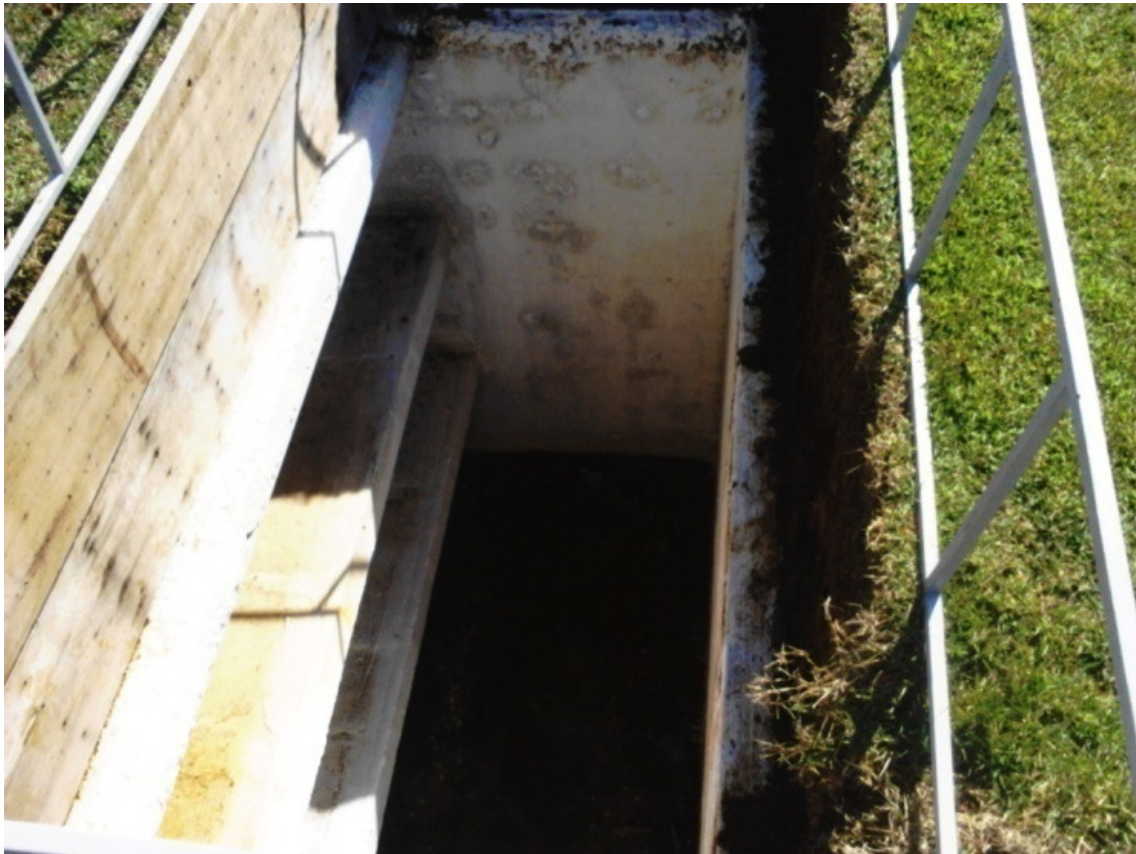
Figura 63 – Cemitério Colina dos Ipês - Gavetas de cemitério tipo parque
