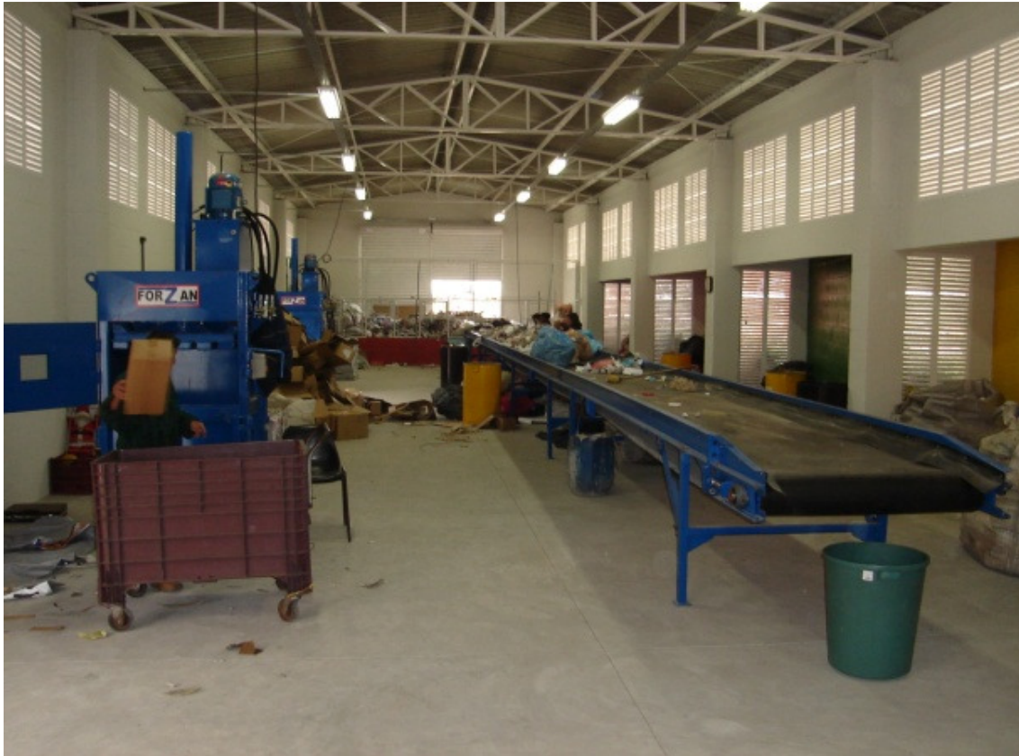
Figura 33 - Galpão de Triagem
