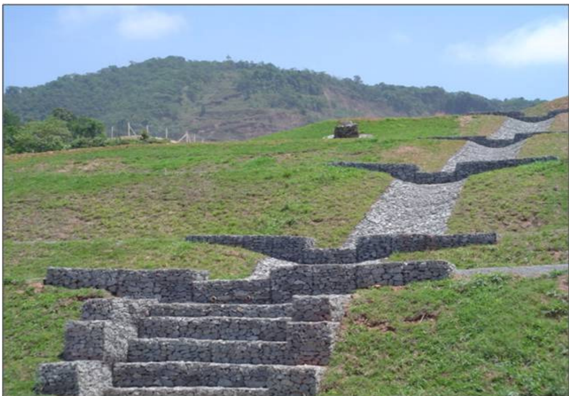
Figura 20 - Drenagem de águas pluviais. Fonte: Arquivo CDR Pedreira
