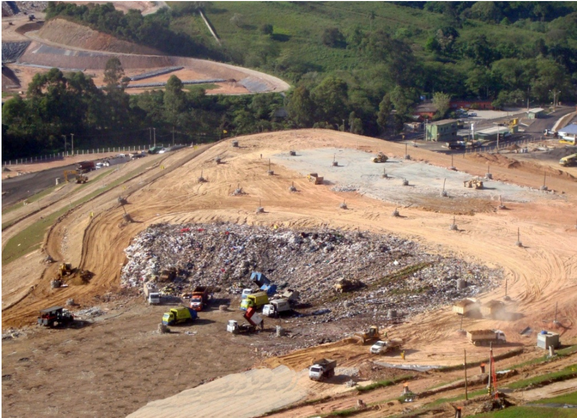
Figura 23 - Operação do aterro sanitário. Fonte: Arquivo CDR Pedreira
