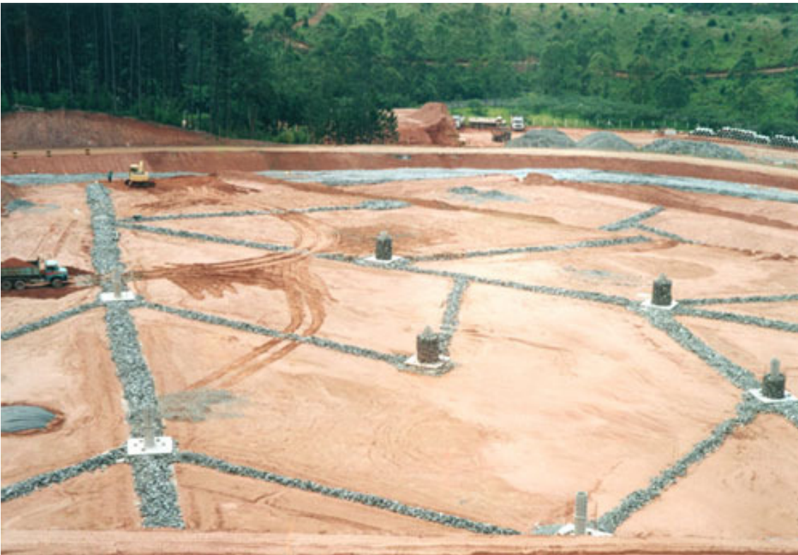
Figura 22 - Drenagem de gás e chorume. Fonte: Arquivo CDR Pedreira
