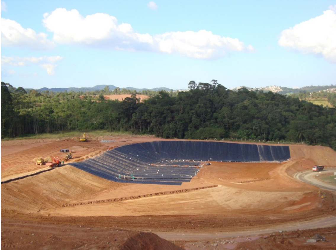
Figura 17 - Aplicação da geomembrana. Fonte: Arquivo CDR Pedreira
