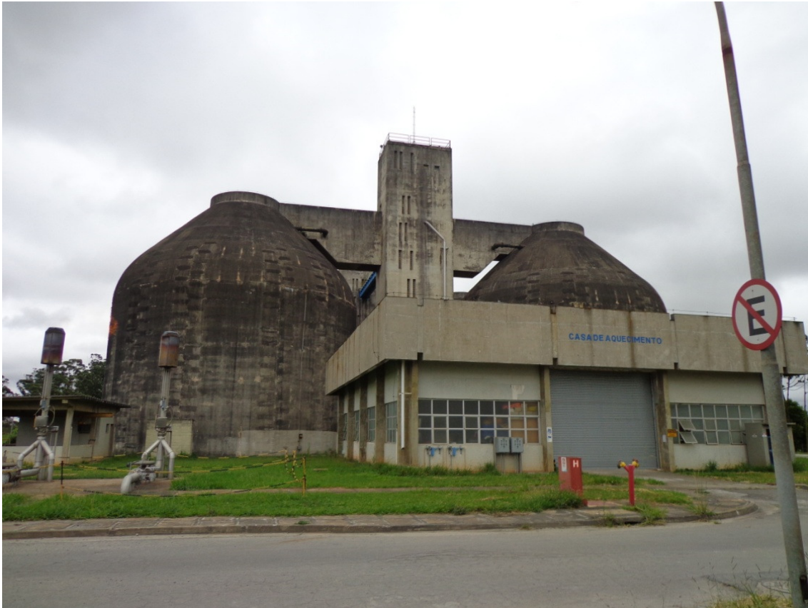
Figura 93 - Digestores anaeróbios, componentes do tratamento do lodo. Fonte: SMMA, 2013.
