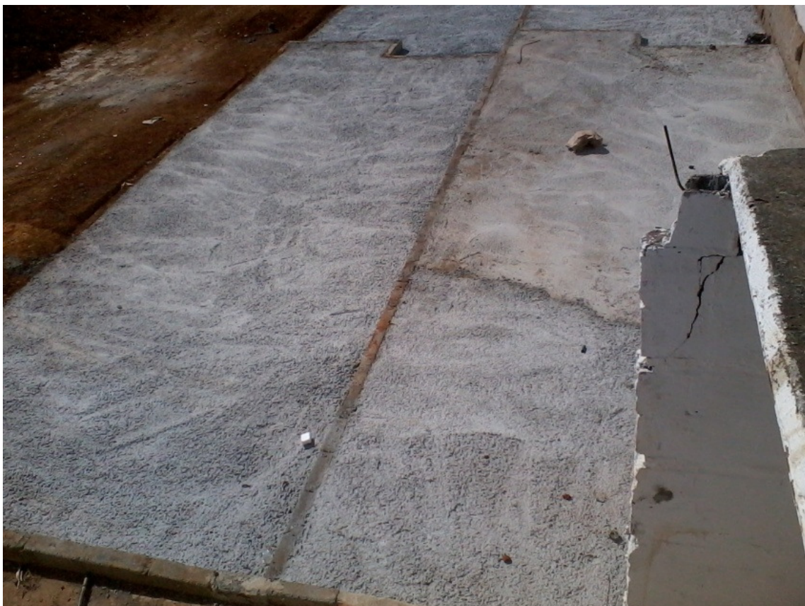
Figura 74 - Camada de concreto sobre o solo - Cemitério Colina dos Ipês.
