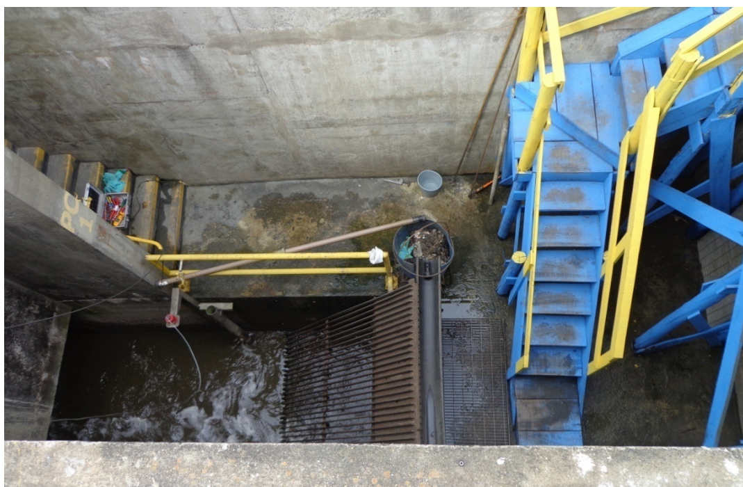
Figura 88 - Primeiro gradeamento do sistema de tratamento da ETE Suzano. Fonte: SMMA, 2012.
