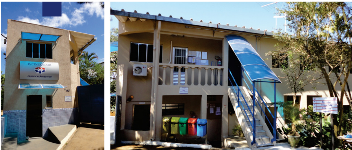
Figura 60 - Unidade de tratamento e destinação de resíduos da Pioneira
