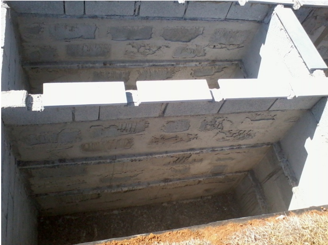
Figura 73 - Construção da sepultura - Cemitério Colina dos Ipês.
