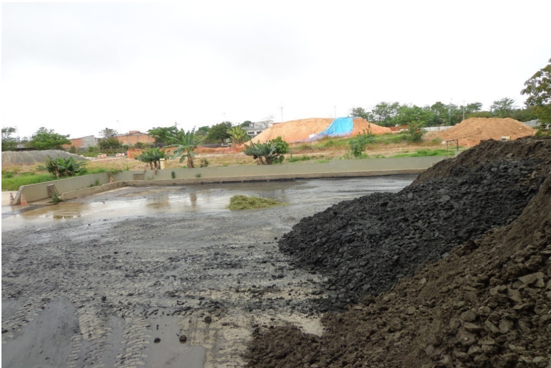
Figura 96 - Pátio de secagem natural de lodo. Fonte: SMMA, 2013.
