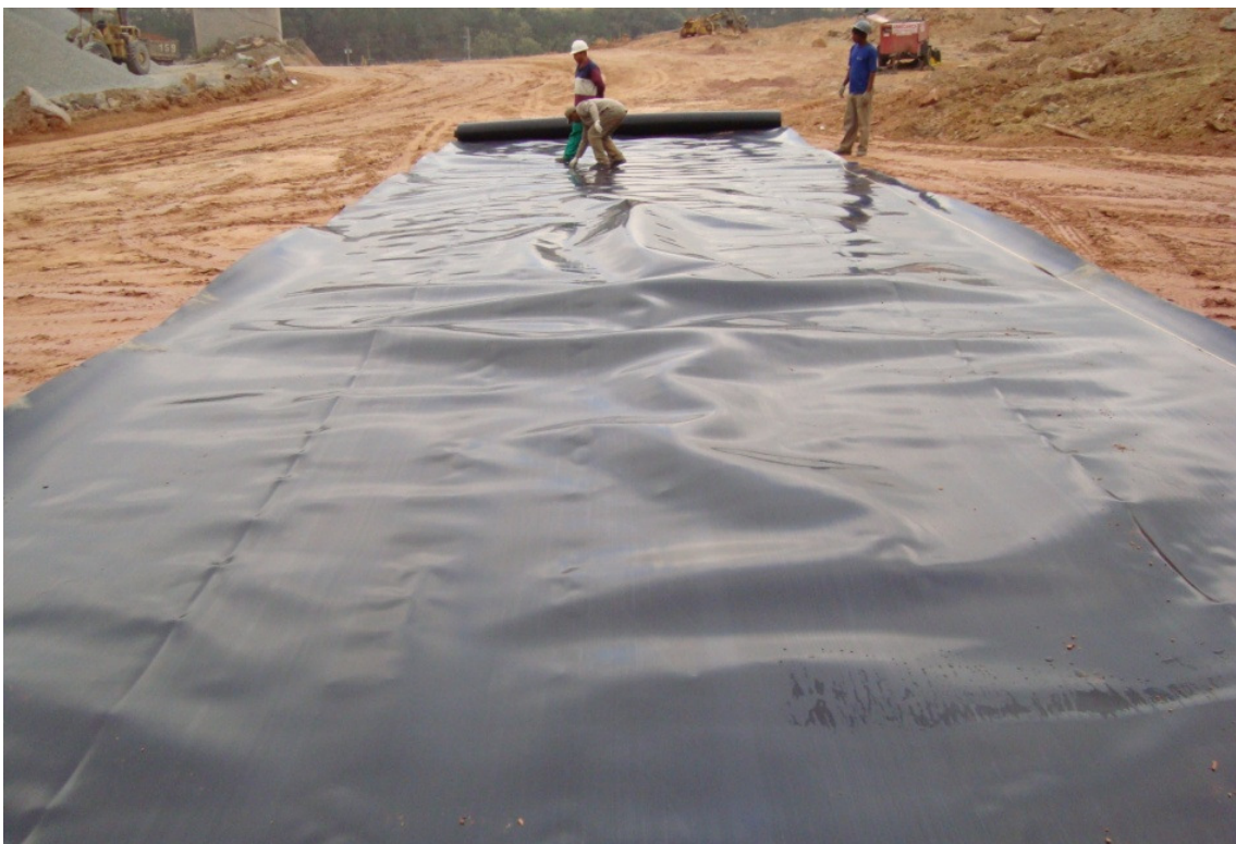
Figura 18 - Aplicação da geomembrana. Fonte: Arquivo CDR Pedreira
