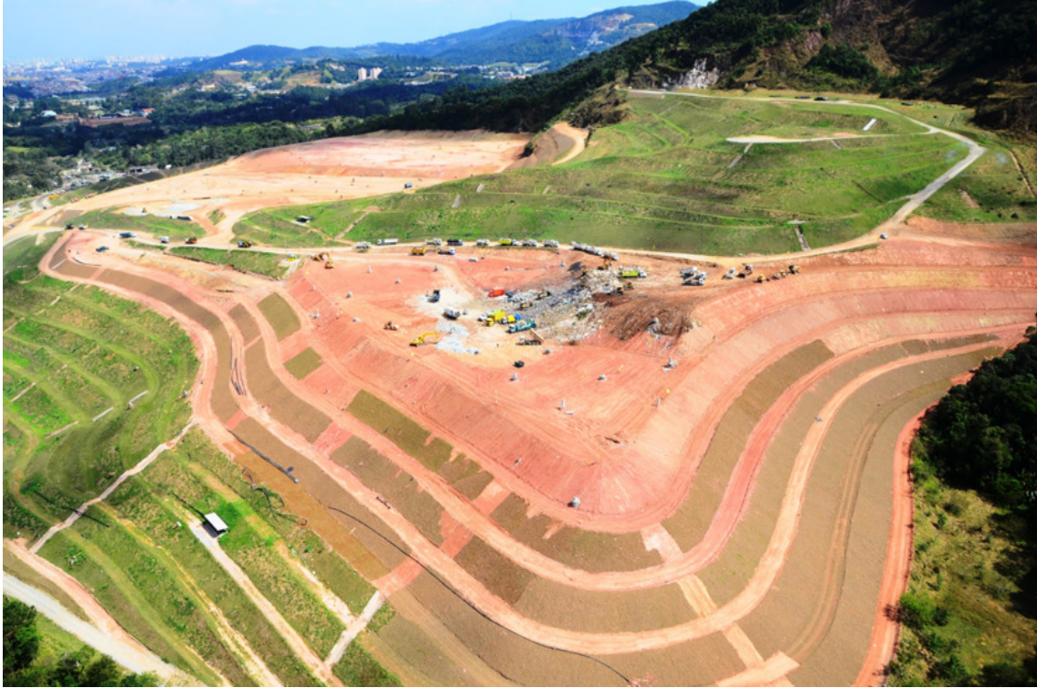
Figura 27 - Vista aérea do CDR Pedreira. Fonte: Arquivo CDR Pedreira
