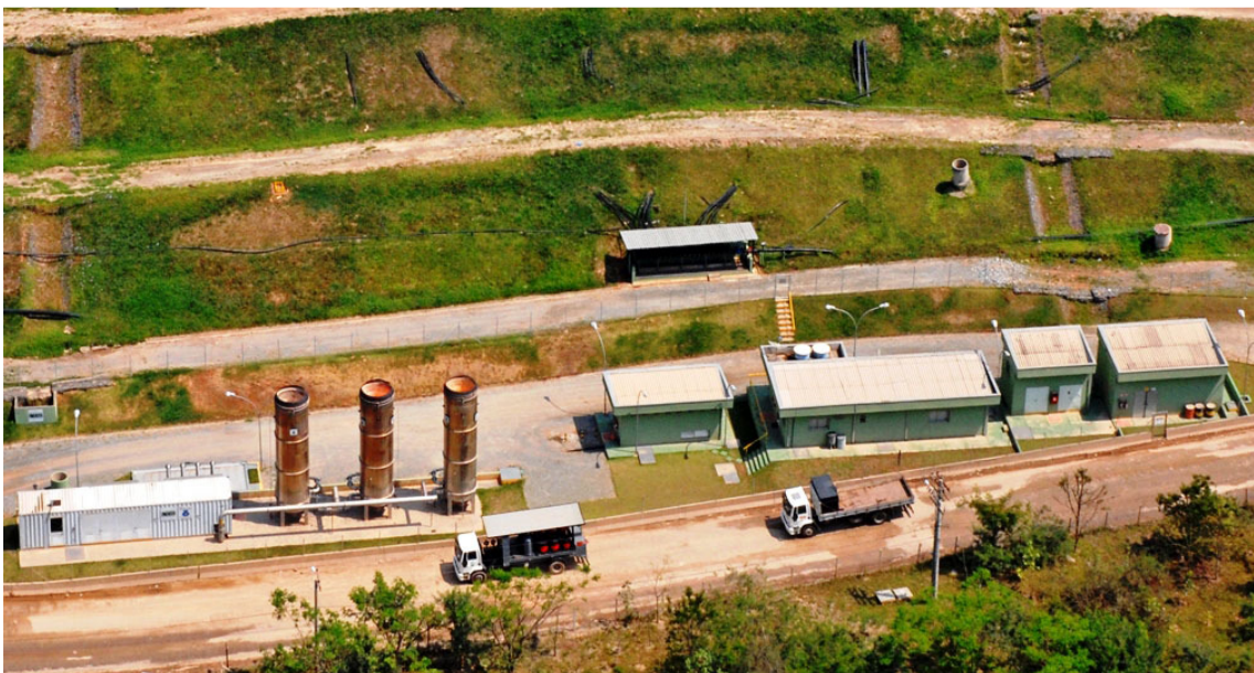
Figura 16 - Central de Biogás. Fonte: Arquivo CDR Pedreira
