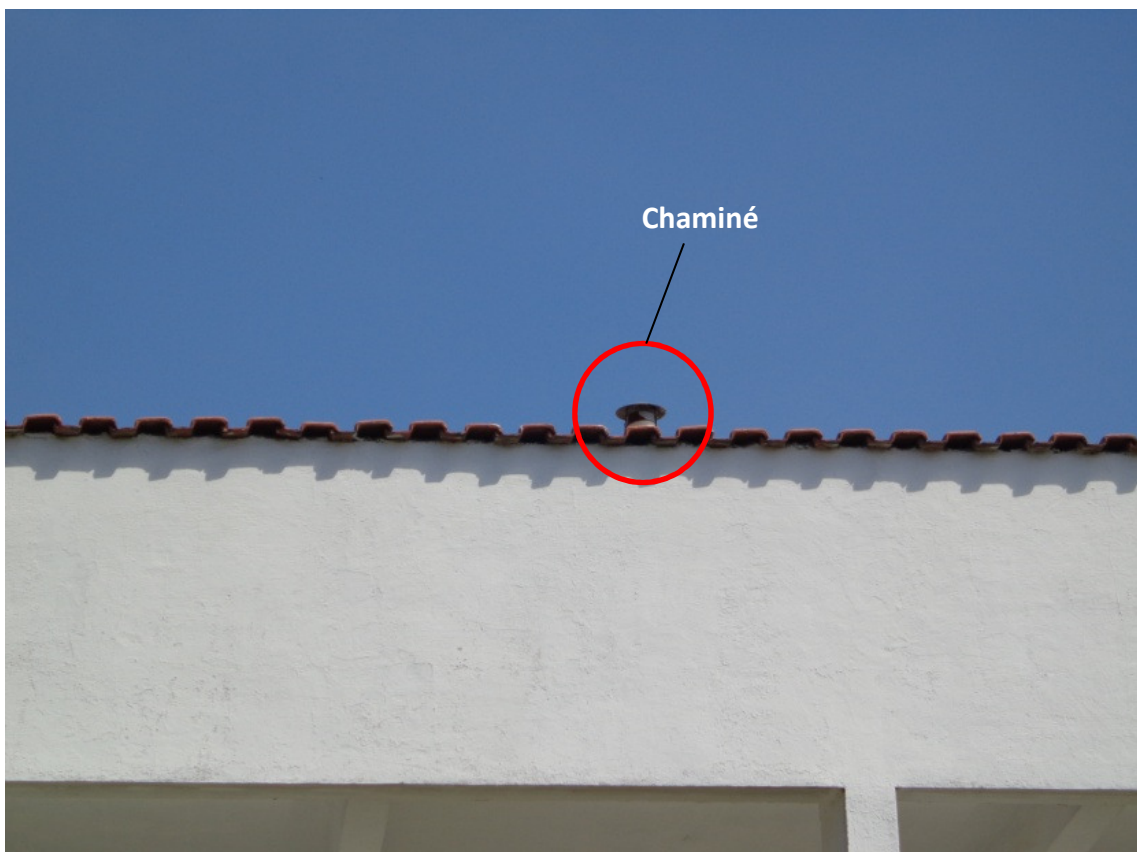
Figura 79 - Chaminé para escape de gases - Memorial do Alto Tietê.
