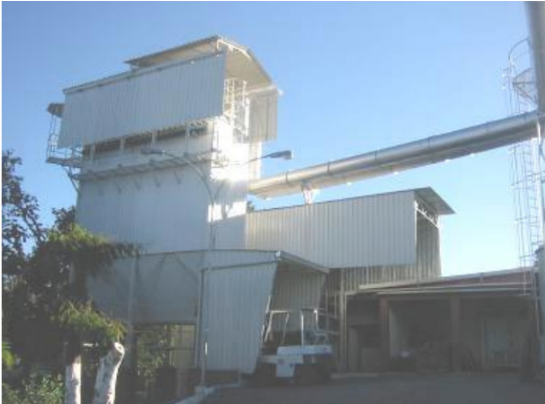
Figura 59 - Unidade de tratamento e destinação de resíduos da Pioneira
