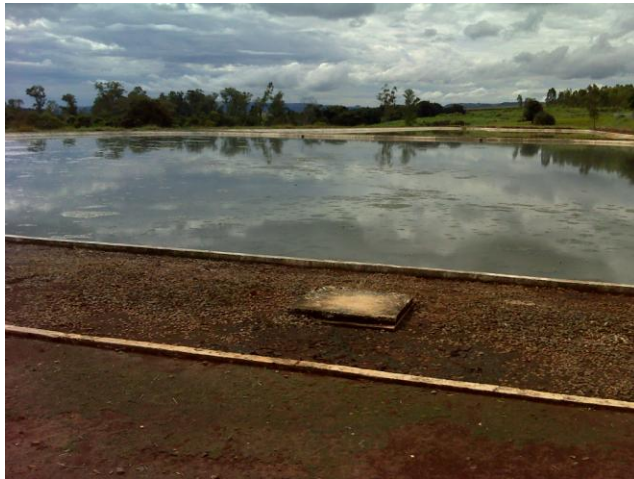
FOTO 4.22 – LAGOA ANAERÓBIA DA ETE TAGUAÍ
