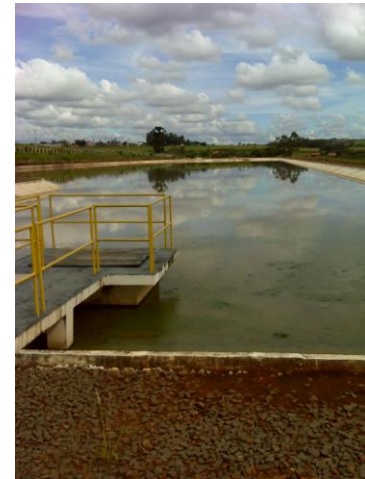
FOTO 4.23 – LAGOA FACULTATIVA DA ETE TAGUAÍ
