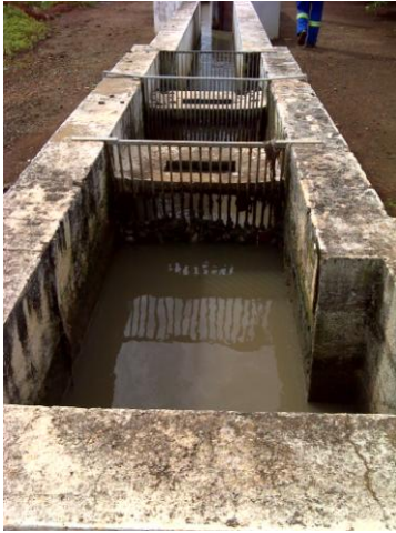
FOTO 4.19 – GRADEAMENTO DA ETE TAGUAÍ
