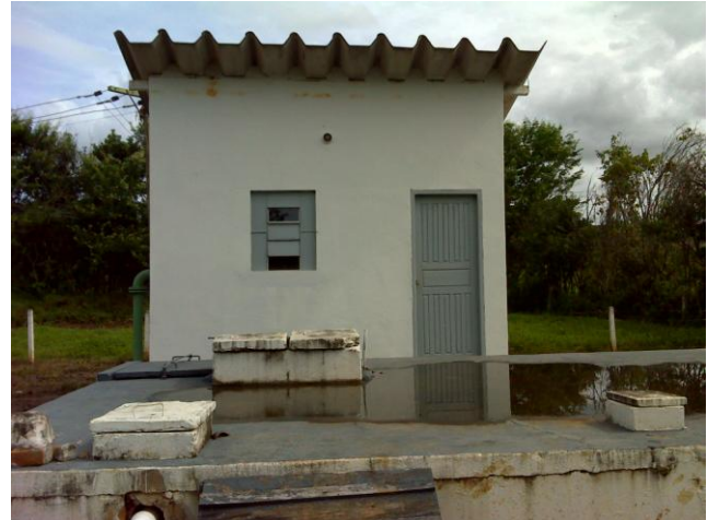
FOTO 4.7 – ESTAÇÃO ELEVATÓRIA DE ÁGUA BRUTA EEAB DRENOS
