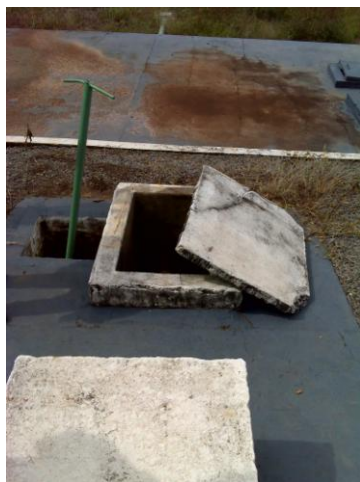
FOTO 4.15 - RESERVATÓRIO P1 ENTERRADO
