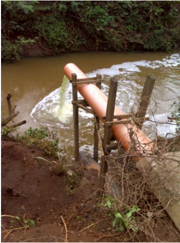
FOTO 4.24 – LANÇAMENTO DO EFLUENTE FINAL TRATADO NO RIBEIRÃO FARTURA
