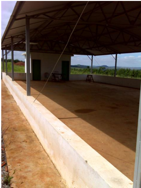
FOTO 4.28 – FUTURO GALPÃO DE TRIAGEM LOCALIZADO JUNTO AO ATERRO SANITÁRIO
