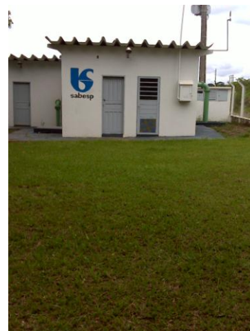
FOTO 4.9 – VISTA EXTERNA DA ESTAÇÃO ELEVATÓRIA DE ÁGUA BRUTA EEAB P3
