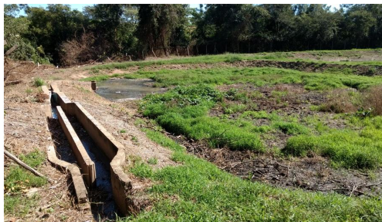
Foto 3.33 – Tratamento Preliminar e Lagoa Anaeróbia
