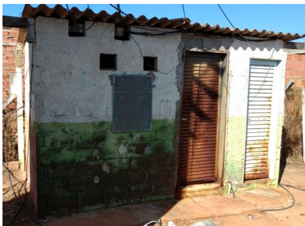
Foto 3.16 – Unidade de tratamento do Poço 03
