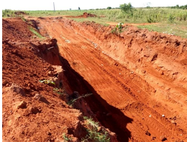
Foto 3.40 – Vista do aterro sanitário – Vala
