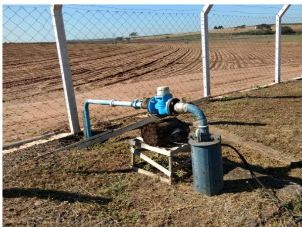
Foto 3.13 - Identificação do Poço: Poço Porto Belo
