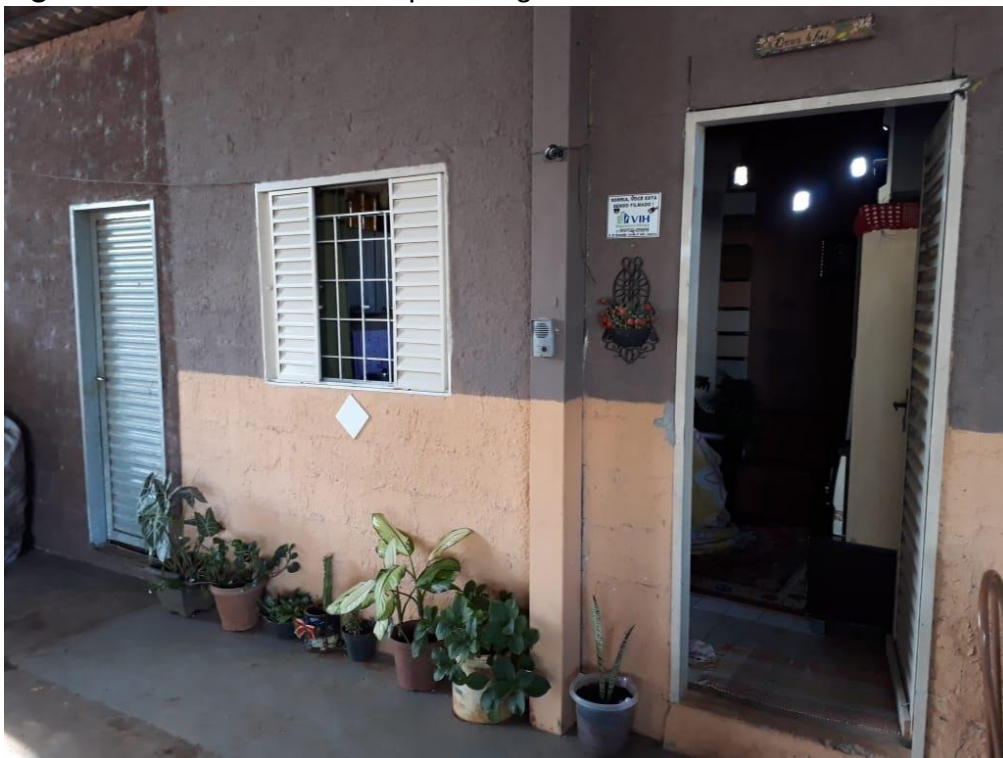
Figura 19 - Escritório do Galpão triagem de materiais recicláveis
