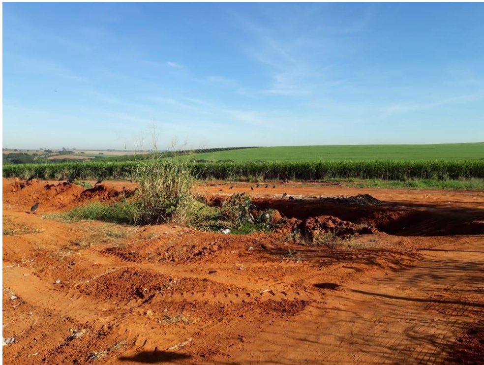
Figura 7 – Visão Geral do aterro em valas
