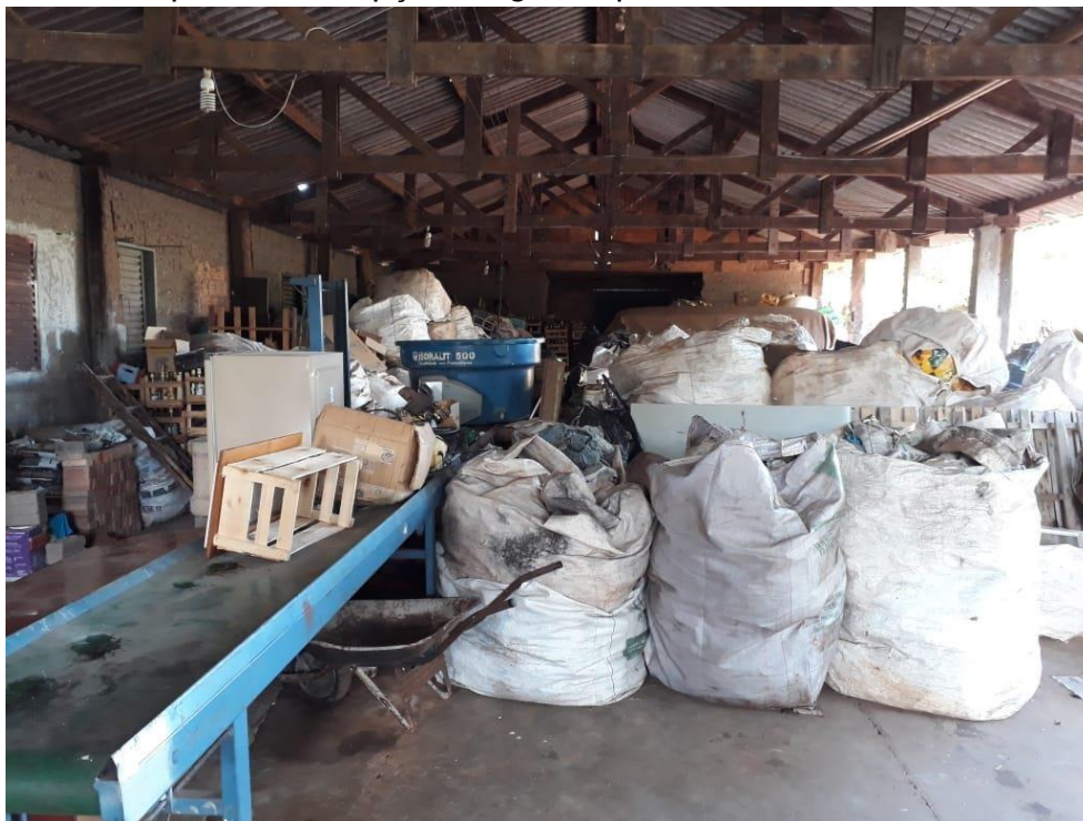
Figura 18 – Galpão de Recepção triagem e prensa de materiais recicláveis
