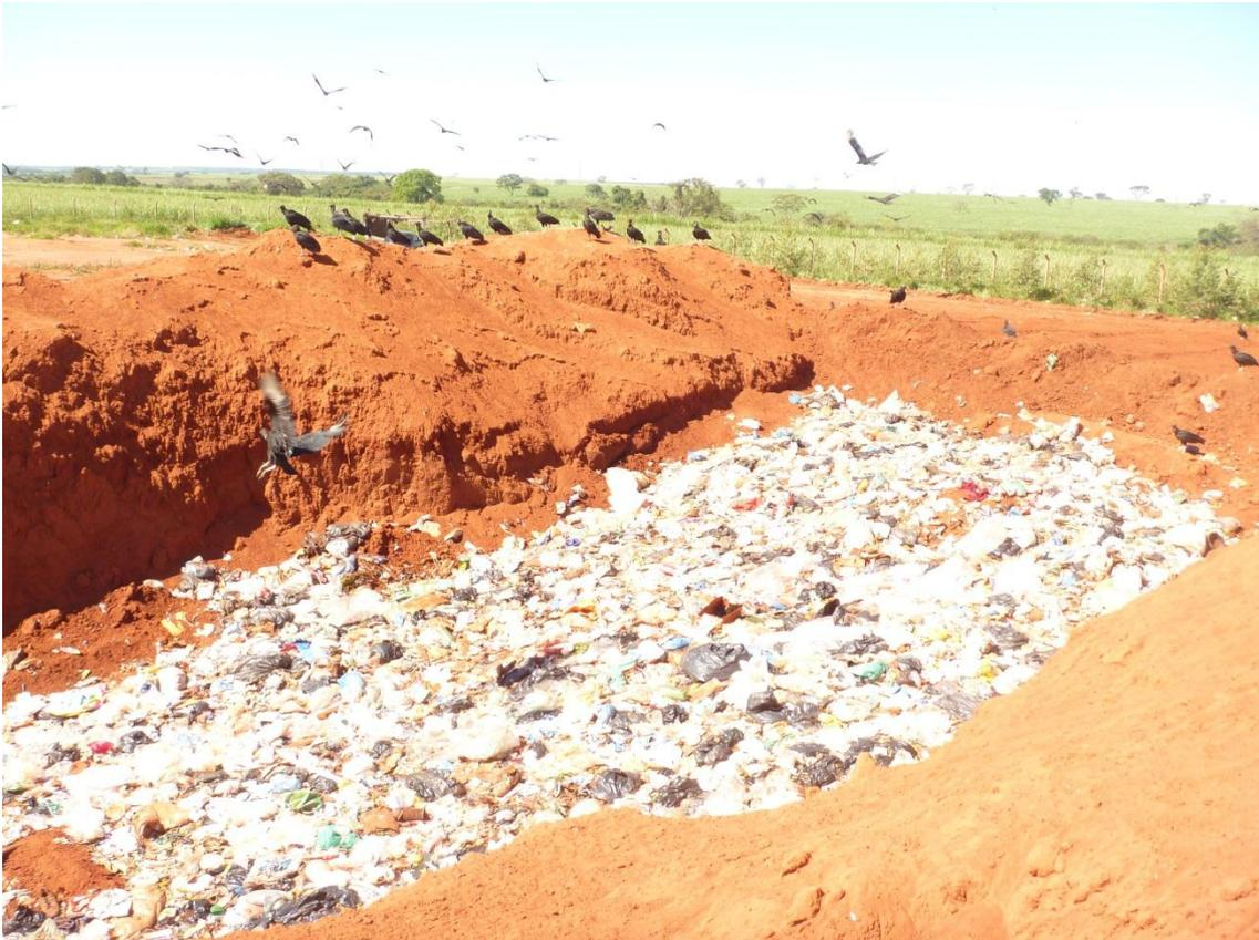
**Figura 47 – Lixo compactado no interior da vala aguardando cobertura**
