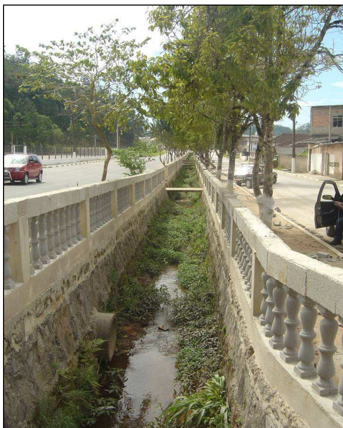
Foto 4 – Canalização do Córrego da Onça – Obra em Conclusão
