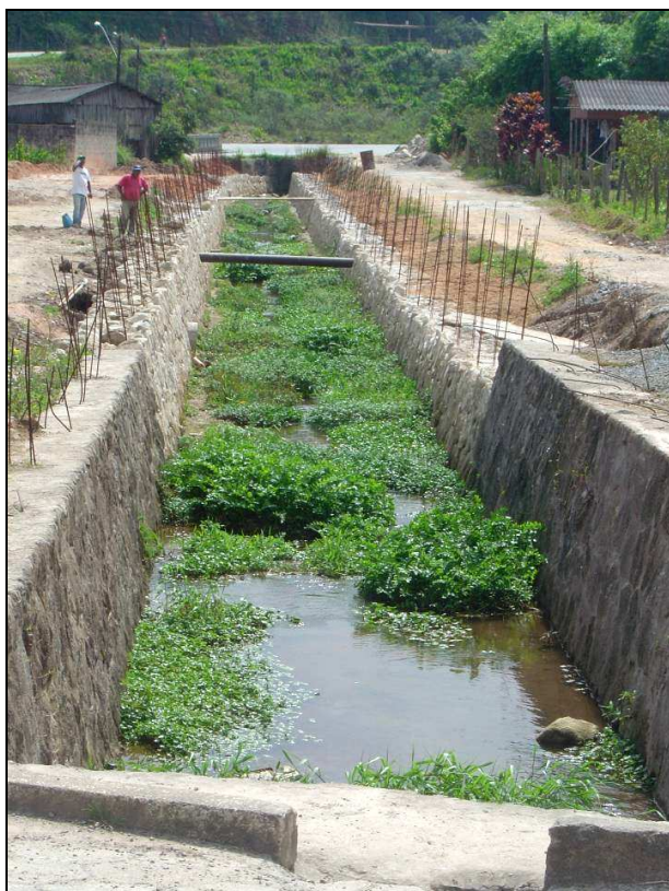
Foto 6 – Córrego Lajeado – Obra em Andamento
