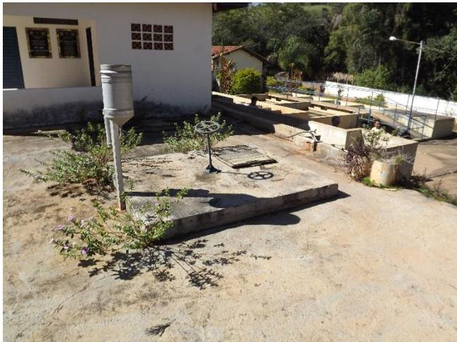
**Foto 3.15 – Vista geral da ETA Nova (ao fundo) e do registro de manobra para envio de água bruta para ETA.**
