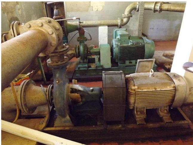
**Foto 3.23 – Detalhes de 2 (dois) conjuntos motobomba de recalque na EEAT.**
