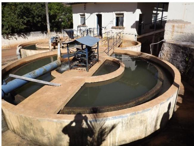
Foto 3.7 – Vista geral do floclador (parte interna) e decantador (parte externa).
