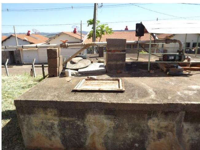
Foto 3.37 – Detalhe do sistema de reservação e elevatória para o RAP Renascer (desativado no momento).
