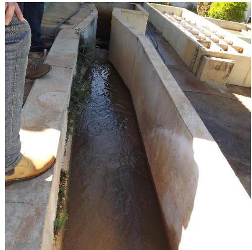
**Foto 3.16 – Vista geral da Calha Parshall seguida do tanque de acumulação.**
