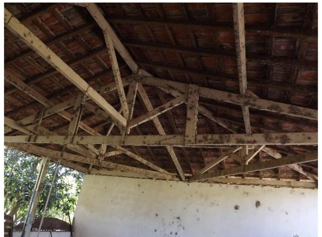
Foto 3.42 – Detalhe dos microorganismos na cobertura da EEE Conceição.
