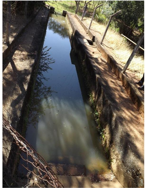
**Foto 3.4 – Caixa de areia após a tomada de água**
