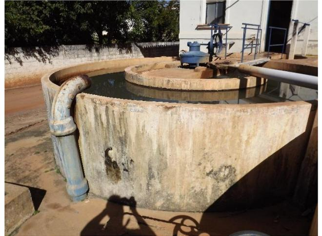
**Foto 3.14 – Detalhe da adutora de ligação do módulo 2 quebrada.**
