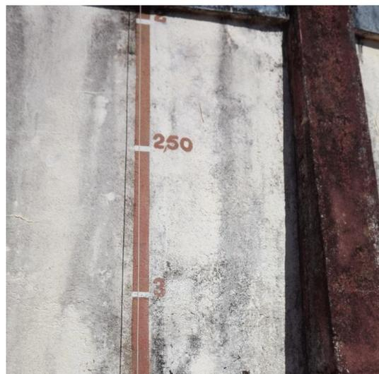
Foto 3.30 – Detalhe do macromedidor de nível do RAP Central.
