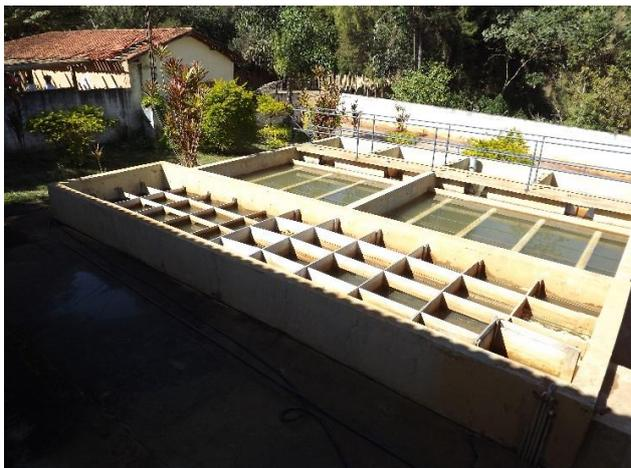
Foto 3.17 – Vista geral do flocculador (frente) e decantador (fundo).
