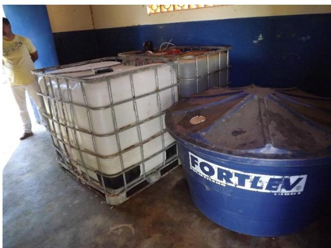
Foto 3.11 – Detalhe do armazenamento de hipoclorito de sódio para pós-cloração.
