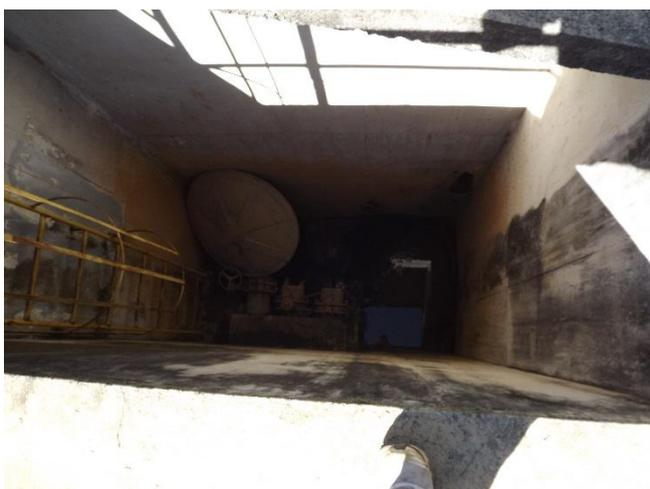
Foto 3.21 – Detalhe do sistema de retrolavagem de filtros e decantadores com problemas de acesso.
