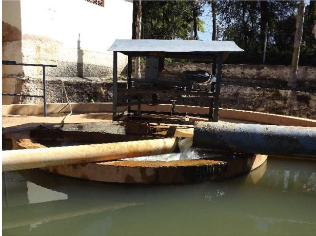
**Foto 3.13 – Detalhe da interligação do módulo 1 e módulo 2 da ETA Antiga.**
