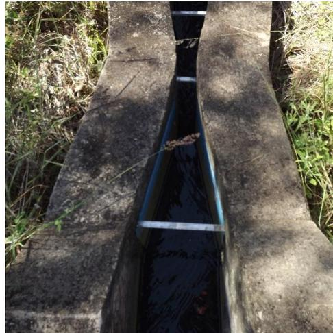
**Foto 3.52 – Detalhe da Calha Parshall.**
