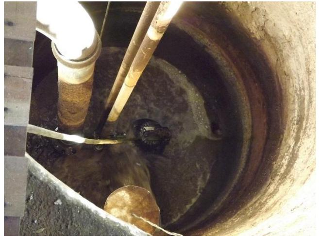
Foto 3.40 – Detalhe do poço de sucção e bomba submersa na EEE Conceição.
