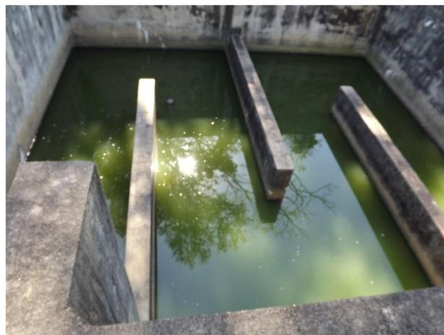
**Foto 3.54 – Detalhe do tanque de contato para desinfecção.**
