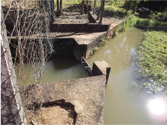
**Foto 3.3 – Detalhe da tomada de água para abastecimento (à esq.) e vegetação no lago da barragem (à dir.)**
