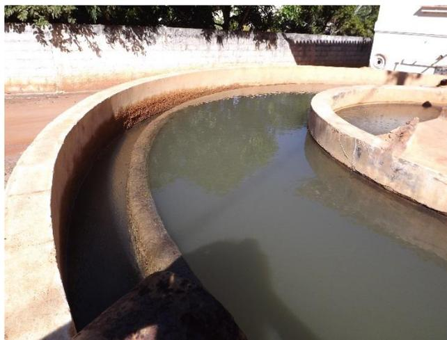
Foto 3.8 – Detalhe da tomada de água (camada externa) na saída dos decantadores
