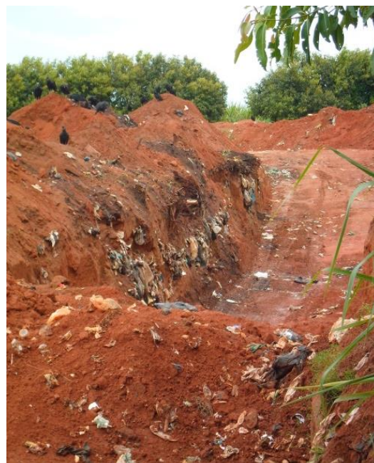
Foto 4.14 - Aterro em valas
