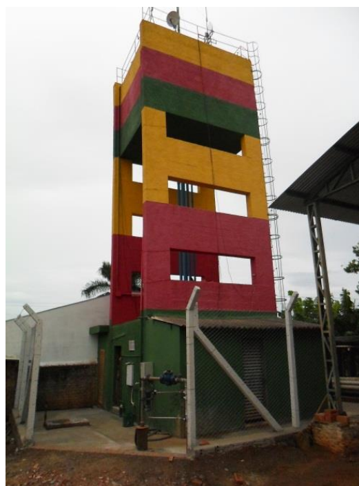
Foto 4.7 - Reservatório Paço Municipal
