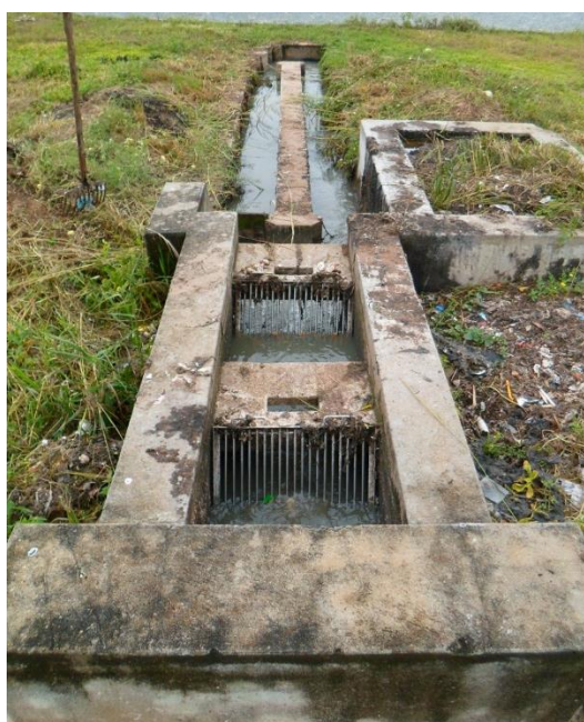
Foto 4.9 - Gradeamento e caixa de areia
