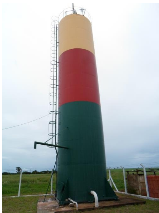
Foto 4.6 - Reservatório São João
