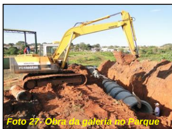
Foto 27- Obra da galeria no Parque
