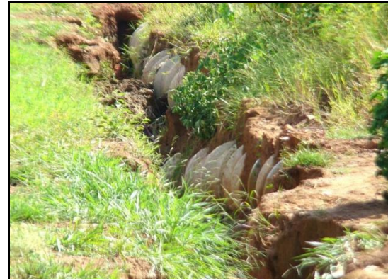
Foto 34- Emissário de esgotos, CECAP/2011.
