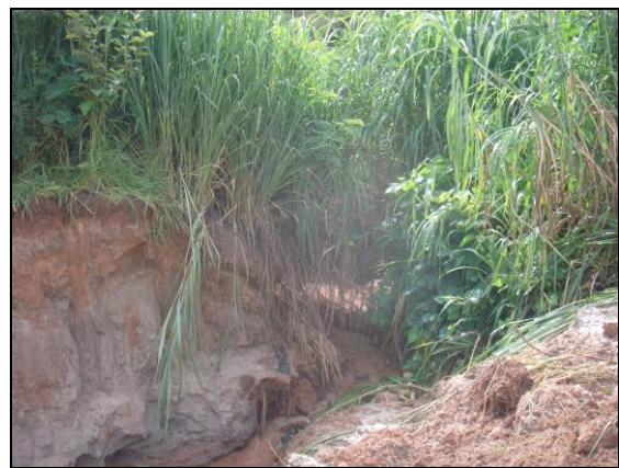
Foto 38- Detalhe do processo erosivo.
