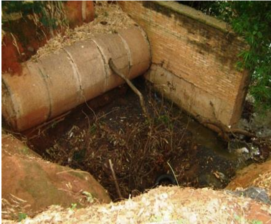
Foto 49 – Tubo de Ø1,20m p/ captação.
