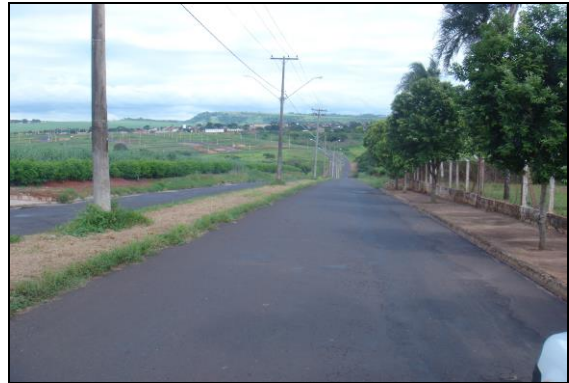
Foto 44- Vista à montante de Av. Paulo Zuppani.
