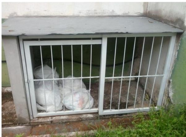
Figura 11.4.12. Armazenamento externo inadequado, sem trancamento e impermeabilização de solo em UBS.
