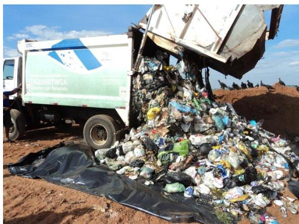
Figura 11.1.1.25. Início do descarregamento dos resíduos sobre a lona plástica.
