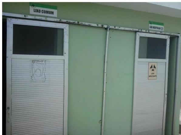
Figura 11.4.9. Armazenamento externo com locais distintos para os grupos de resíduos com diferentes coletas.
