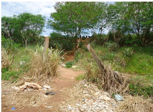
Figura 11.1.6.2.6. Detalhe para cerca danificada permitindo entrada de pessoas não autorizadas.
