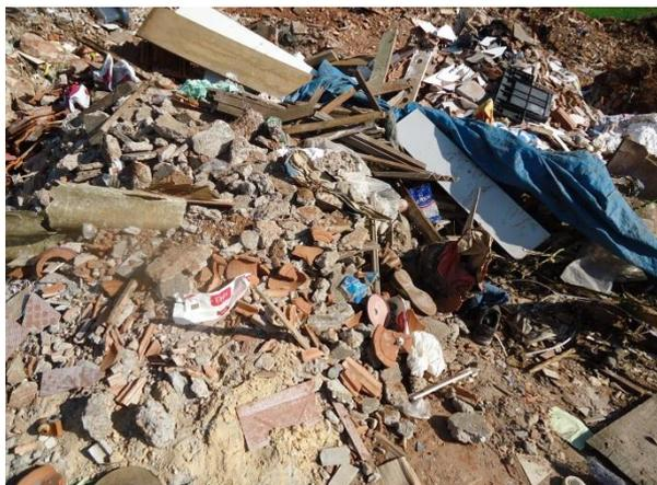
Figura 11.5.22. Detalhe de RCCs sem separação, aumentando o volume.
