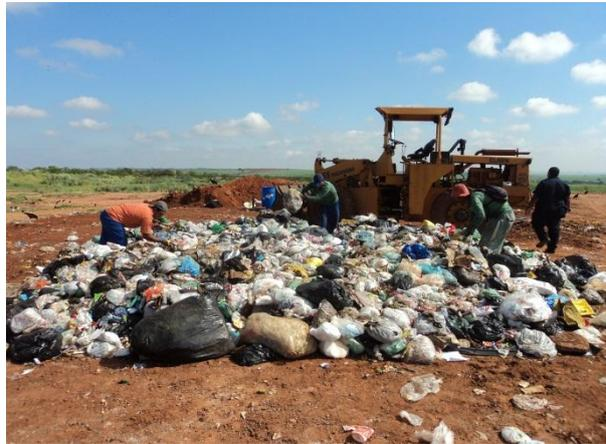
Figura 11.1.1.11. Resíduos espalhados sobre a lona plástica formando massa uniforme.
