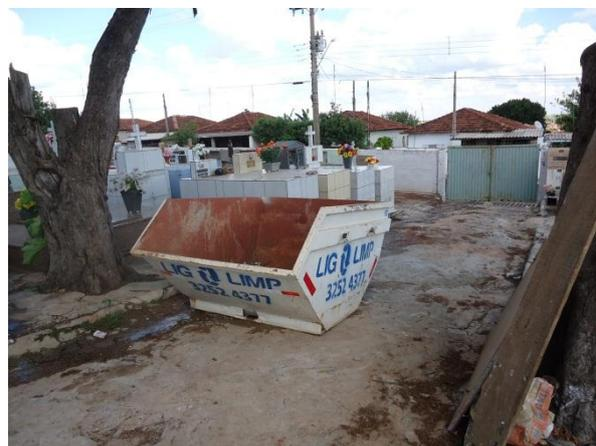
Figura 11.3.9 Caçamba e 3 m<sup>3</sup> que acondiciona os RCC.
