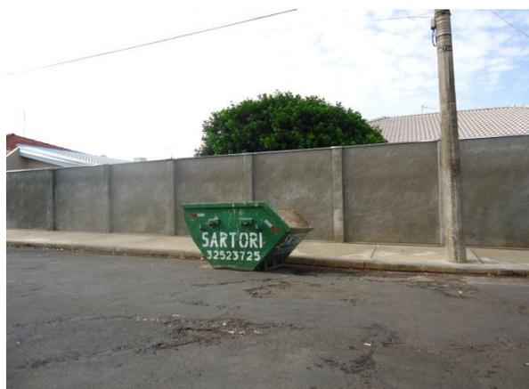
Figura 11.5.1. Acondicionamento dos RCC em caçamba de 3 m<sup>3</sup>.
