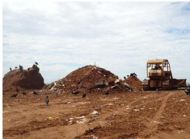
Figura 11.1.6.2.12. Detalhe para solo estocado pra se fazer a cobertura da massa de resíduos.
