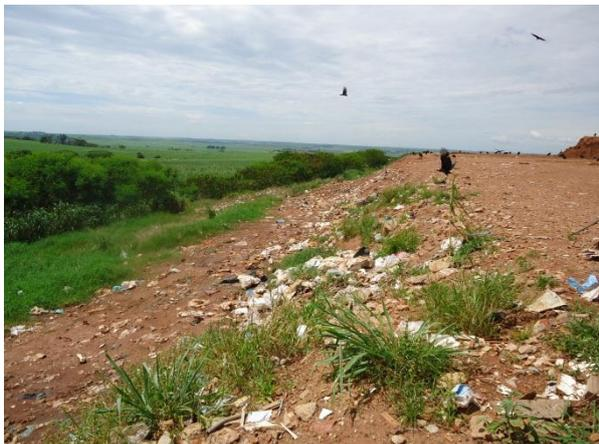
Figura 11.1.6.2.11. Detalhe para cobertura de solo insuficiente no talude.
