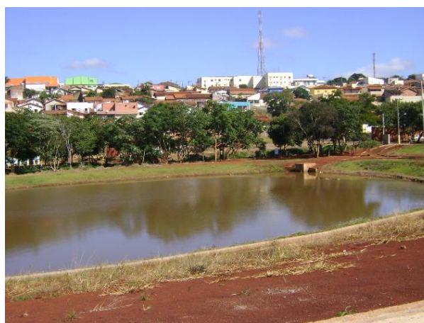
FOTO 4.34 – RESERVATÓRIO DE RETENÇÃO (“PISCINÃO”) DO PARQUE PREFEITO NICANOR CAMARGO
