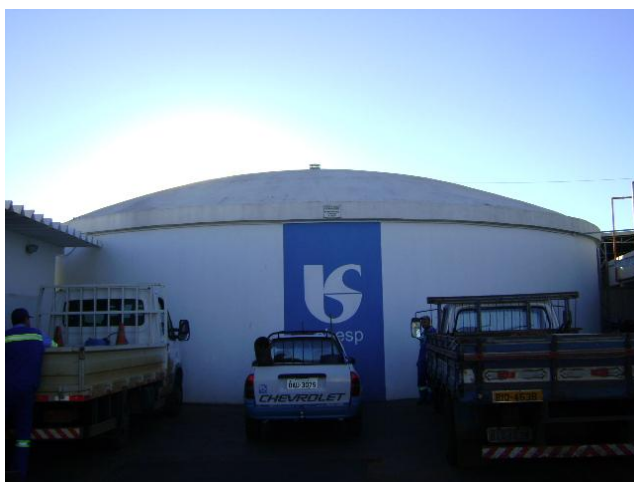
FOTO 4.6 - RESERVATÓRIO APOIADO R1 – LOCALIZADO NA ETA TAQUARITUBA
