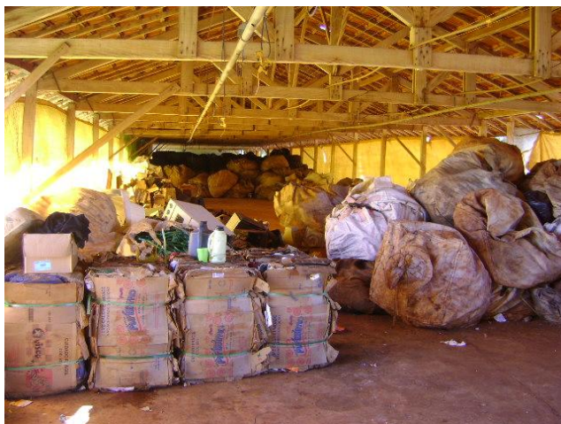
FIGURA 4.26– GALPÃO DE TRIAGEM DE RESÍDUOS SÓLIDOS DA “ASSOCIAÇÃO RECICLAR PARA O FUTURO”
