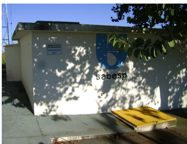
FOTO 4.8 - RESERVATÓRIO APOIADO R3 – LOCALIZADO NO BAIRRO DOS ALEIXOS
