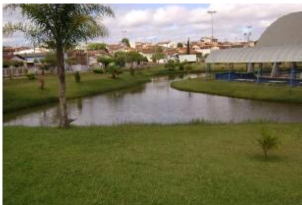
FOTO 4.31 – RESERVATÓRIO DE RETENÇÃO (“PISCINÃO”) DO PARQUE ICO RODRIGUES
