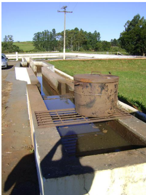
FOTO 4.17 – GRADEAMENTO E CAIXA DE AREIA DA ETE SEDE
