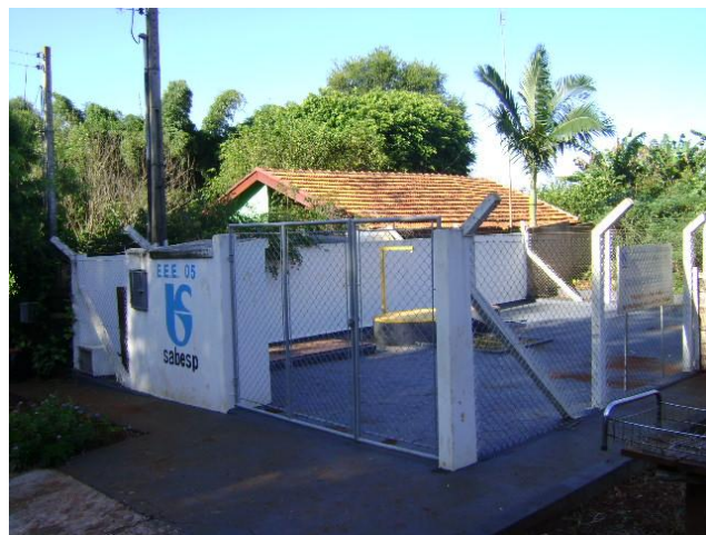
FOTO 4.15 – EEE5 DO SISTEMA SEDE
