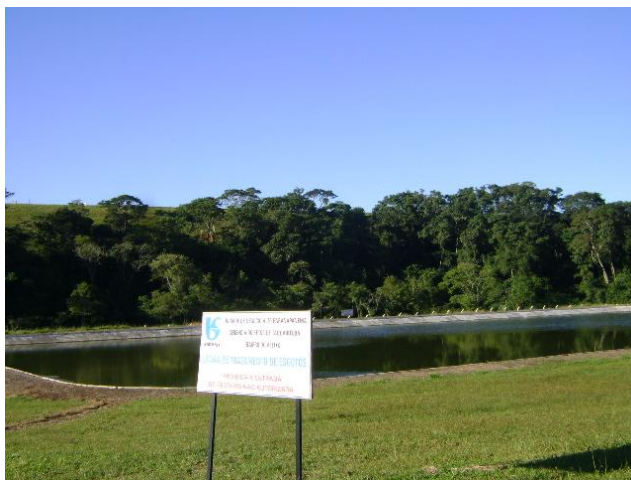
FOTO 4.23 – VISTA DA ETE ALEIXOS
