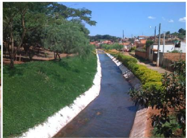
FIGURA 4.30 – RIBEIRÃO LAGEADO CANALIZADO (PMT, 2010)
