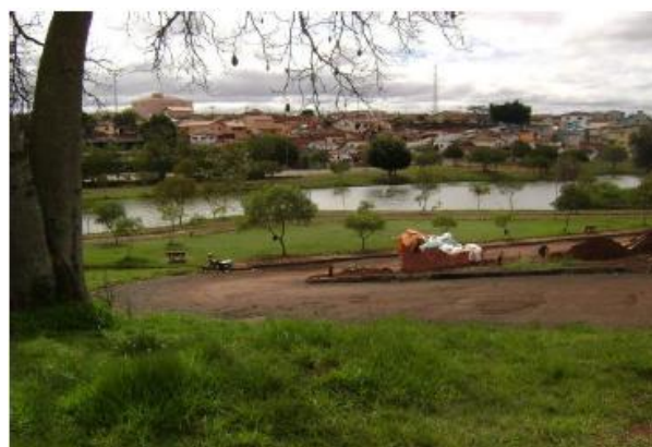
FOTO 4.32 – RESERVATÓRIO DE RETENÇÃO (“PISCINÃO”) DO PARQUE ARNON FIRMINO DE MELO
