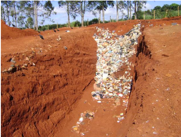
FOTO 4.24 – VALA DO ATERRO SANITÁRIO DE TAQUARITUBA
