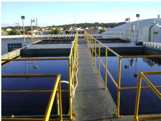
FOTO 4.3 - VISTA DA ETA TAQUARITUBA
