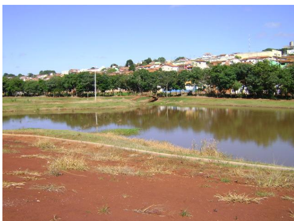
FOTO 4.33 – RESERVATÓRIO DE RETENÇÃO (“PISCINÃO”) DO PARQUE PREFEITO NICANOR CAMARGO
