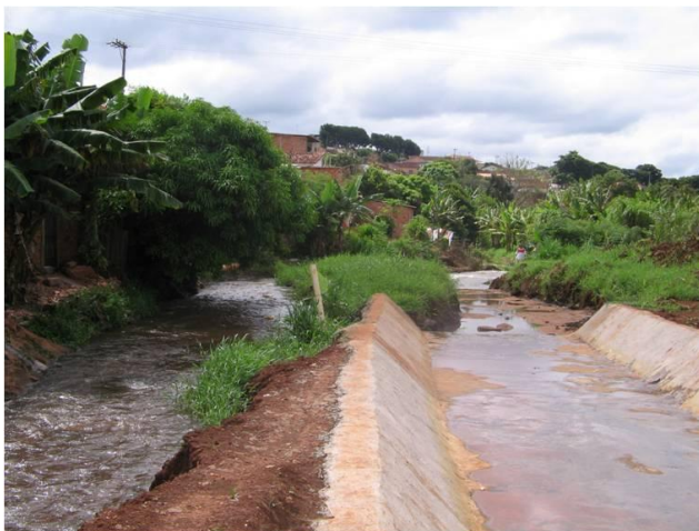
FOTO 4.29 – EXECUÇÃO DA CANALIZAÇÃO DO RIBEIRÃO LAGEADO (PMT, 2010).
