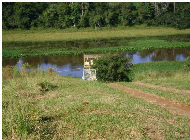
FOTO 4.1 - CAPTAÇÃO NO RIO TAQUARI ATRAVÉS DA EEAB1
