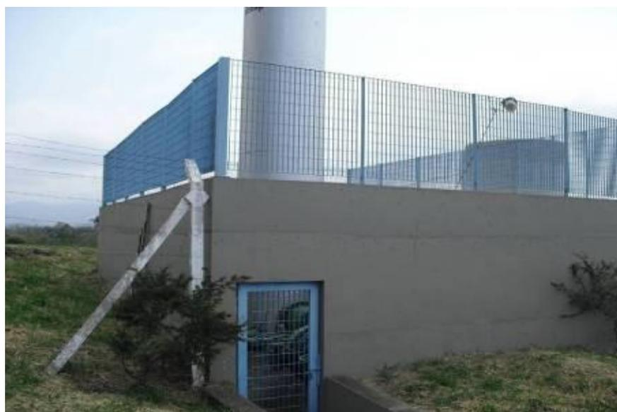
Foto 08 – Tanque de Amortecimento Unidirecional 01 Taubaté - Adutora de Água Bruta Rio Paraíba do Sul.
