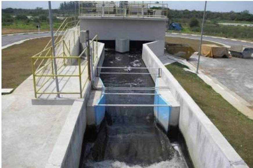
Foto 14 – Medição de Vazão Afluente – Calha Parshall.
