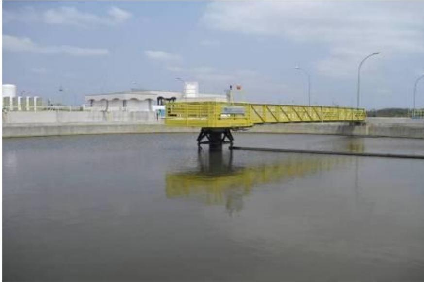
Foto 19 – Decantador com Remoção Mecânica.
