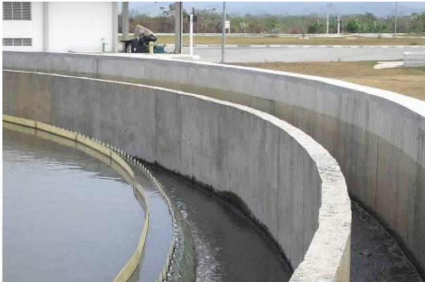
Foto 20 – Canaleta de Coleta do Efluente do Decantador.
