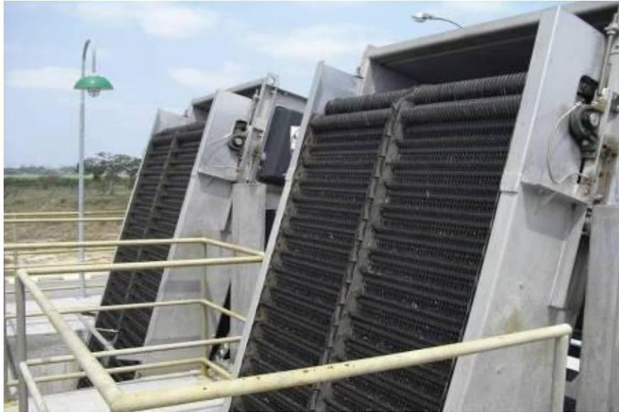
Foto 15 – Gradeamento Mecanizado para Retirada do Material Grosso.
