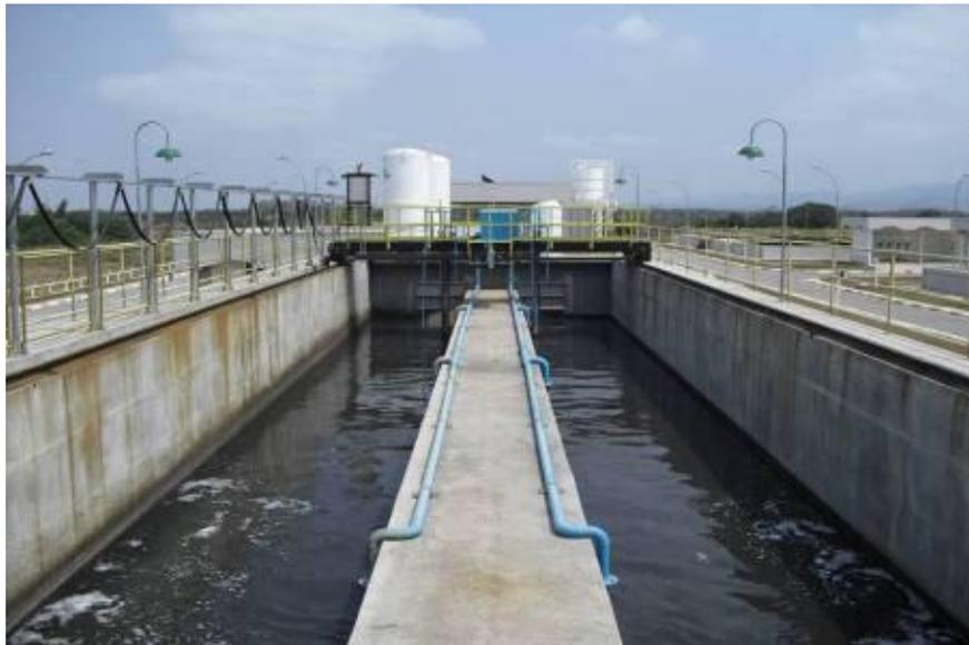
Foto 16 – Caixa de Areia Mecanizada.
