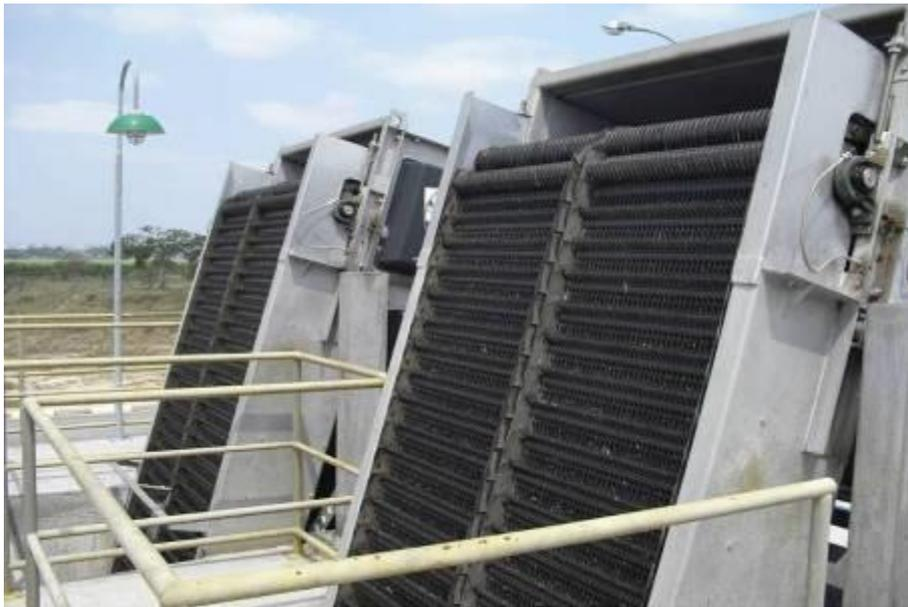
**Foto 15 – Gradeamento Mecanizado para Retirada do Material Grossoiro**
