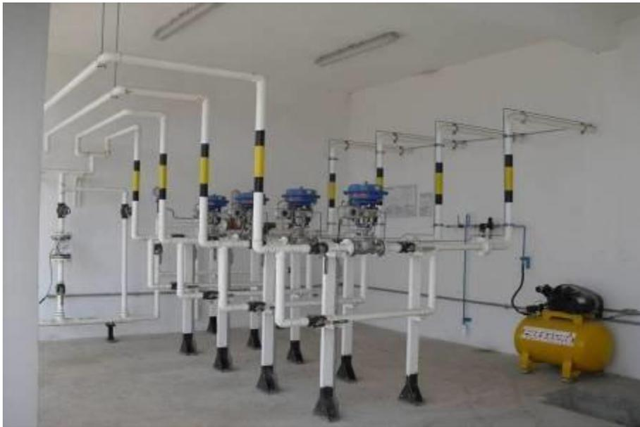
**Foto 17 – Sistema de Injeção de Oxigênio Puro nos Tanques de Aeração**
