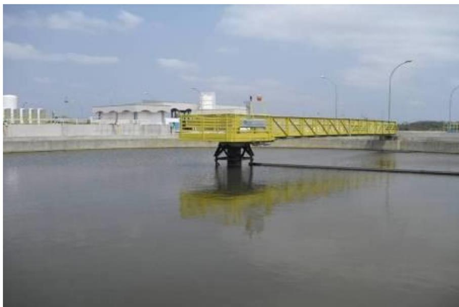
**Foto 19 – Decantador com Remoção Mecânica**
