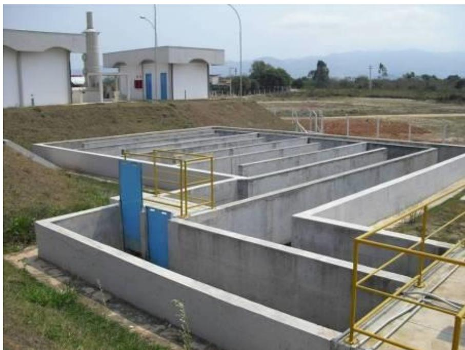
Foto 22 – Tanque de Contato – Desinfecção Final do Efluente
