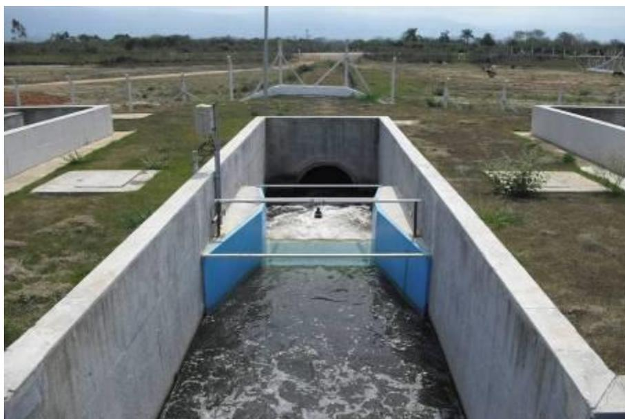
Foto 23 – Medição Final de Vazão e Emissário de Esgoto Tratado
