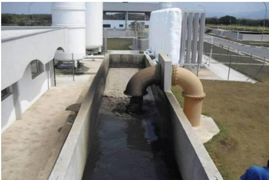
**Foto 21 – Retorno de Lodo para a Entrada dos Tanques de Aeração**
