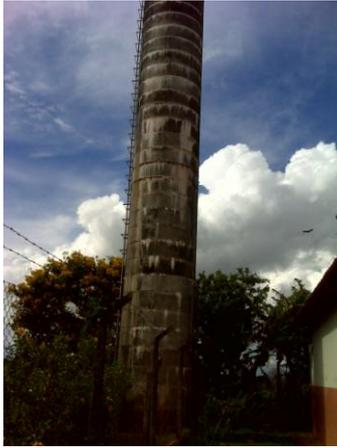
FOTO 4.11 – RESERVATÓRIO R1 ABASTECIDO PELOS POÇOS P1, P2 E P3 DO SISTEMA RIBEIRÃO BONITO
