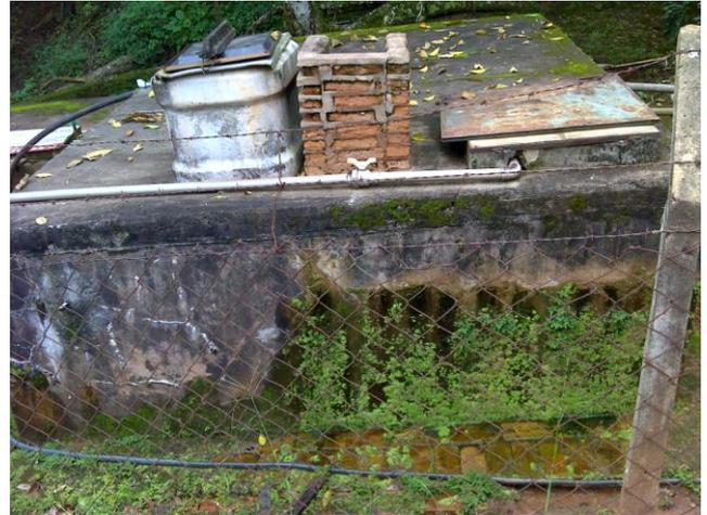
FOTO 4.5 – RESERVATÓRIO R2 ABASTECIDO PELO POÇO P1 E PELOS RESERVATÓRIOS R1 E R4
