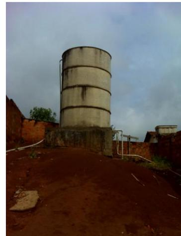
FOTO 4.7 – RESERVATÓRIO R4 ABASTECIDO PELOS POÇOS P1 E P2 E PELO RESERVATÓRIO R3
